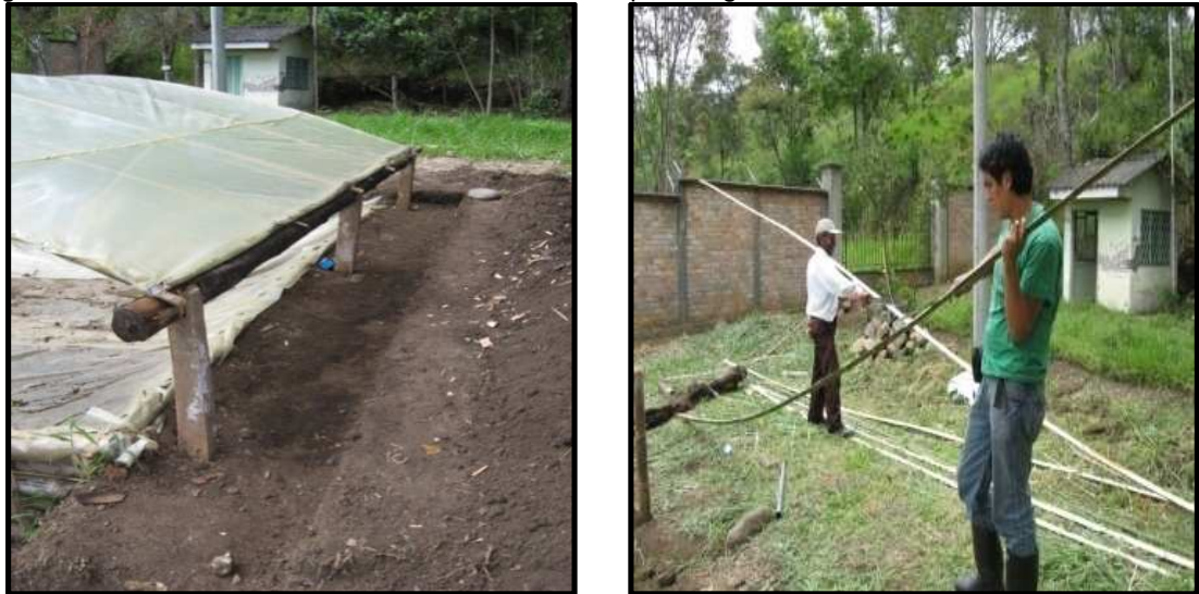
Figura 17. Construcción del techo de la fosa de compost vegetal
