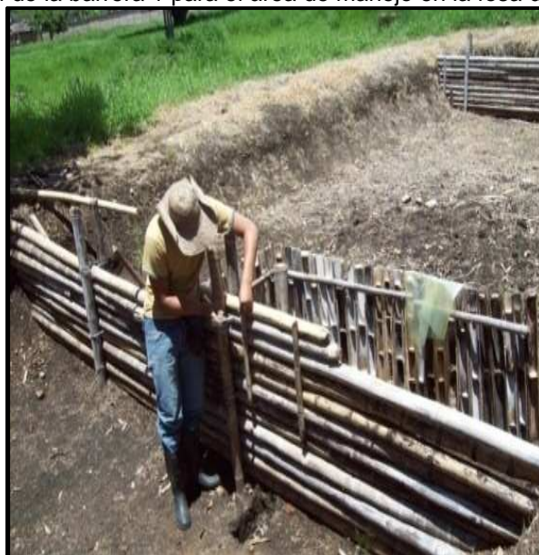
Figura 14. Construcción de la barrera 1 para el área de manejo en la fosa de compost vegetal
