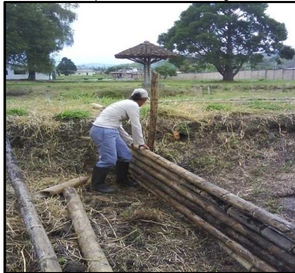
Figura 15. Construcción de la barrera 2 para el área de descargue en la fosa de compost vegetal
