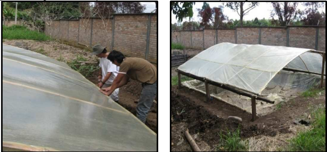
Figura 19. Aseguramiento del plástico del techo de la fosa de compost vegetal
