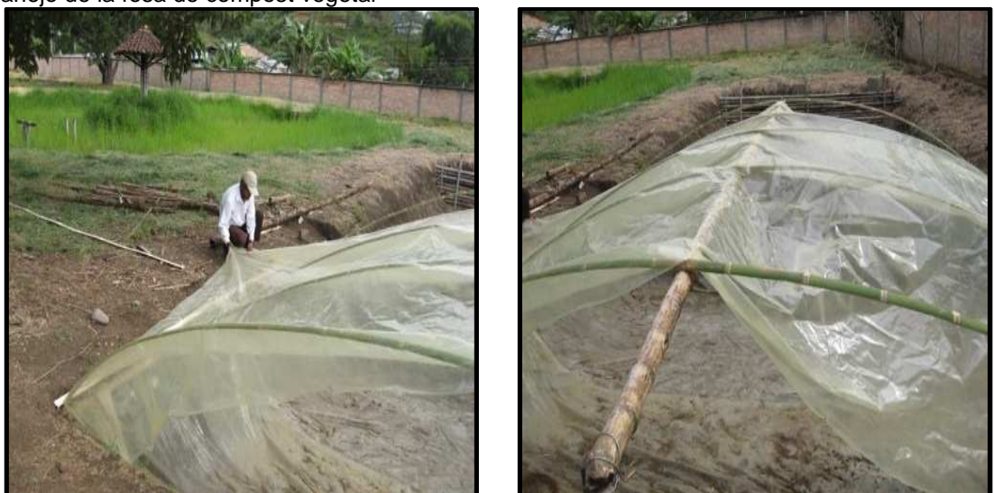
Figura 18. Instalación de las guaduas recortadas para templar el plástico del techo de la sección de manejo de la fosa de compost vegetal
