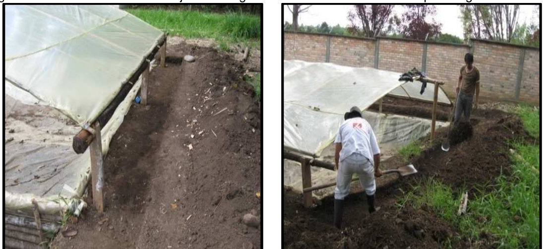
Figura 20. Construcción de la zanja de desagüe alrededor de la fosa de compost vegetal
