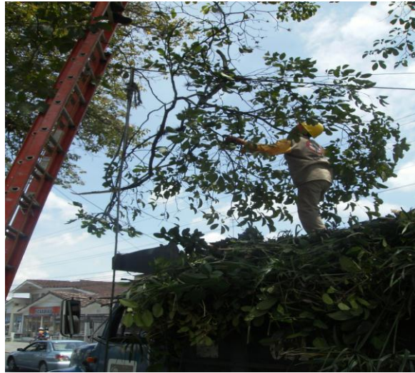
Figura 15. Poda de seguridad en la av. Panamericana frente a Empaques del Cauca
