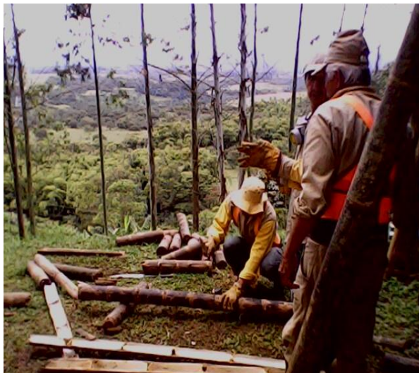
Figura 37. Inmunización de la Guadua en el relleno sanitario
