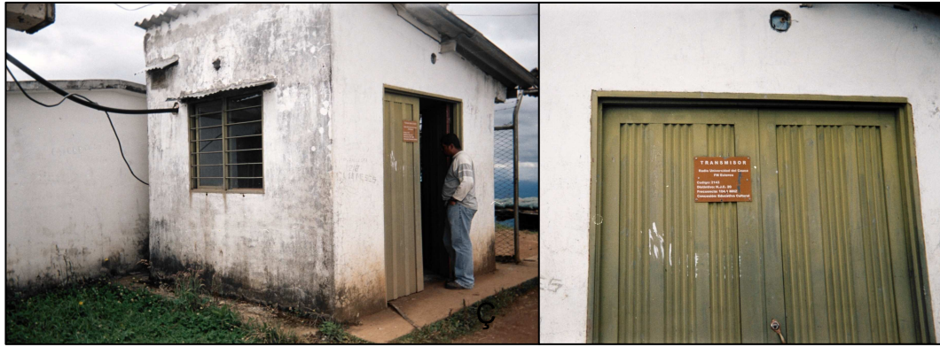
Figura 14. Caseta para la Ubicación de los Equipos
