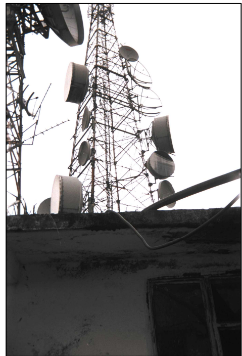
Vista de la Torre desde la Caseta
