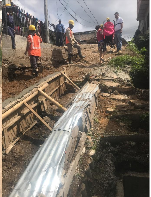
Conformación de terreno para garantizar relleno tipo II con material limo-arcilloso.
