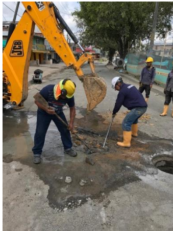
Figura 7. Demolición de pavimento.
