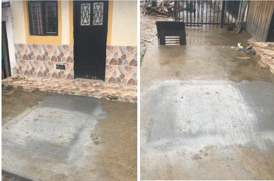
Construcción de cámaras de Inspección concreto de 4000 psi y brocal en concreto de 4000 psi D = 1.5 m.
