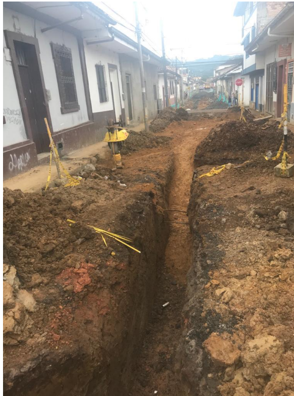
Figura 15. Relleno con material limo-arcilloso.
