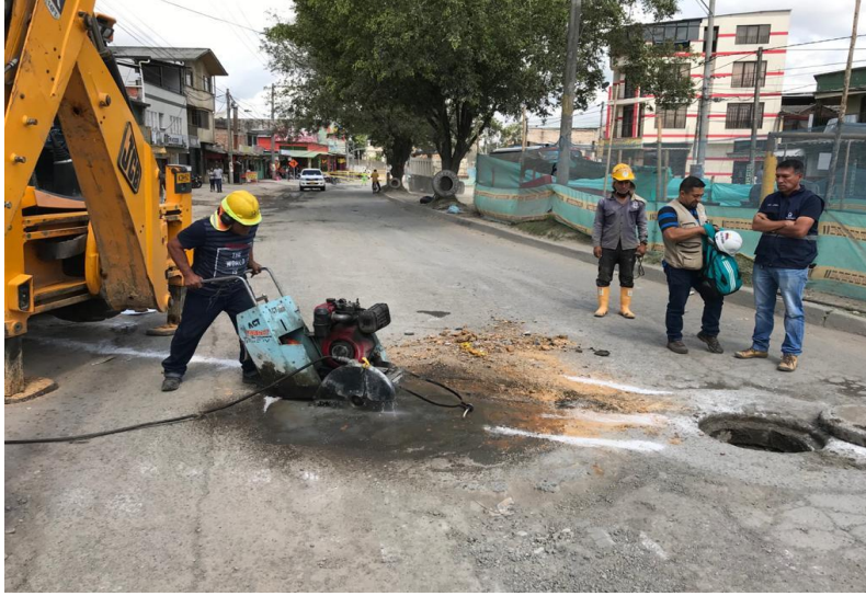
Figura 6. Corte de pavimento.
