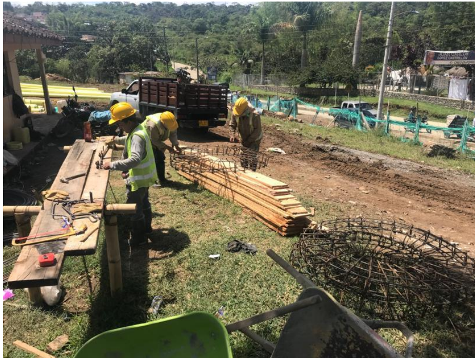
Figura 14. Construcción de tapas de concreto.
