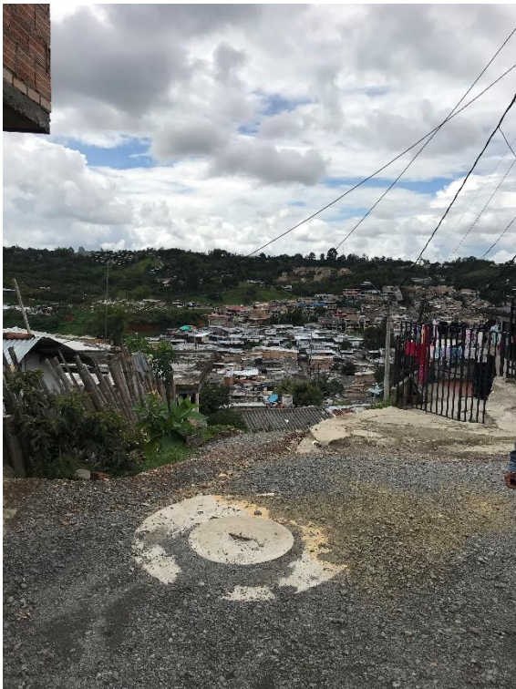
Construcción de cámaras de Inspección concreto de 4000 psi y brocal en concreto de 4000 psi D = 1.5 m.
