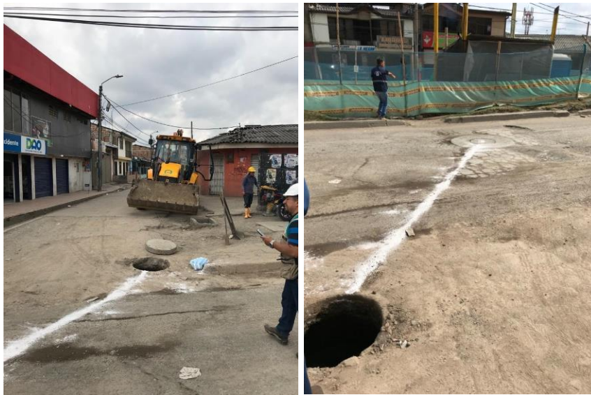
Figura 5. Localización de eje de tubería.
