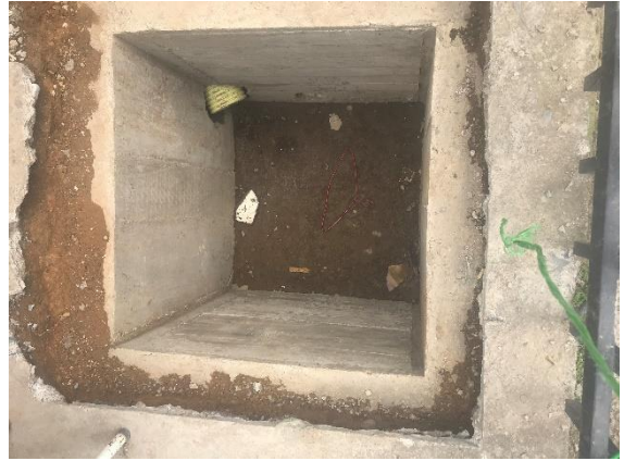
Conformación de terreno para garantizar relleno tipo II con material limo-arcilloso.
