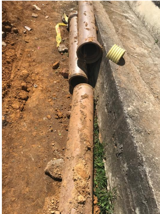
Figura 10. Retiro de tubería.
