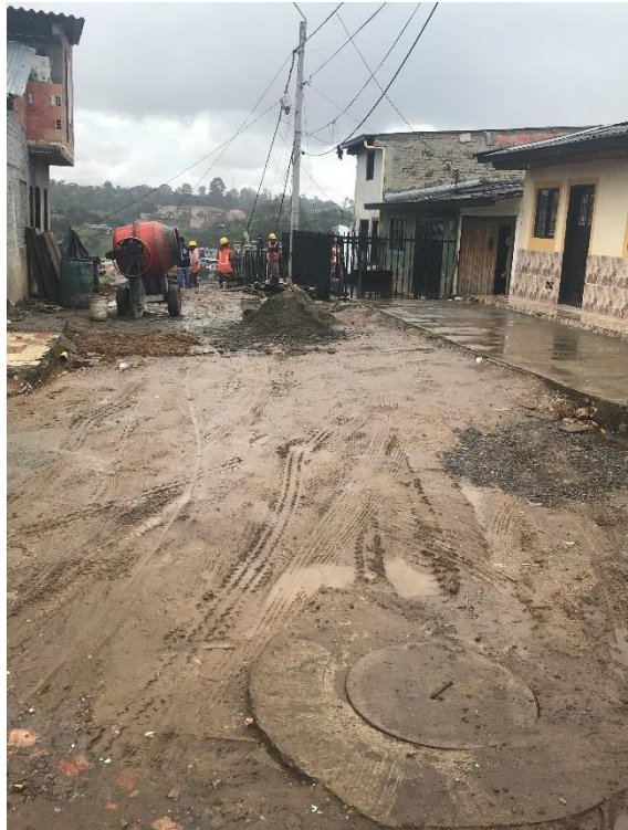
Construcción de cámaras de Inspección concreto de 4000 psi y brocal en concreto de 4000 psi D = 1.5 m.
