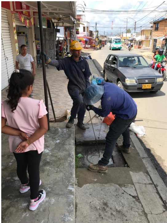
Figura 18. Limpieza de tuberías domiciliarias.
