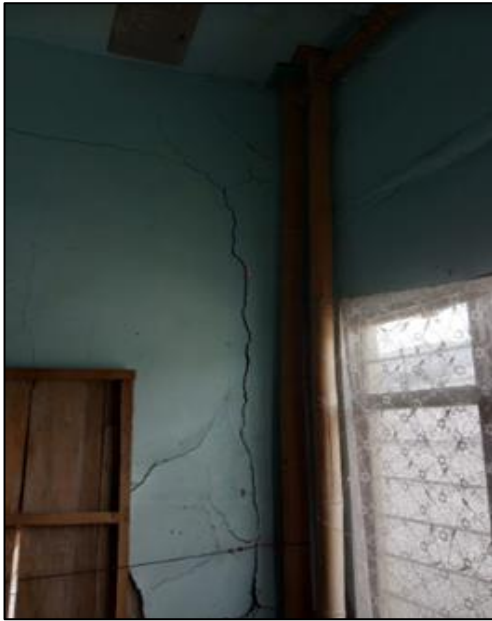
Figura 11 Pórticos de guadua improvisados (Fuente: Propia)
