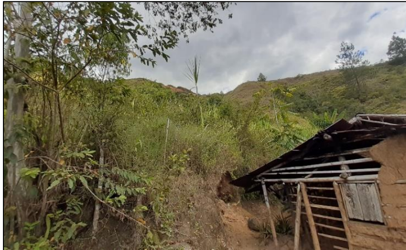
Figura 9 Vivienda expuesta, ubicada en la parte baja del talud (Fuente: Propia)
