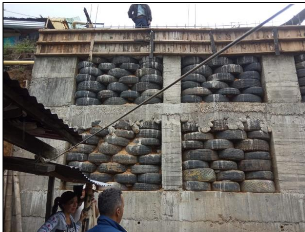
Figura 13 Muro de contención utilizando llantas (Fuente: Propia)
