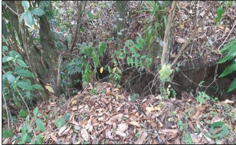
Figura 8 Grietas sobre el terreno (Fuente: Propia)
