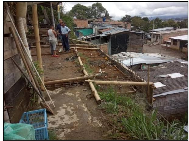
Figura 14 Parte superior del muro (Fuente: Propia)
