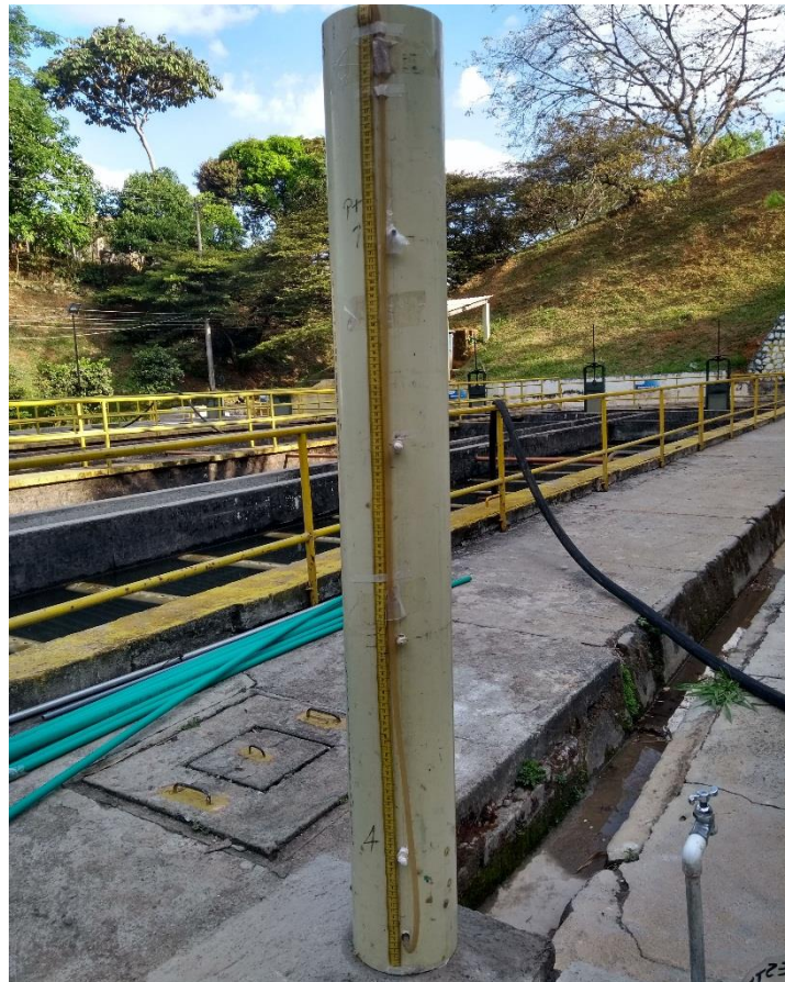
Figura 7. Columna de sedimentación. PTAP El Arroyo - 12 de Agosto de 2019.
