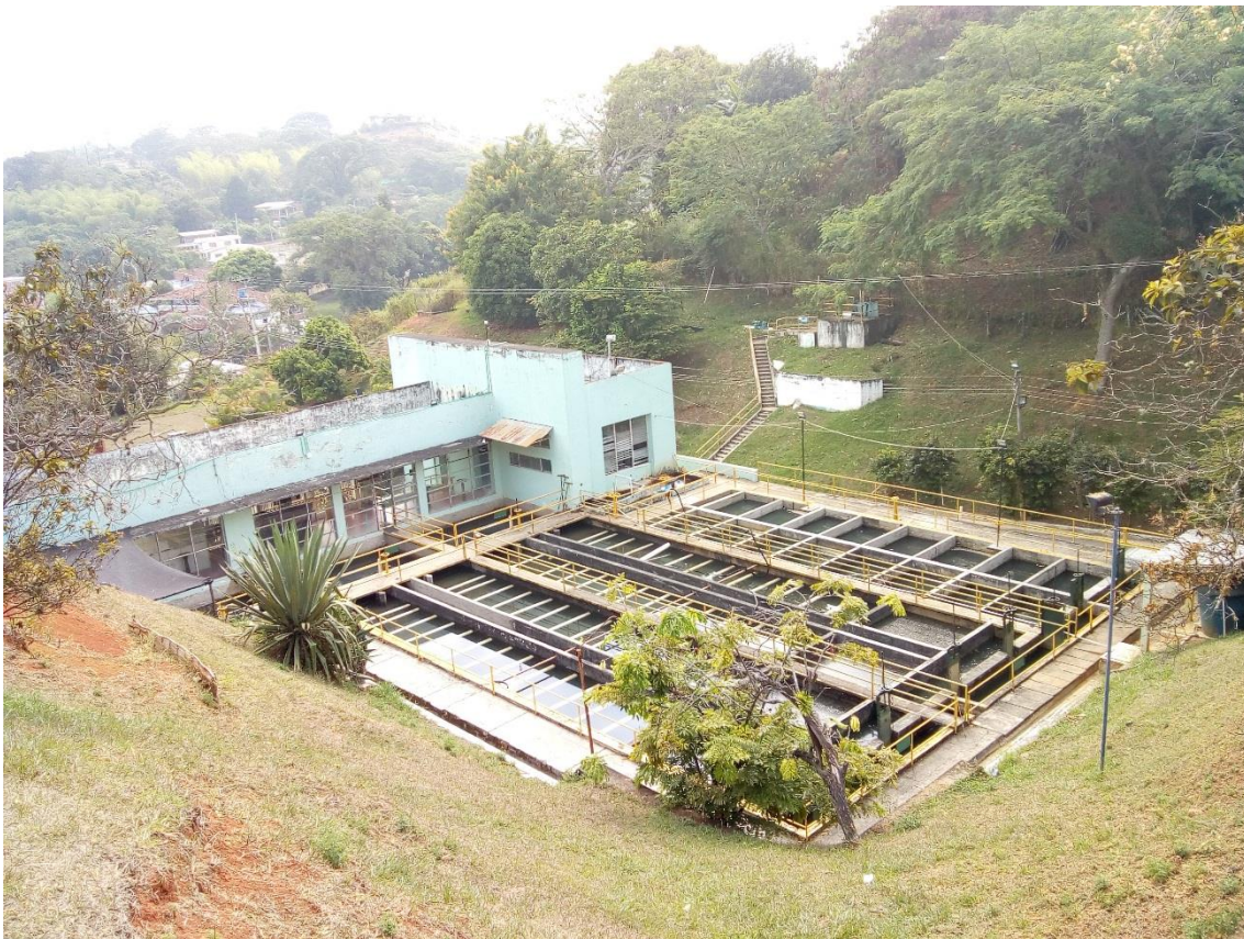
Figura 1. Planta de Tratamiento de Agua Potable El Arroyo.
