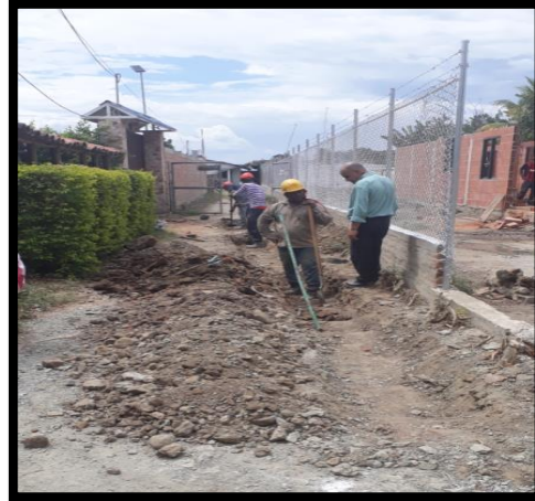
Ilustración 100 Excavación para tubería principal callejón Gallera. Fuente: Propia
