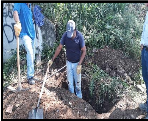
Ilustración 9 Excavación para encontrar la línea de tubería existente Fuente: Propia
