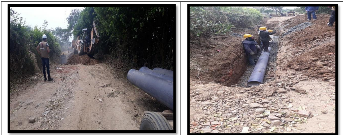
Ilustración 25 Instalación tubería de la línea de impulsión (420ml) Fuente: Propia
