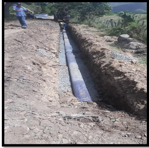
Ilustración 22 Continuación de instalación de tubería de la línea de conducción Fuente: Propia
