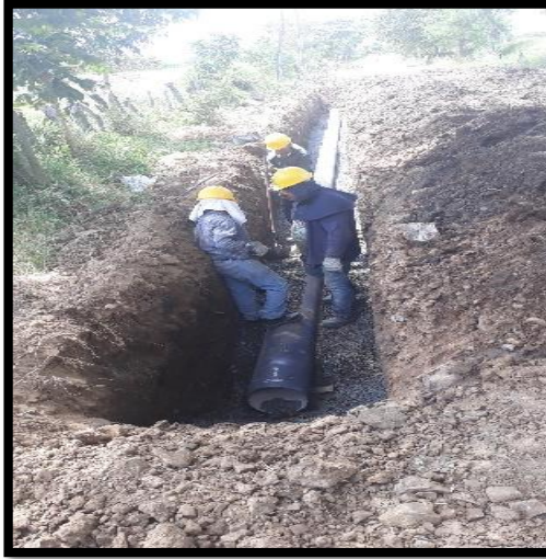
Ilustración 22 Continuación de instalación de tubería de la línea de conducción Fuente: Propia
