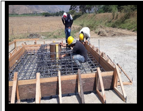
Ilustración 41 Nivelación de la losa Fuente: Propia
