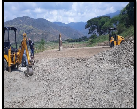
Ilustración 20 Avance en la conformación de la plataforma. Fuente: Propia
