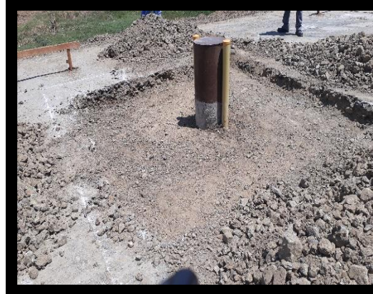
Ilustración 33 Excavación para losa de la caseta de la estación de bombeo.
