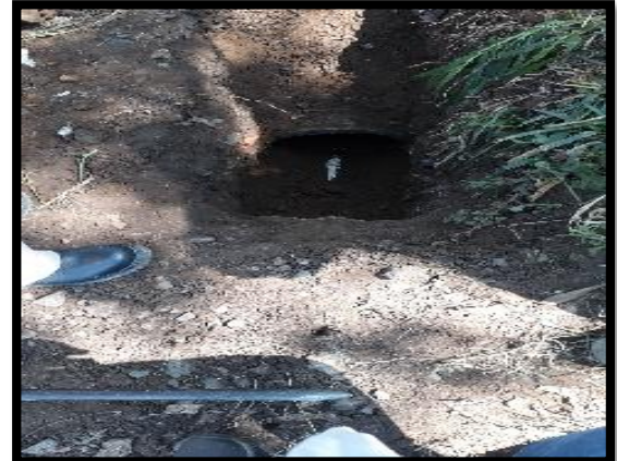
Ilustración 9 Excavación para encontrar la línea de tubería existente Fuente: Propia
