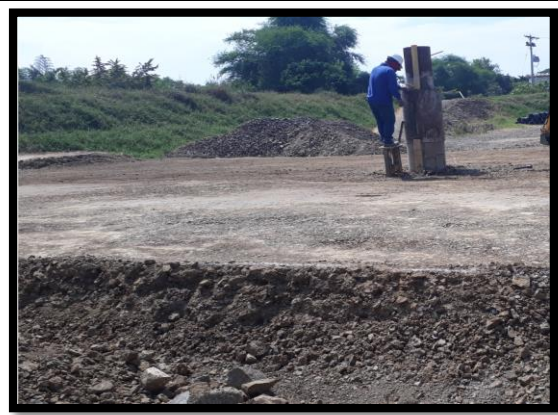
Ilustración 21 Cubrimiento con concreto del pozo Fuente: Propia
