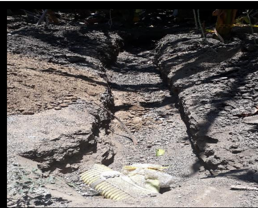
Ilustración 90 Excavación tubería principal callejón Palacios Fuente: Propia
