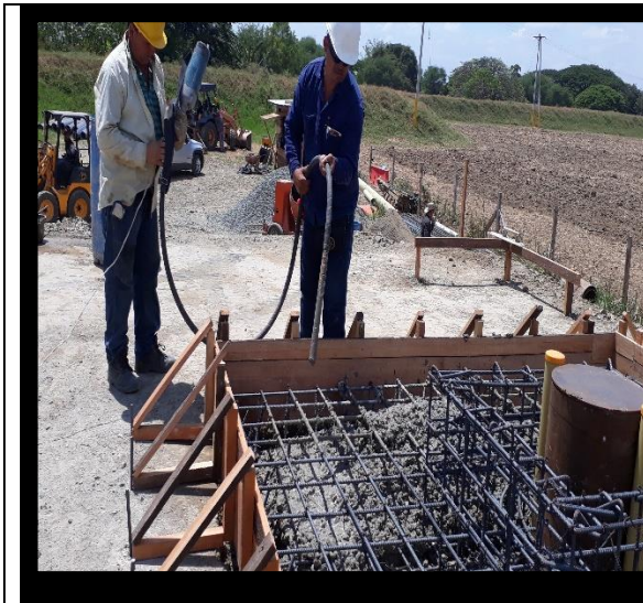
Ilustración 45 Proceso de vibrado del concreto Fuente: Propia
