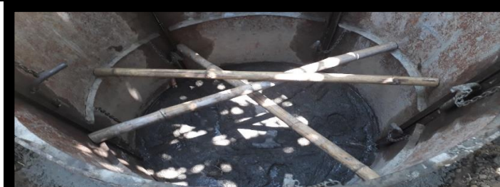
Ilustración 92 Fundición cámara callejón palacios Fuente: Propia
