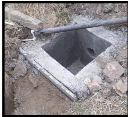
Ilustración 98 Cajas domiciliarias del Callejón Rojas. Fuente: Propia
