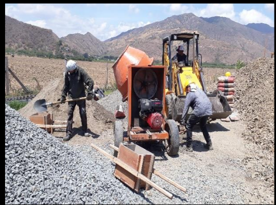
Ilustración 42 Proceso de dosificación y mezcla del concreto Fuente: Propia
