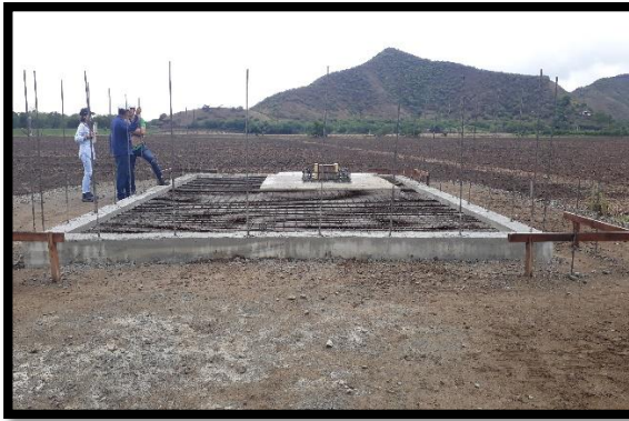
Ilustración 52 Armado de acero de refuerzo losa caseta. Fuente: Propia
