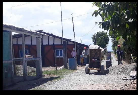
Ilustración 89 Inicio de obra en el callejón Palacios Fuente: Propia
