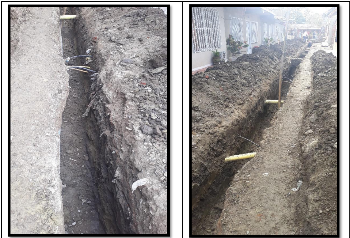
Ilustración 77 Excavación para la instalación de la tubería de alcantarillado en el Callejón Chará.
