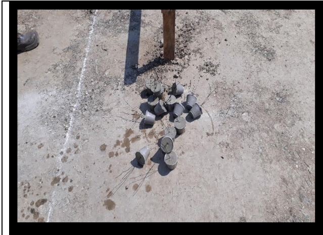
Ilustración 39 Paneles de cemento para garantizar el recubrimiento Fuente: Propia
