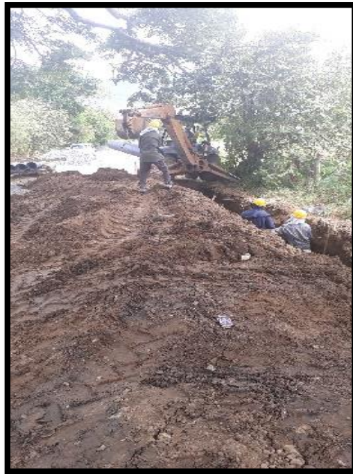
Ilustración 23 Excavación e instalación tubería línea de conducción Fuente: Propia
