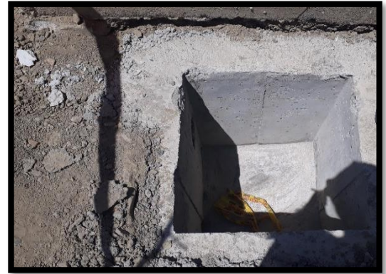
Ilustración 84 Cajas domiciliarias fundidas en el callejón Chará Fuente: Propia
