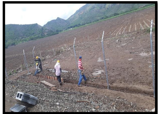
Ilustración 61 Construcción cerramiento. Fuente: Propia
