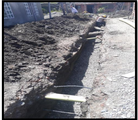
Ilustración 79 Colocación de la grava para la instalación de la tubería de alcantarillado en el Callejón Chará. Fuente: Propia
