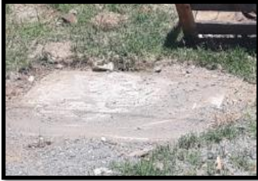
Ilustración 110 Caja domiciliaria terminada Callejón Gallera Fuente: Propia
