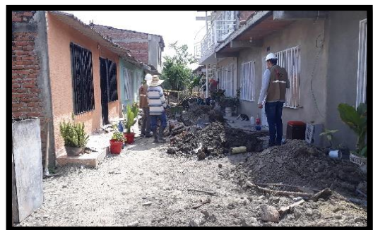
Ilustración 81 Estado de avance de obra callejón Chará Fuente: Propia
