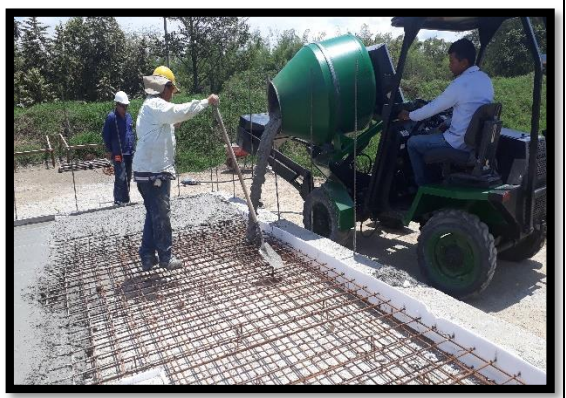
Ilustración 55 Vaciado de concreto de la losa. Fuente: Propia
