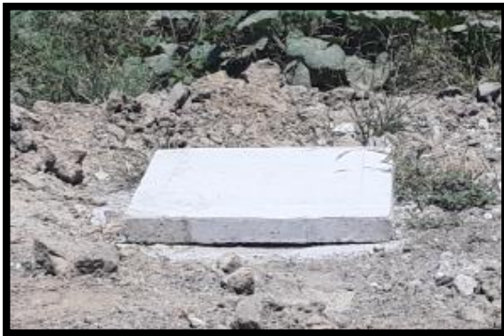
Ilustración 106 Caja domiciliaria terminada Callejón Rojas. Fuente: Propia
