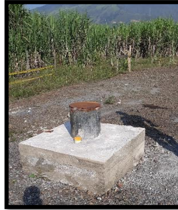
Ilustración 8 Pozo nuevo en el municipio de Vijos Fuente: Propia
