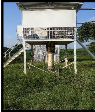
Ilustración 7 Pozo existente en el municipio de Vijos Fuente: Propia
