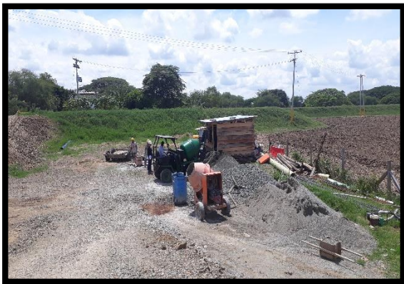
Ilustración 54 Cargue de material para la fundición de la losa. Fuente: Propia
