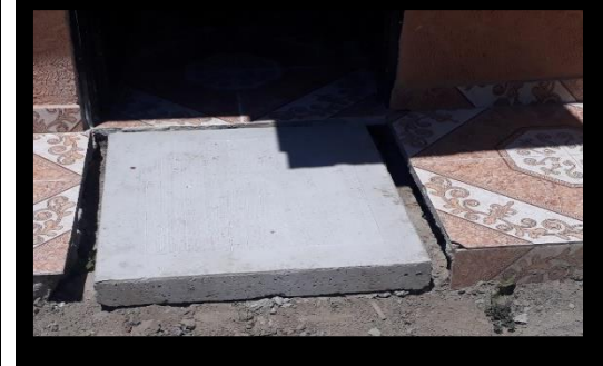
Ilustración 85 Cajas domiciliarias fundidas con su respectiva tapa en el callejón Chará Fuente: Propia
