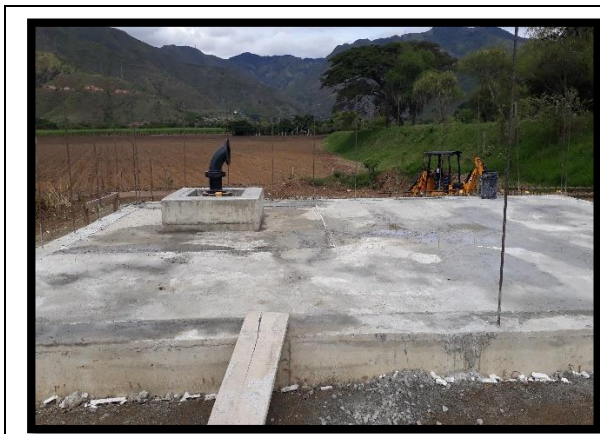
Ilustración 57 Losa de la caseta terminada. Fuente: Propia
