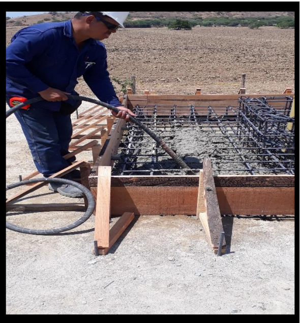
Ilustración 44 Proceso de vibrado del concreto Fuente: Propia
