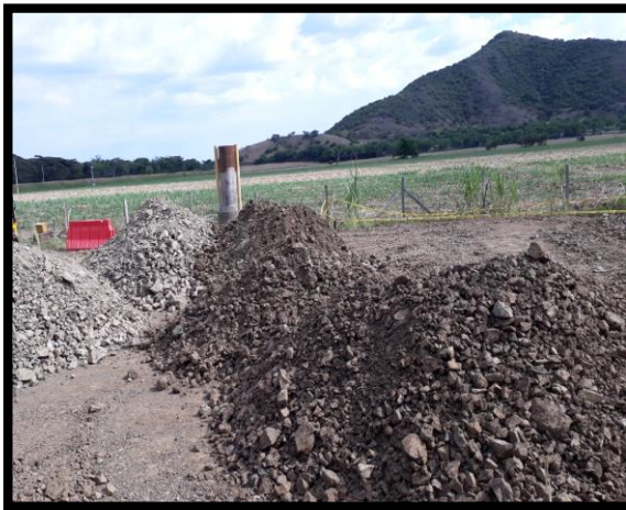
Ilustración 15 Material de conformación de la plataforma para la estación de bombeo Fuente: Propia
