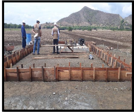
Ilustración 49 Armado de acero y formaleta de viga de cimentación Fuente: Propia
