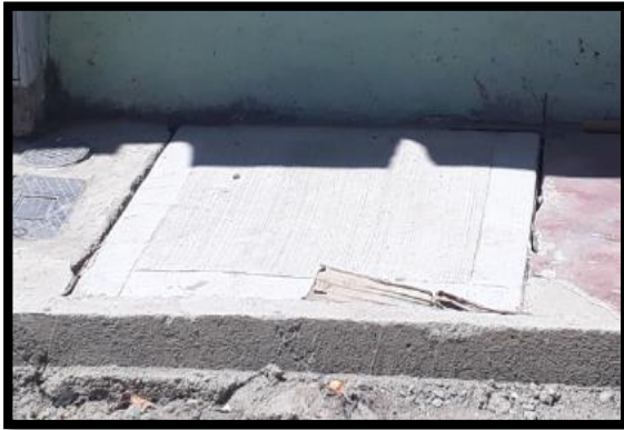
Ilustración 119 Cajas domiciliarias terminadas Callejón Chará Fuente: Propia
