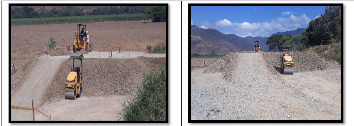
Ilustración 30 Conformación y compactación de la plataforma de relleno terminada.
