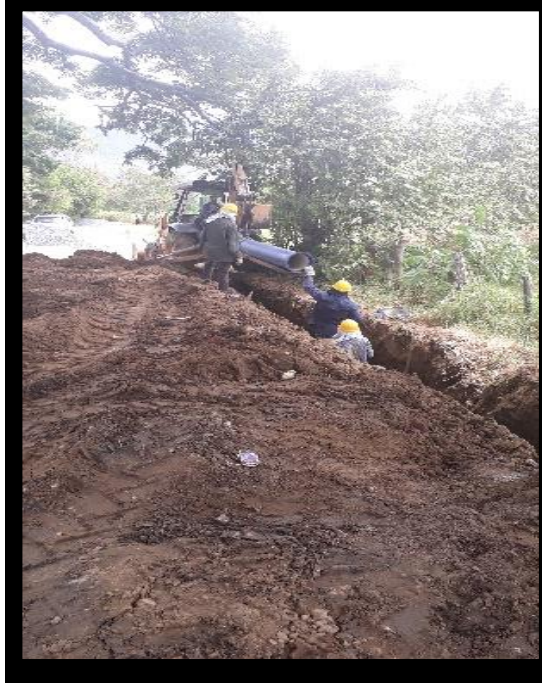
Ilustración 23 Excavación e instalación tubería línea de conducción Fuente: Propia
