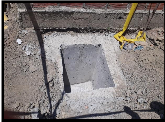
Ilustración 84 Cajas domiciliarias fundidas en el callejón Chará Fuente: Propia
