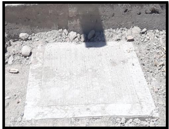
Ilustración 117 Caja domiciliaria terminada Callejón Chará Fuente: Propia
