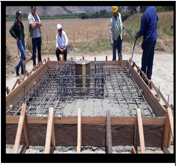
Ilustración 45 Proceso de vibrado del concreto Fuente: Propia
