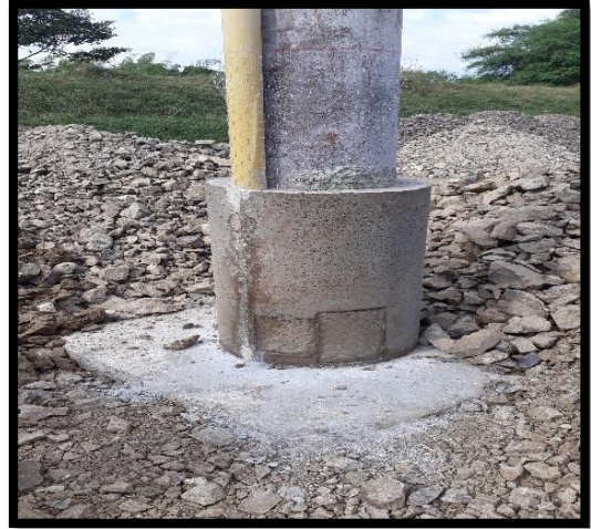
Ilustración 14 Cubrimiento tubería pozo Fuente: Propia
