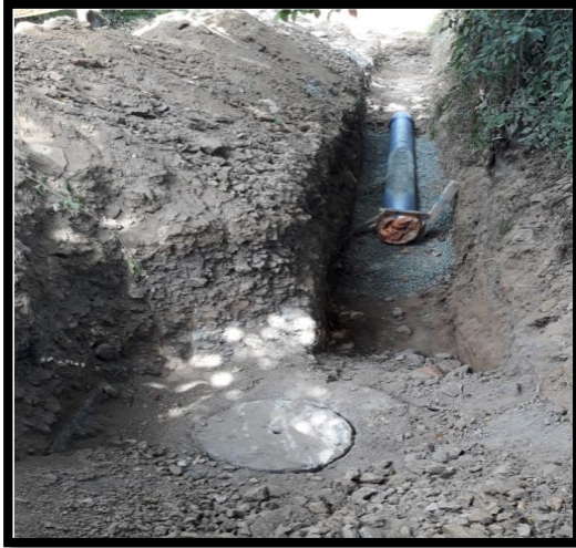
Ilustración 13 Excavación e instalación tubería de la línea de impulsión Fuente: Propia
