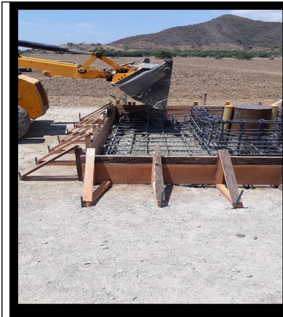
Ilustración 43 Proceso de vaciado del concreto Fuente: Propia
