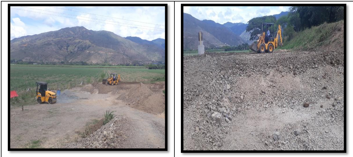
Ilustración 24 Conformación y compactación de las capas de la plataforma para la estación de bombeo Fuente: Propia
