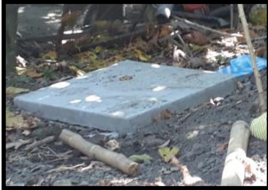
Ilustración 114 Caja domiciliaria terminada Callejón Palacios Fuente: Propia
