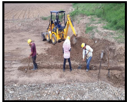
Ilustración 58 Proceso de excavación para cerramiento. Fuente: Propia
