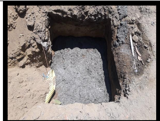
Ilustración 91 Excavación cajas domiciliarias e inicio de proceso de fundición Fuente: Propia
