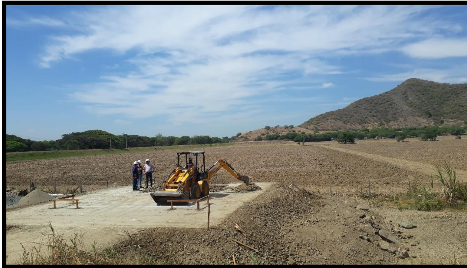
Ilustración 32 Excavación para losa de la caseta de la estación de bombeo.
