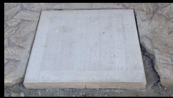
Ilustración 85 Cajas domiciliarias fundidas con su respectiva tapa en el callejón Chará Fuente: Propia
