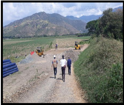
Ilustración 19 Sitio de conformación plataforma. Fuente: Propia
