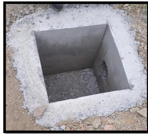
Ilustración 98 Cajas domiciliarias del Callejón Rojas. Fuente: Propia
