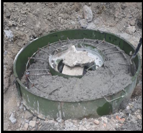
Ilustración 99 Proceso de fundición cámara callejón Rojas. Fuente: Propia
