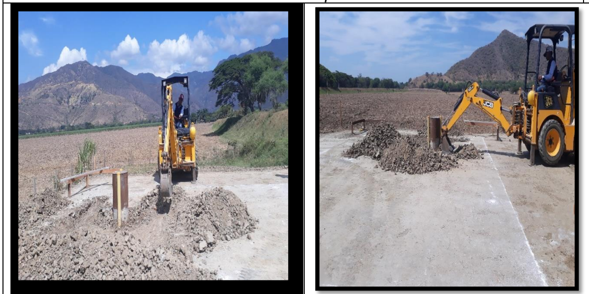
Ilustración 31 Excavación para losa de la caseta de la estación de bombeo.
