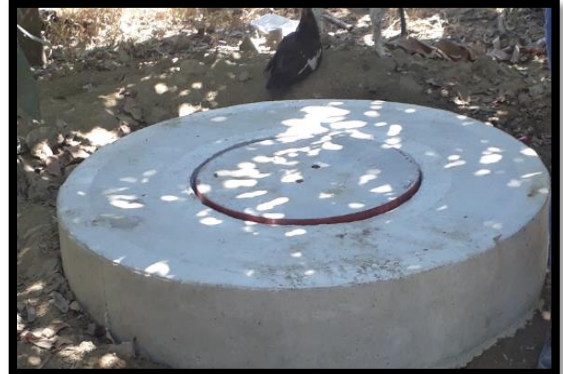
Ilustración 115 Cámara terminada Callejón Palacios Fuente: Propia
