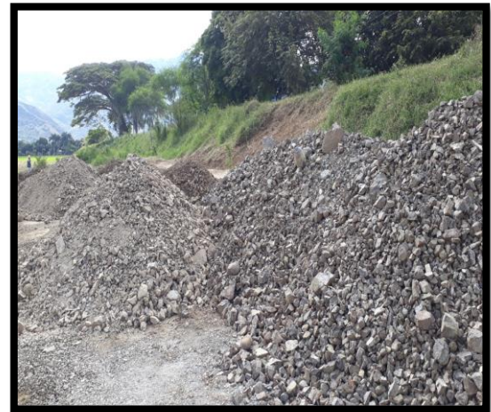
Ilustración 15 Material de conformación de la plataforma para la estación de bombeo Fuente: Propia
