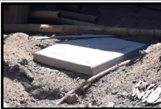
Ilustración 113 Cajas domiciliarias terminadas Callejón Palacios Fuente: Propia
