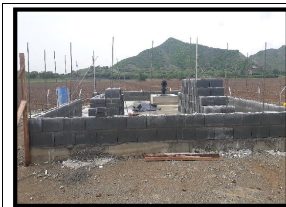
Ilustración 60 Construcción muros de la caseta. Fuente: Propia
