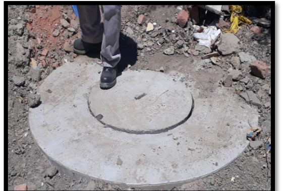
Ilustración 121 Cámara terminada Callejón Chará Fuente: Propia
