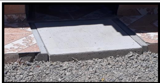
Ilustración 118 Cajas domiciliarias terminadas Callejón Chará Fuente: Propia
