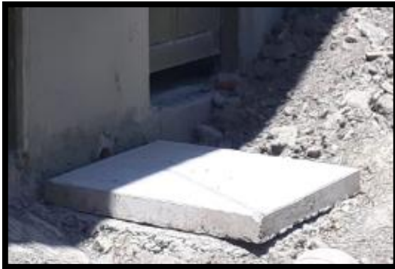
Ilustración 120 Caja domiciliaria terminada Callejón Chará Fuente: Propia
