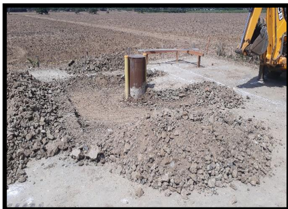
Ilustración 33 Excavación para losa de la caseta de la estación de bombeo.
