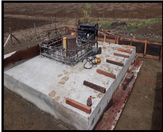
Ilustración 48 Losa alrededor del pozo fundida Fuente: Propia
