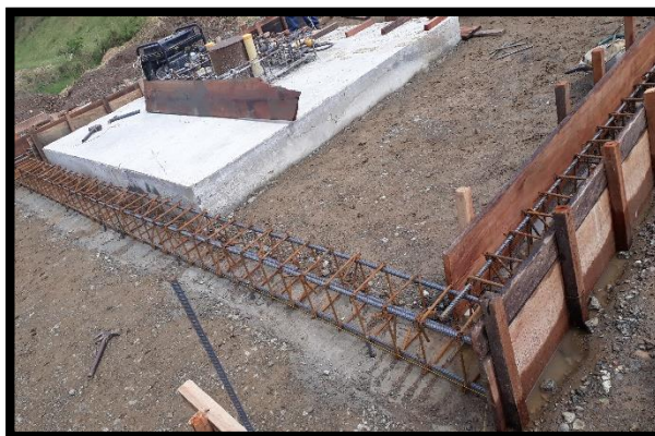
Ilustración 50 Armado de acero y formaleta de viga de cimentación Fuente: Propia
