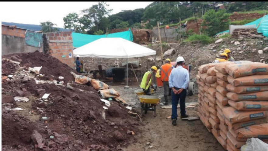
Ilustración 18 "Sitio de obra puente Sangoyaco" Fuente: propia
