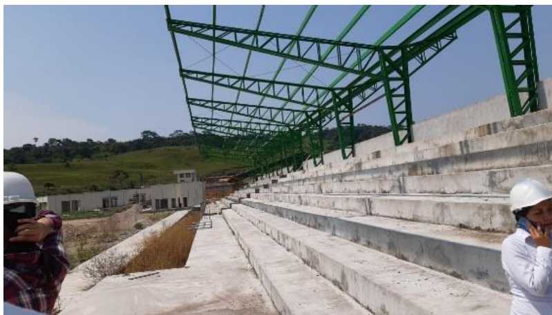
Ilustración 58 "Graderías cancha de futbol" Fuente: propia
