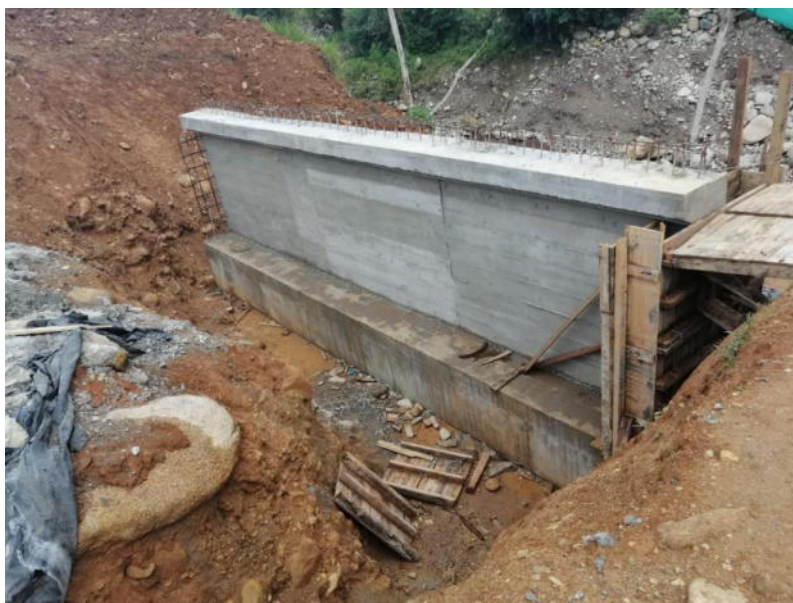
Ilustración 22 "construcción del estribo del puente primera visita"
