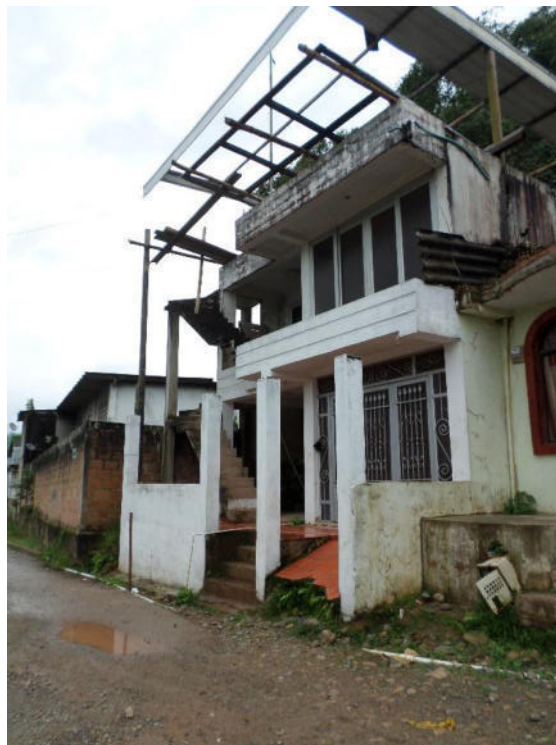
Ilustración 30 "muro visto de la parte posterior" Fuente: propia
