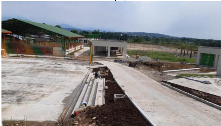
Ilustración 55 "Vista general centro deportivo y recreativo del bajo putumayo"
