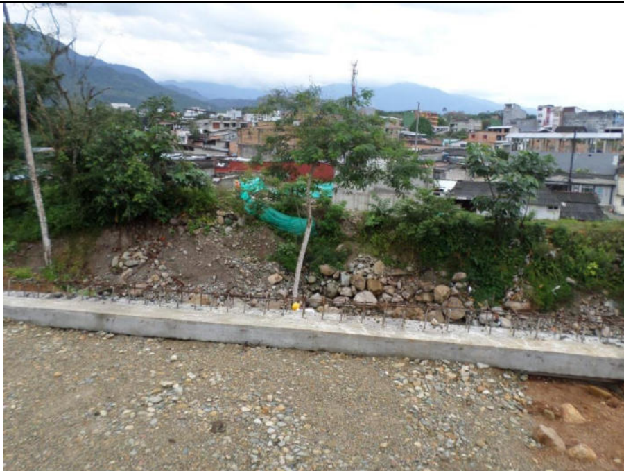
Ilustración 24 "estribo del puente con relleno" Fuente: propia
