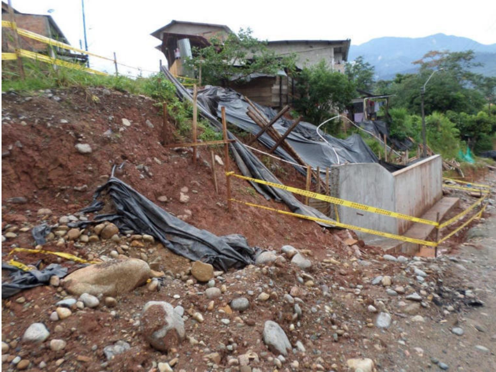
Ilustración 28 "muro de contención para la estabilidad del terreno de las viviendas"
