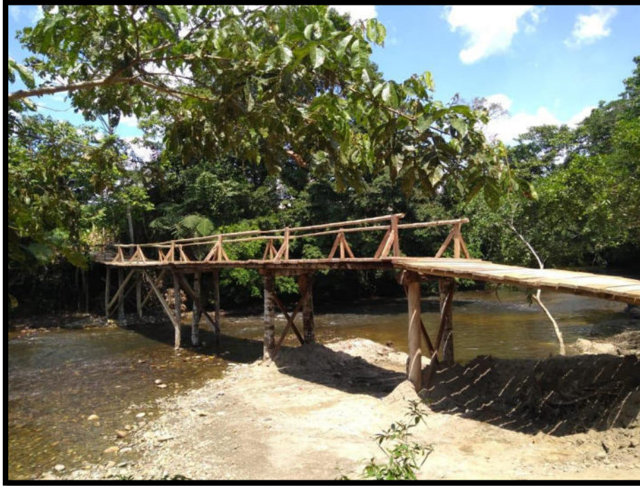
Ilustración 8 "puente provisional en el Rio El Afilador" Fuente: Informe de interventoría No 01 del proyecto
