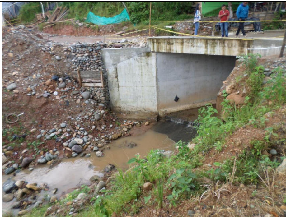
Ilustración 21 "construcción del box culvert"
