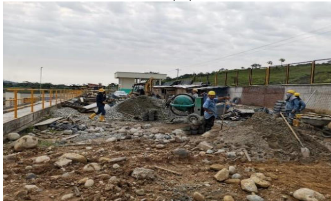
Ilustración 54 "Trabajos realizados de pavimentación centro deportivo y recreativo bajo putumayo"
