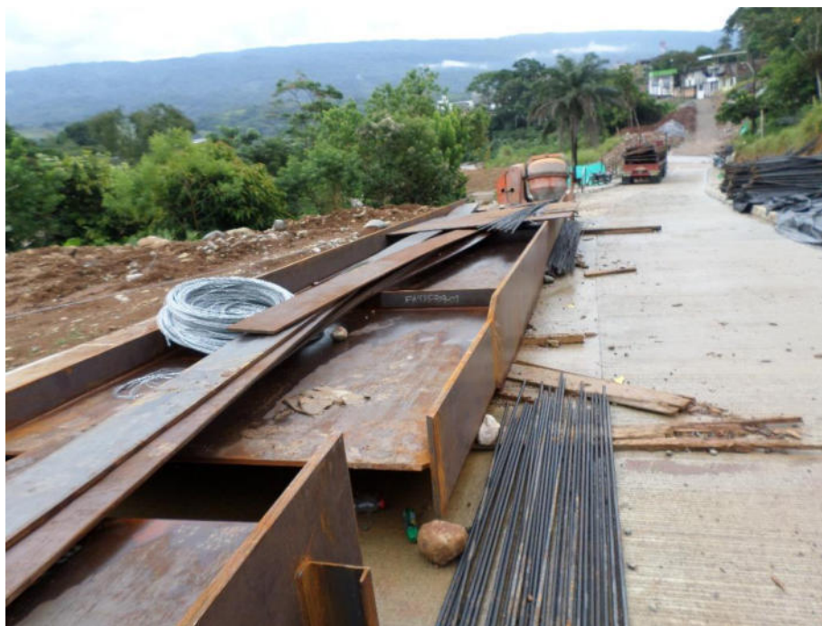
Ilustración 23 "Vigas listas para ensamblaje" Fuente: propia
