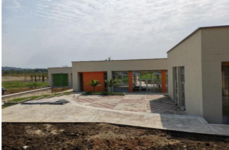
Ilustración 56 "Salón múltiple CDR" Fuente: propia
