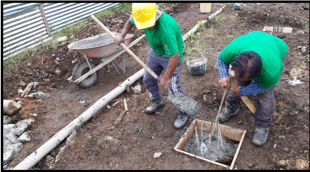
Fotografía 24. Fundición de cajones para nivelar pilotes.
