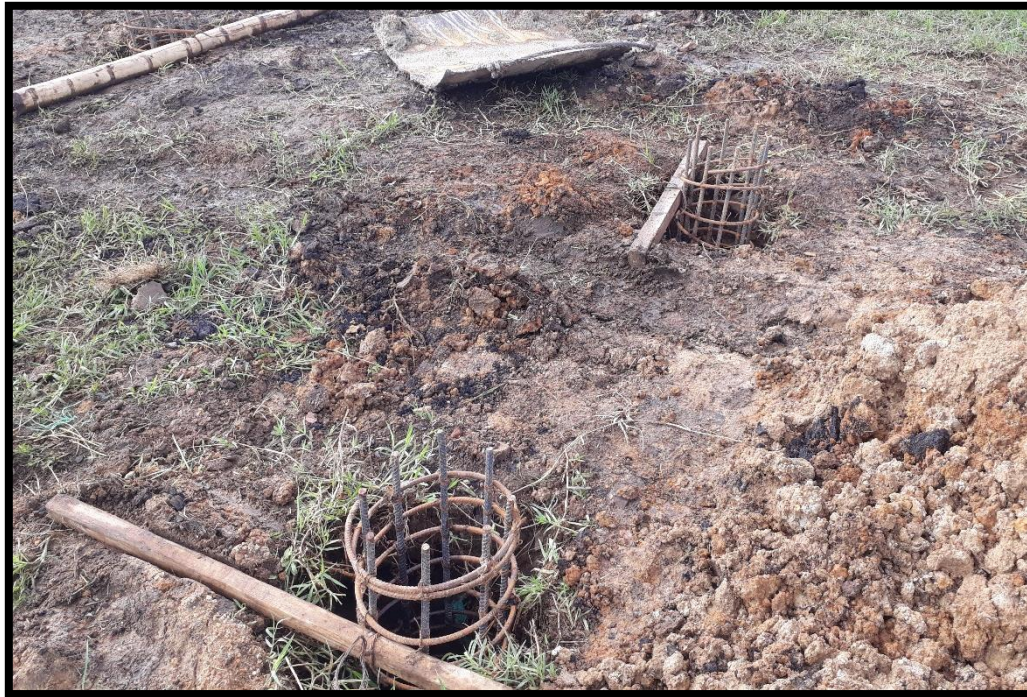
Fotografía 8. Castillos hincados en la perforación.
