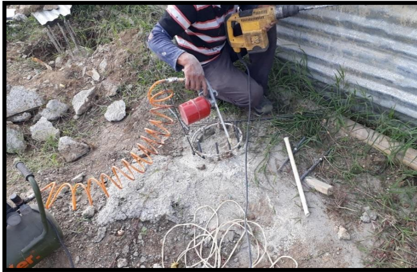
Fotografía 16. Limpieza de las perforaciones del pilote con aire comprimido.
