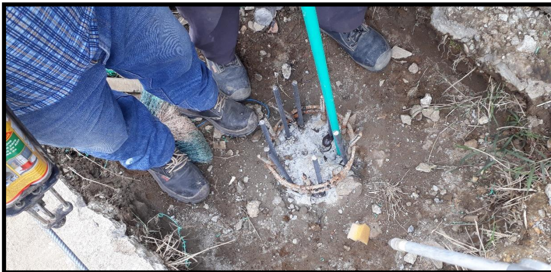
Fotografía 17. Fijación de las varillas utilizando el epóxico.
