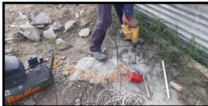
Fotografía 15. Perforación de pilotes con un taladro especial para concreto.
