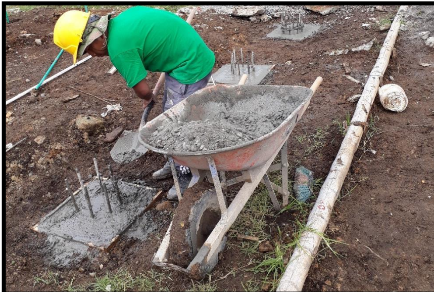
Fotografía 25. Nivelación de pilotes con concreto preparado en obra.
