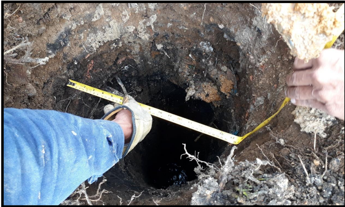
Fotografía 4. Perforación para pilotes
