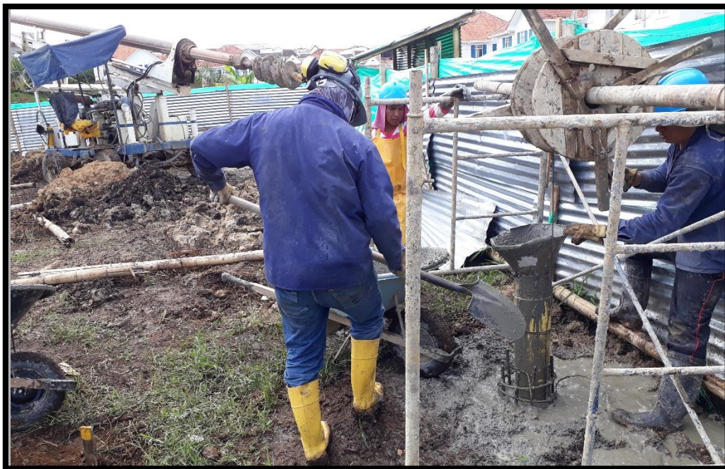
Fotografía 9. Proceso de fundición de pilotes
