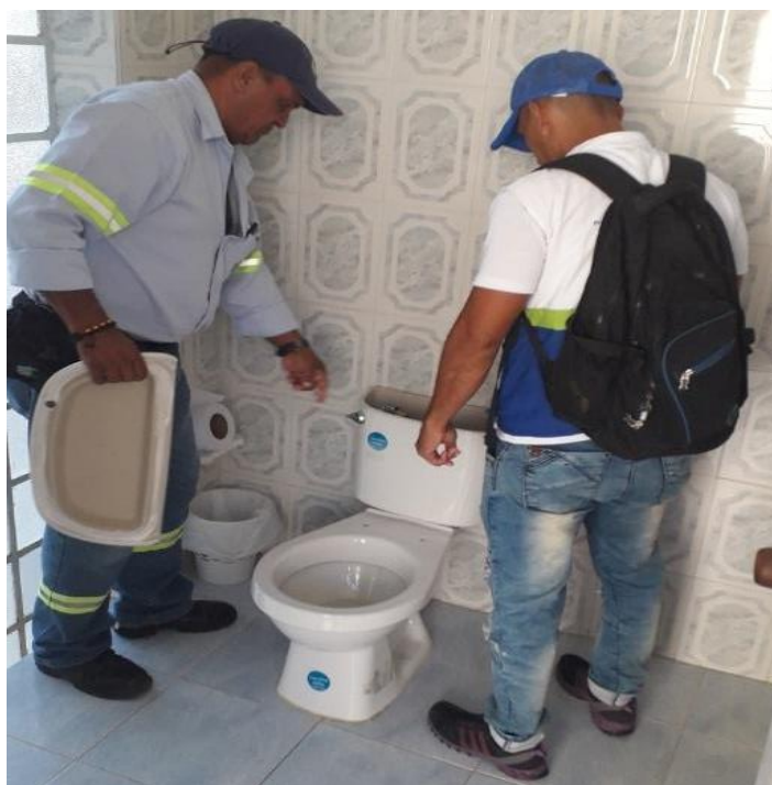
Figura 12. Revisión de elementos hidrosanitarios. Fuente: propia
