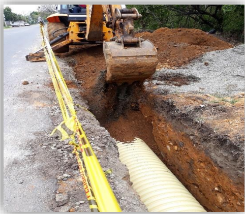
Figura 27. Registro fotográfico relleno y compactación
