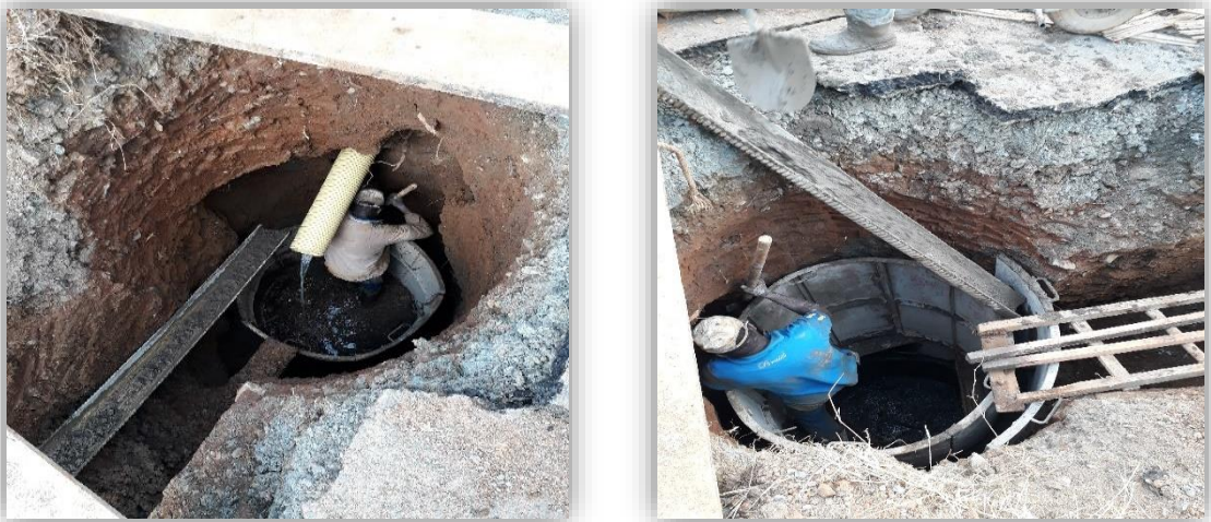
Figura 22. Registro fotográfico cámaras de inspección
