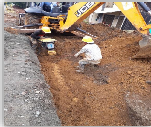
Figura 27. Registro fotográfico relleno y compactación
