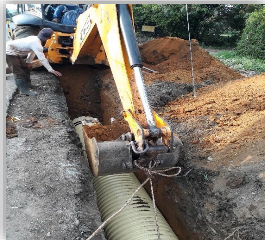
Figura 17. Registro Fotográfico de instalación de tubería PVC
