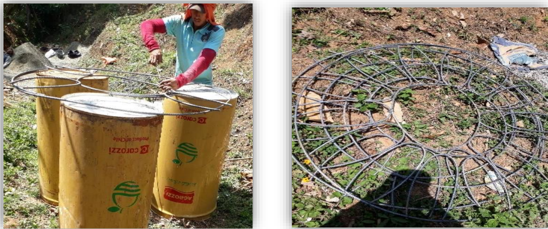
Figura 24. Registro fotográfico detalle del refuerzo de la tapa
