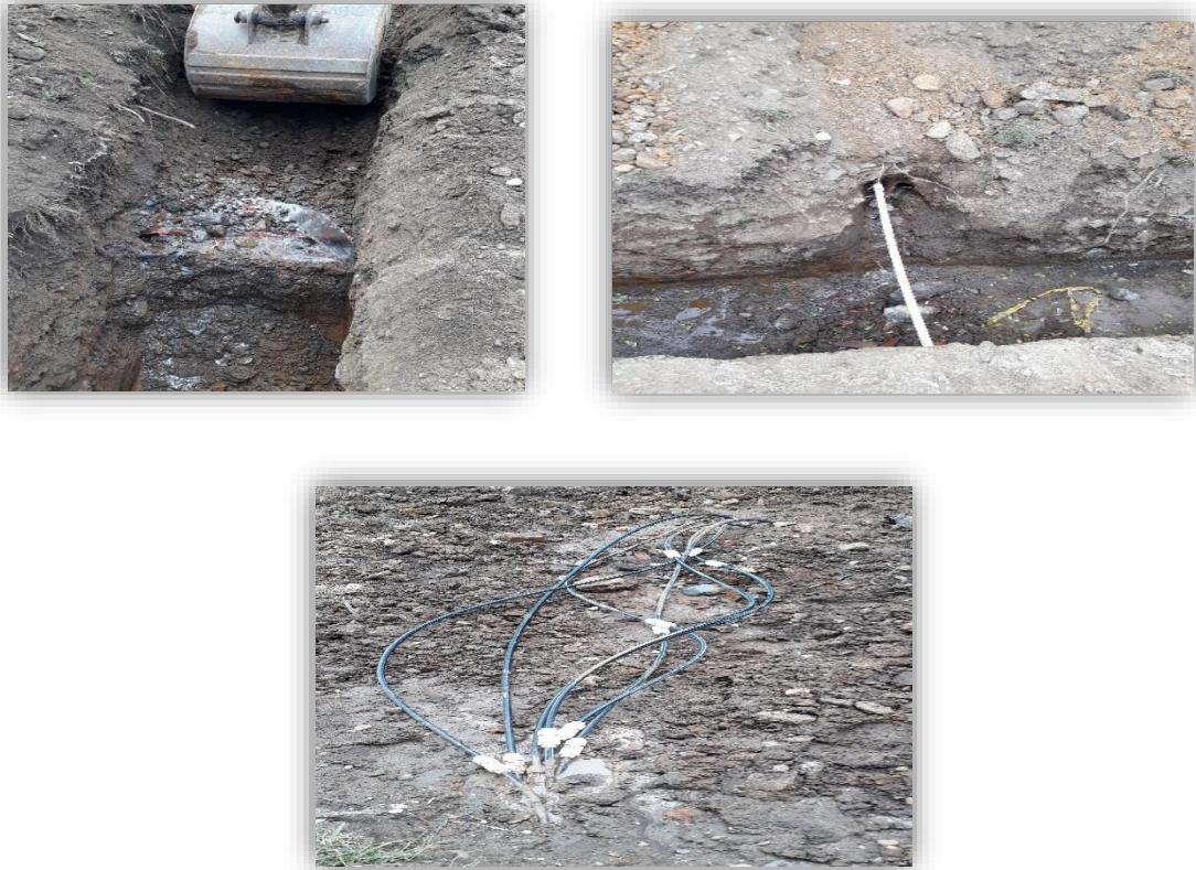
Figura 12. Registro fotográfico de acometida de agua reparada
