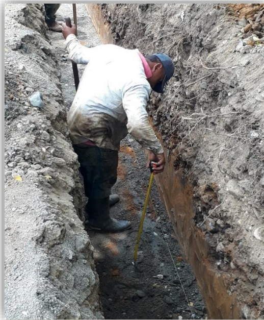
Figura 16. Registro fotográfico de nivelación y colocación filtro en grava
