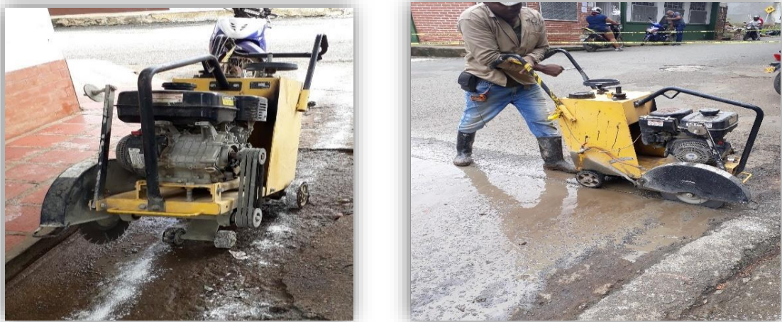
Figura 7. Registro fotográfico de corte de pavimento asfáltico y/o concreto rígido
