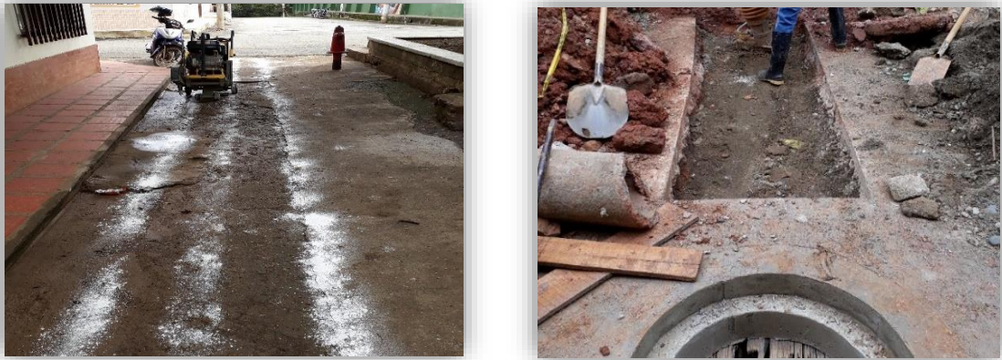
Figura 9. Registro fotográfico de la demarcación, corte y demolición
