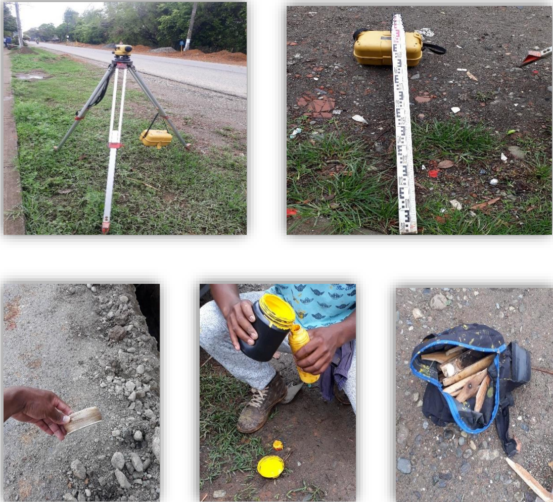
Figura 5. Registro fotográfico de herramientas y equipo utilizado
