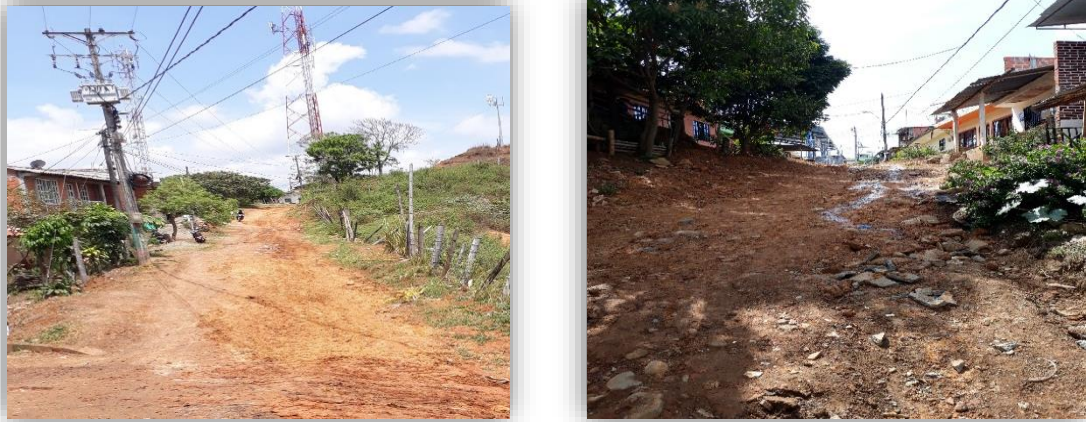
Figura 8. Registro fotográfico tramos en afirmado
