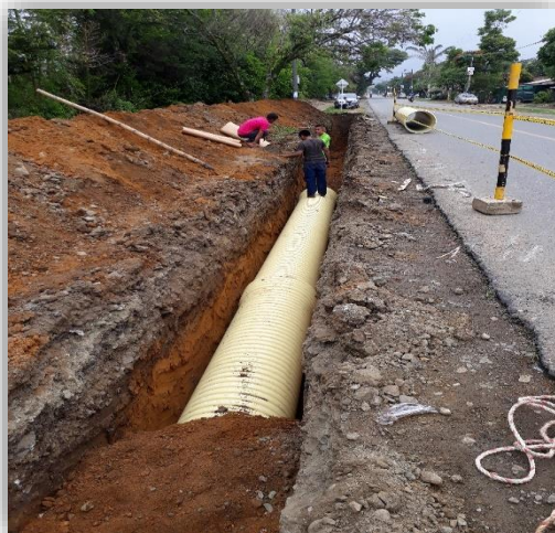
Figura 17. Registro Fotográfico de instalación de tubería PVC
