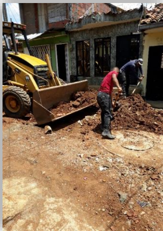
Figura 28. Registro fotográfico cargue de material sobrante
