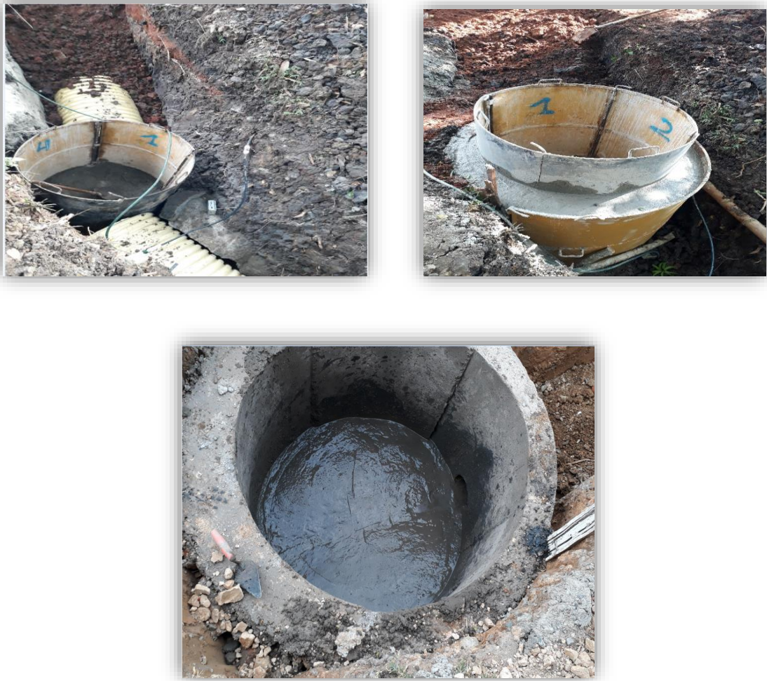
Figura 23. Registro fotográfico de cámaras de inspección fundidas en concreto
