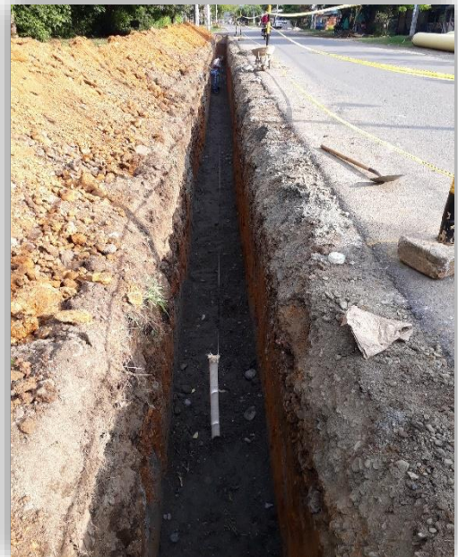
Figura 16. Registro fotográfico de nivelación y colocación filtro en grava
