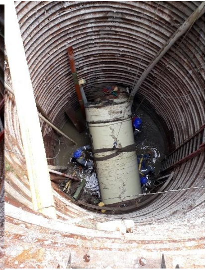
Ilustración 41. Ingreso de Tubería al pozo.
