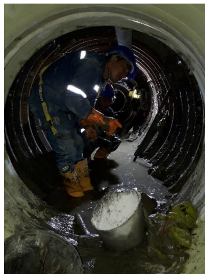
Ilustración 50. Inyección de Mortero desde el Túnel.
