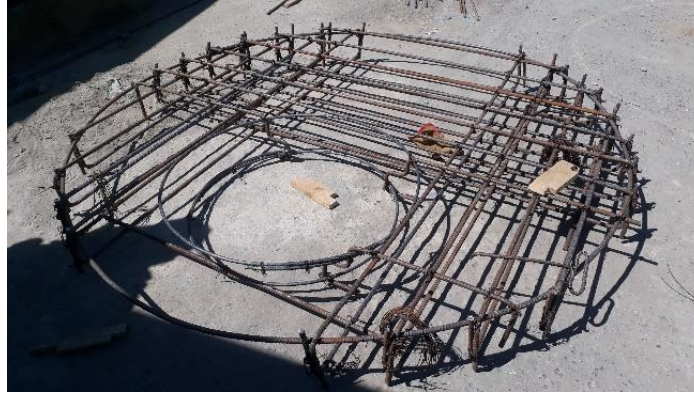
Ilustración 58. Acero amarrado y figurado del brocal.
