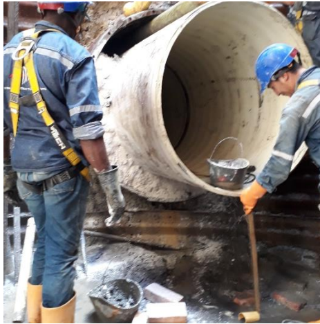
Ilustración 51. Tapón hecho en mortero y ladrillos.
