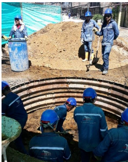
Ilustración 23. Excavación vertical (Pozo).
