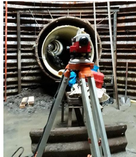
Ilustración 46. Nivelación de Tubería.
