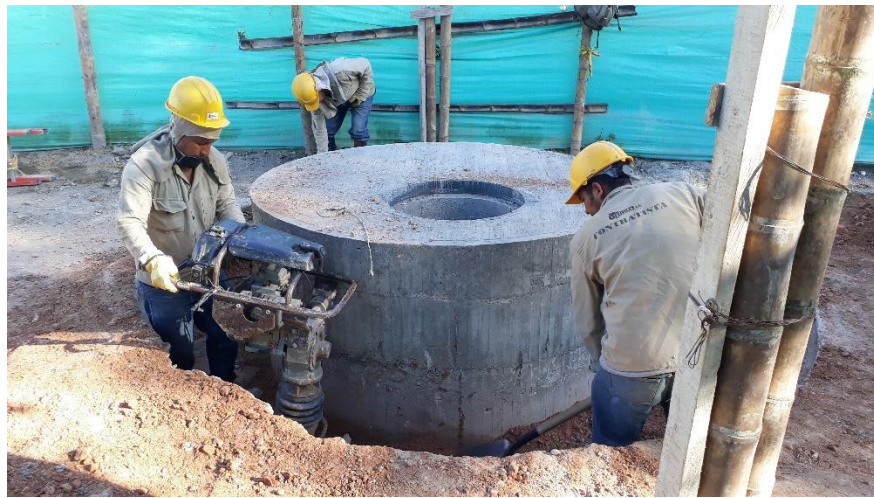
Ilustración 74. Relleno y compactación con saltarín.
