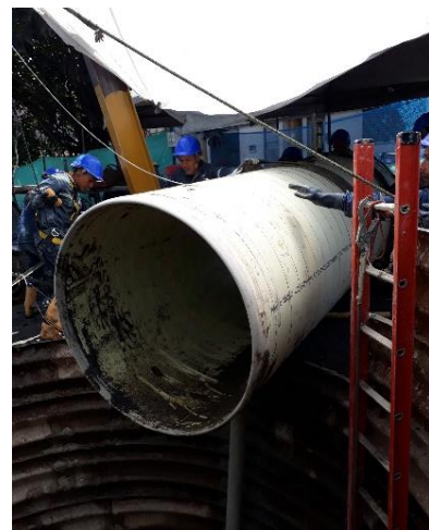
Ilustración 38. Ingreso de Tubería al pozo.
