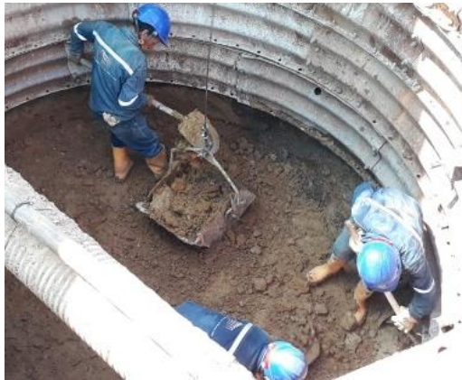
Ilustración 27. Excavación en el fondo del pozo.
