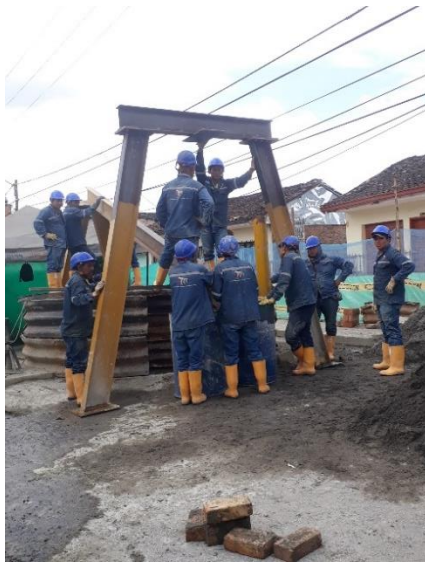
Ilustración 36. Instalación de secciones.
