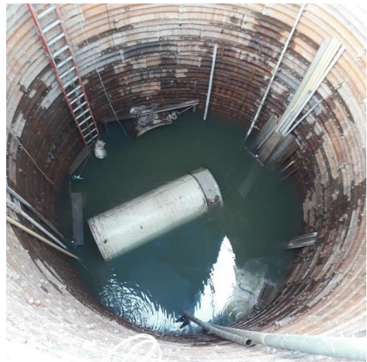
Ilustración 24. Vista hacia el fondo del pozo 5 terminado.
