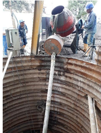
Ilustración 48. Inyección de mortero en la Tubería.
