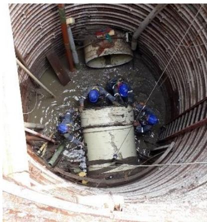
Ilustración 43. Ingreso de Tubería al pozo.
