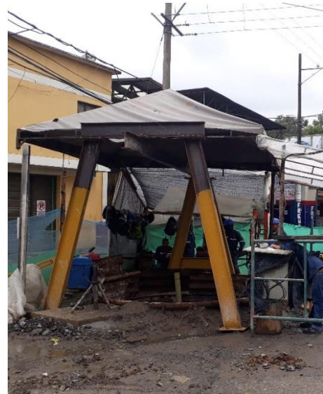
Ilustración 35. Pórtico para ingreso de Tubería.
