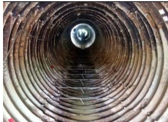
Ilustración 7. Túnel Liner Circular.
