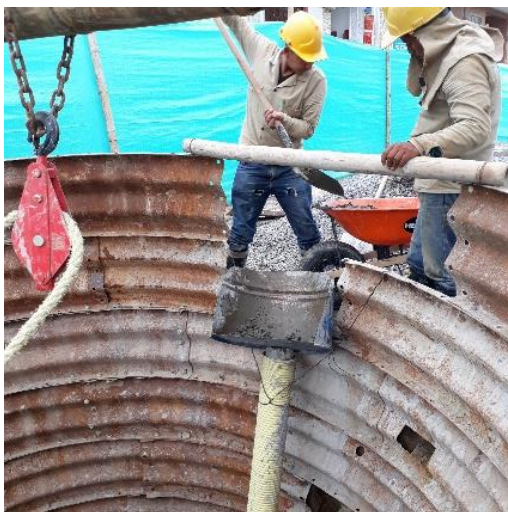
Ilustración 69. Fundición con ccto mezclado en Obra.
