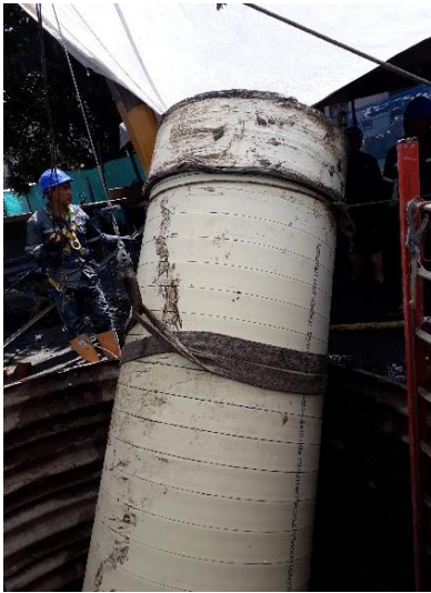
Ilustración 40. Ingreso de Tubería al pozo.
