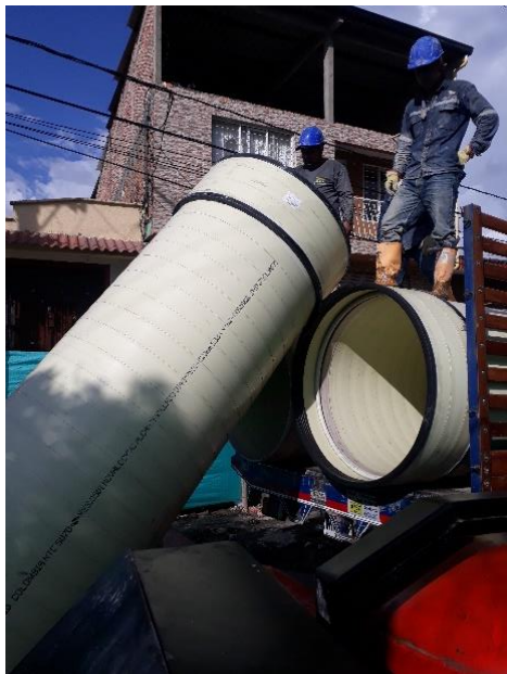
Ilustración 33. Descarga de Tubería.
