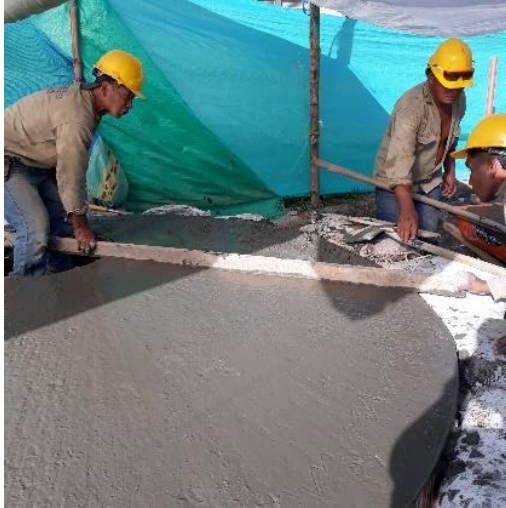
Ilustración 71. Fundición del Brocal.
