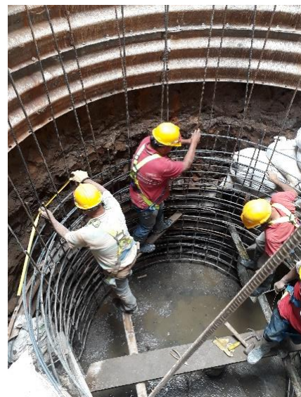
Ilustración 57. Amarrado de Hierro dentro del Pozo.
