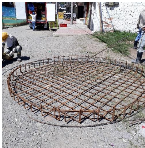
Ilustración 56. Acero amarrado y figurado de losa inferior.
