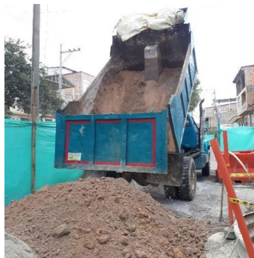
Ilustración 81. Descargue de material en Obra.
