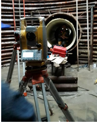
Ilustración 31. Chequeo de línea con la Estación Total.
