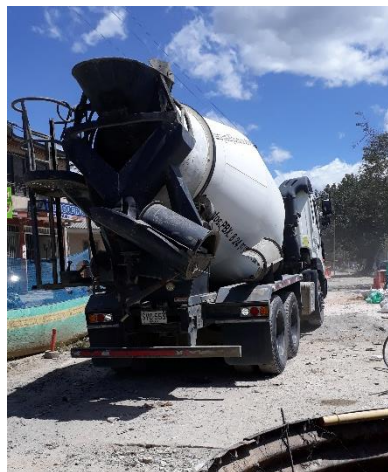
Ilustración 77. Concreto recibido en obra.
