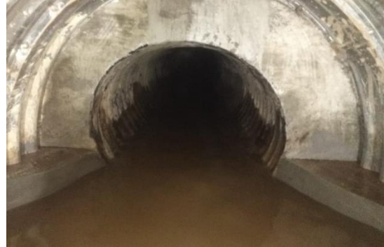
Ilustración 12. Túnel Liner Elipse.
