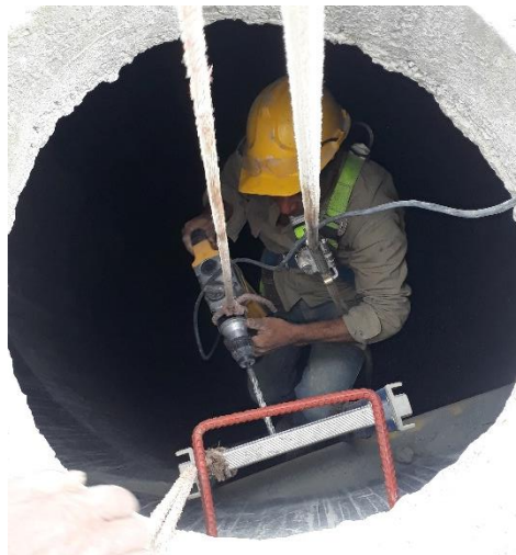
Ilustración 72. Instalación de peldaños.
