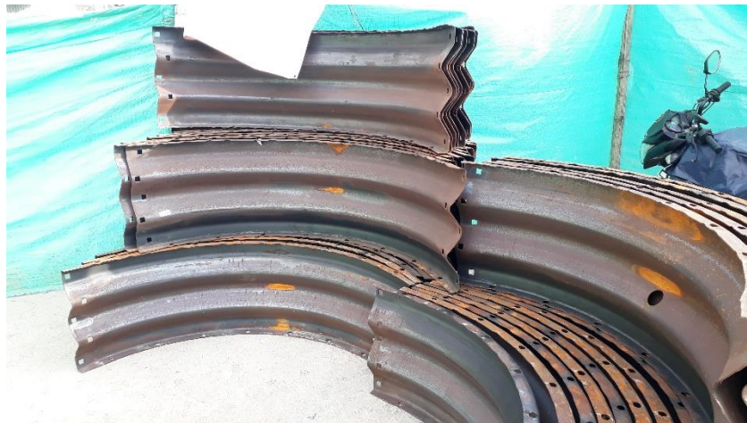
Ilustración 5. Almacenamiento de láminas en obra.
