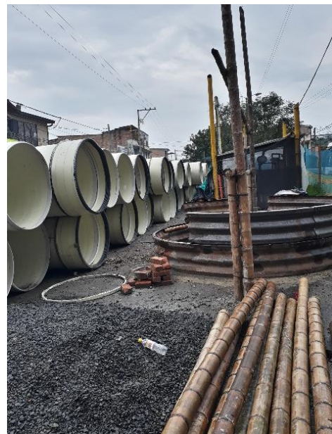
Ilustración 34. Almacenamiento de obra.
