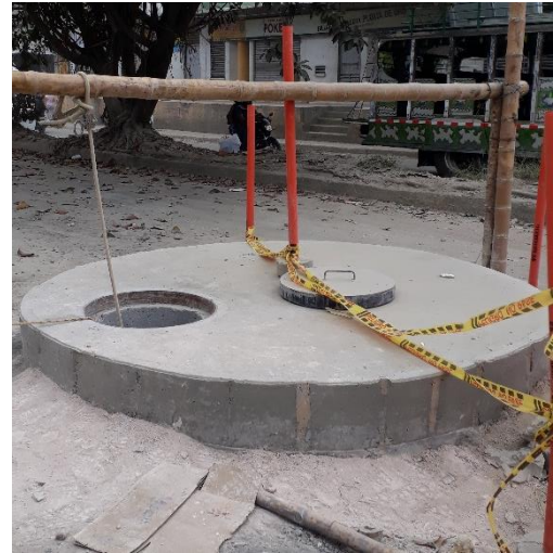
Ilustración 70. cámara de inspección terminada.
