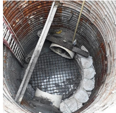
Ilustración 64. Instalación del acero para losa inferior.
