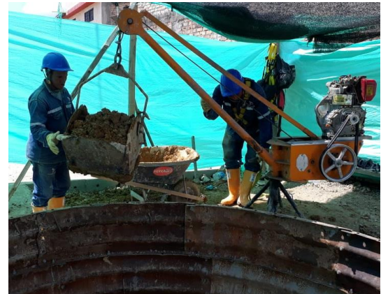
Ilustración 26. Extracción de material en el fondo del pozo.
