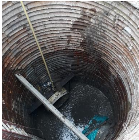
Ilustración 65. Fundición del solado (1:3:3).
