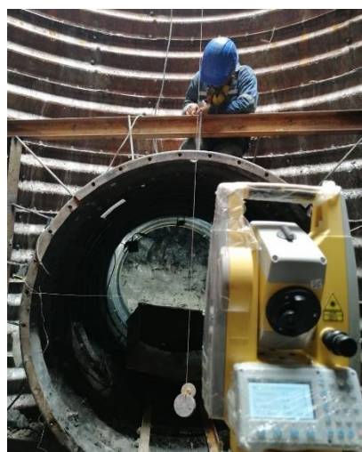
Ilustración 28. Direccionamiento del Túnel.
