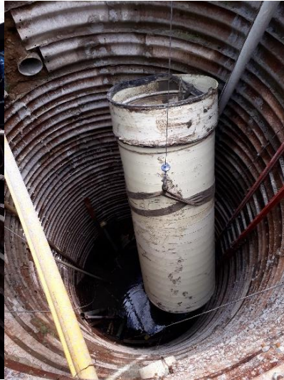
Ilustración 42. Ingreso de Tubería al pozo.
