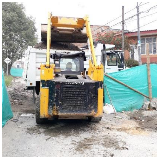
Ilustración 80. Mini cargador y Volqueta contratados para limpieza.
