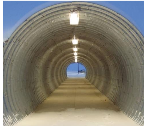
Ilustración 14. Túnel Liner en Arco
