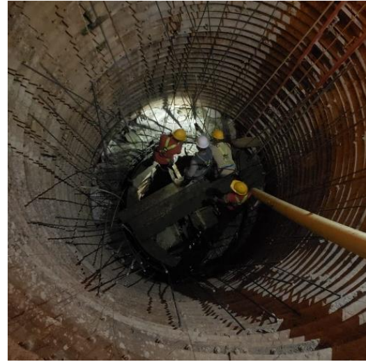
Ilustración 66. Fundición. Vista fondo del pozo.
