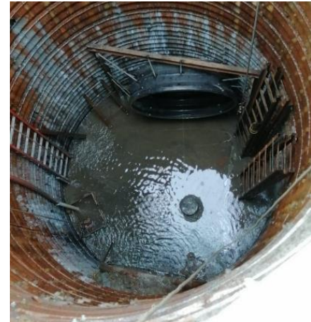
Ilustración 29. Anillo fijado con soldadura
