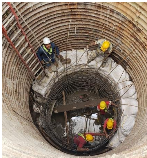
Ilustración 61. Apisonada y acomodo de costalillas (formaleta externa).
