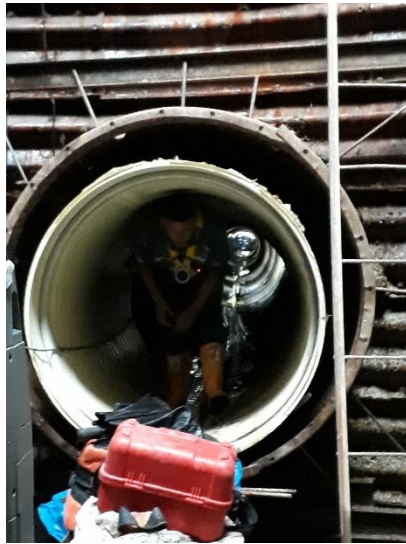
Ilustración 47. Tubería lista para inyección de Mortero.
