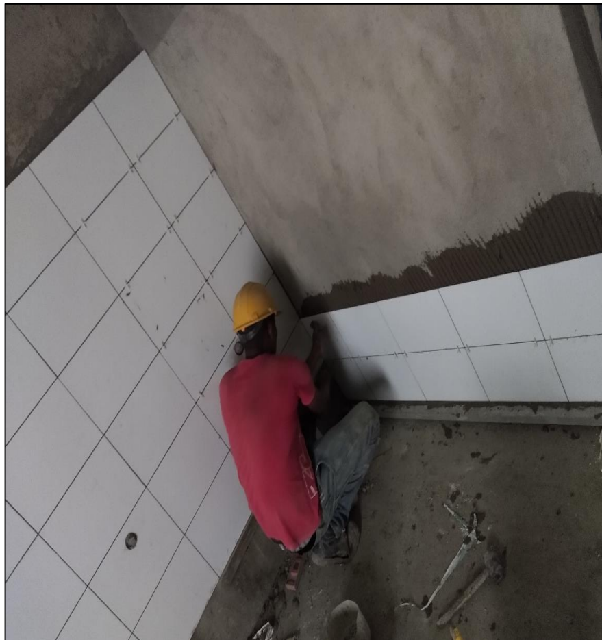
Ilustración 44 Instalación de enchapes de muro.
