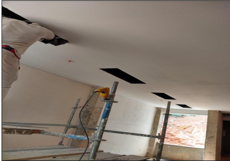
Ilustración 54 Apertura de huecos para lámparas.
