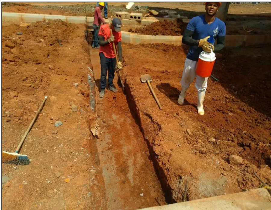
Ilustración 81 Adecuación del sitio del cárcamo.
