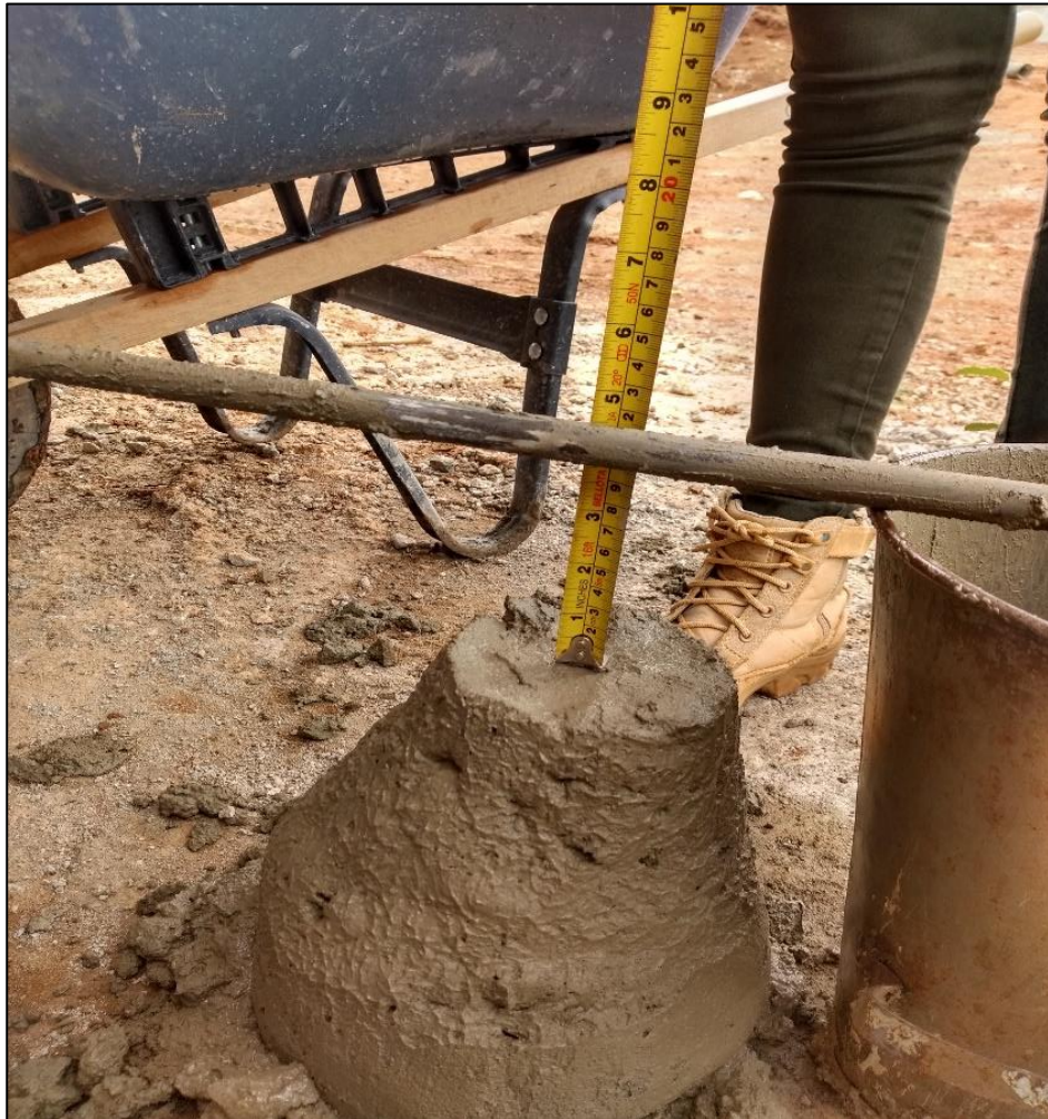
Ilustración 22 Prueba de asentamiento elaborada, medición de asentamiento.
