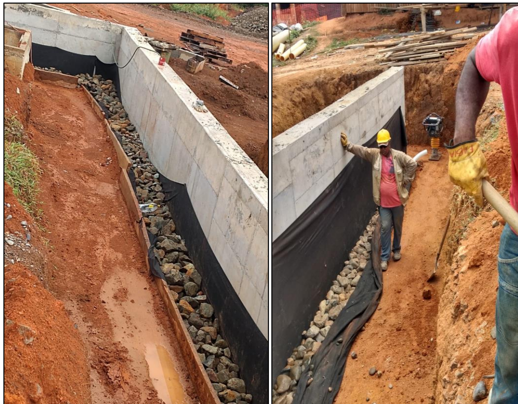
Ilustración 21 Instalación del filtro y compactación de materia adyacente.
