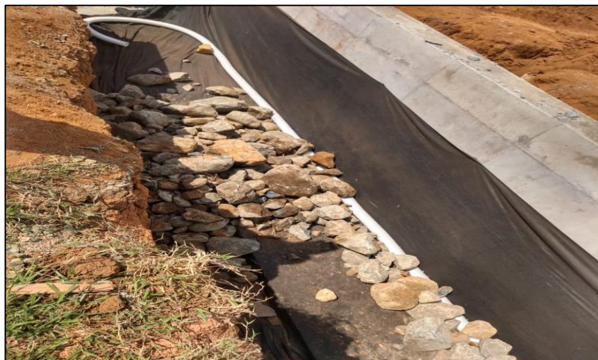
Ilustración 19 Material del filtro, tubería y geodren
