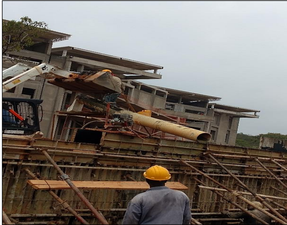
Ilustración 32 Fundición alzada rampa 2 eje b
