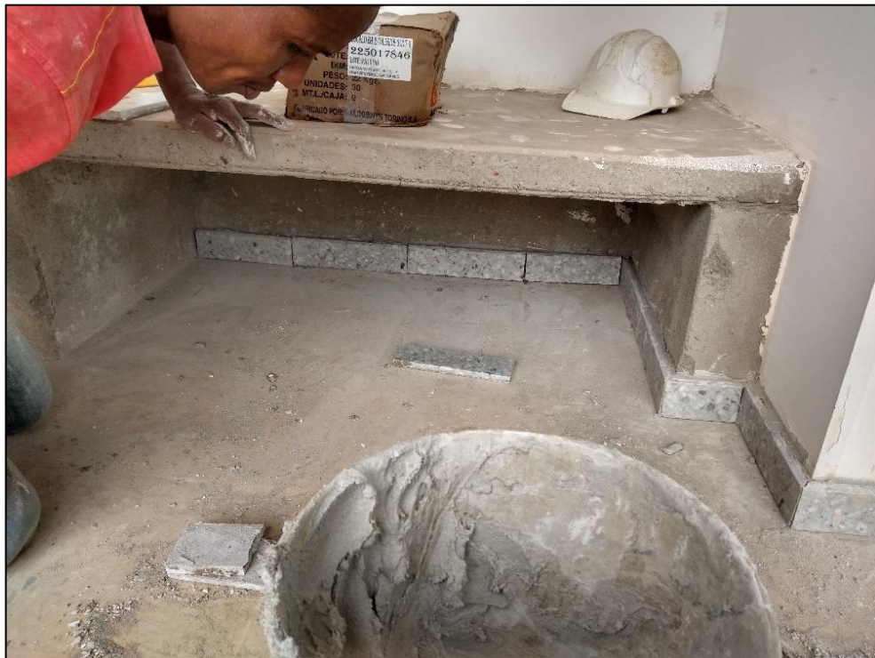
Ilustración 42 Pega de guarda escoba
