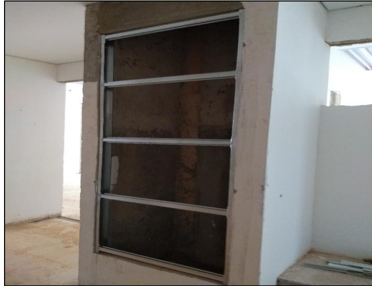
Ilustración 60 Instalación de canales y parales para buitrón.
