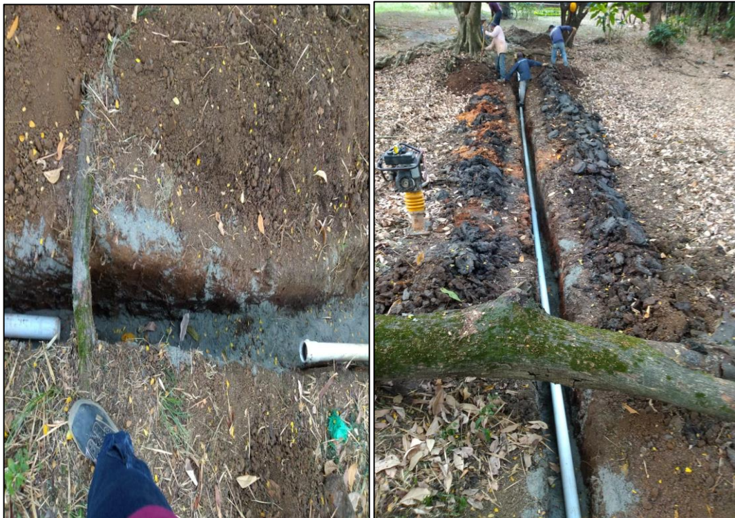
Ilustración 12 Instalación de tubería sobre capa de área y material de relleno compactado.
