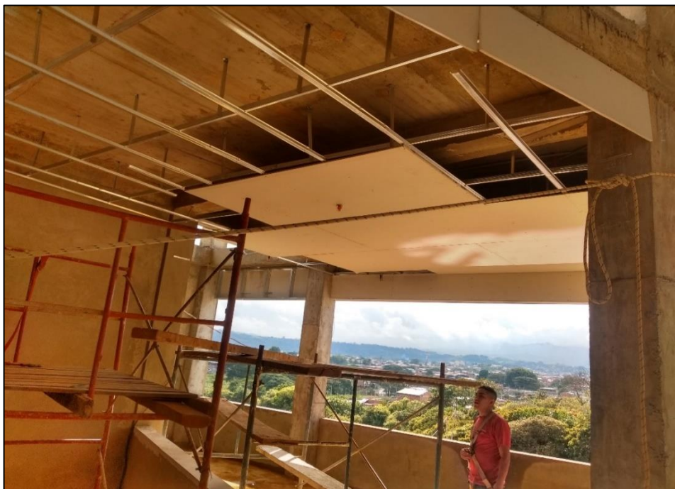
Ilustración 51 Instalación de panel yeso con andamios.
