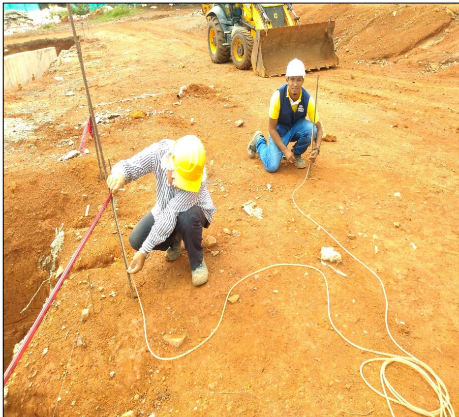
Ilustración 48 Toma de niveles con manguera.
