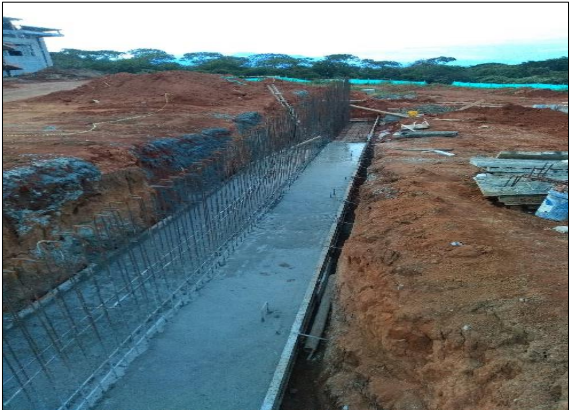
Ilustración 31 Fundición zarpa rampa 2.
