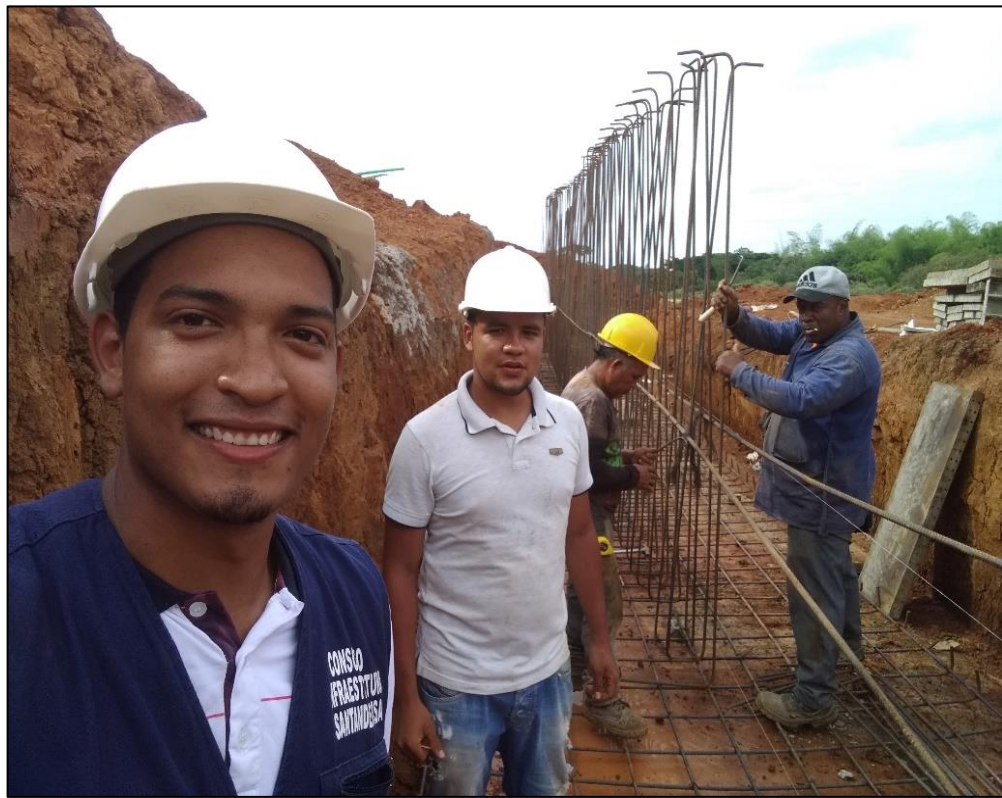
Ilustración 37 Verificación de la colocación de acero.
