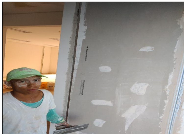
Ilustración 61 Acabado de buitrón.
