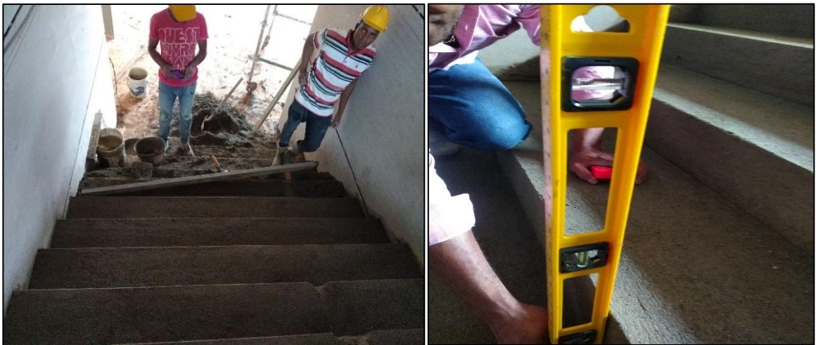
Ilustración 39 Repello de gradas y chequeo de niveles
