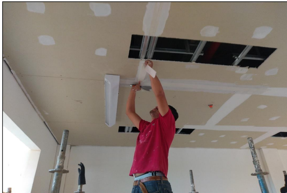
Ilustración 55 Acabado de cielo raso en panel yeso.
