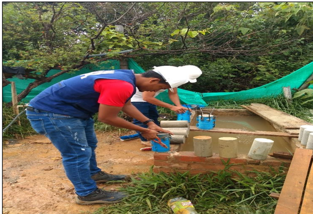
Ilustración 24 Desencofrado y curado de cilindros
