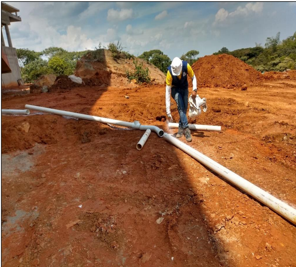
Ilustración 78 Trazado de alineamiento de tubería
