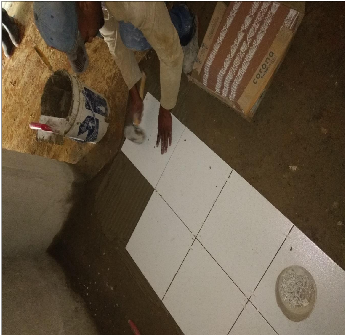
Ilustración 43 Instalación de enchapes de piso.
