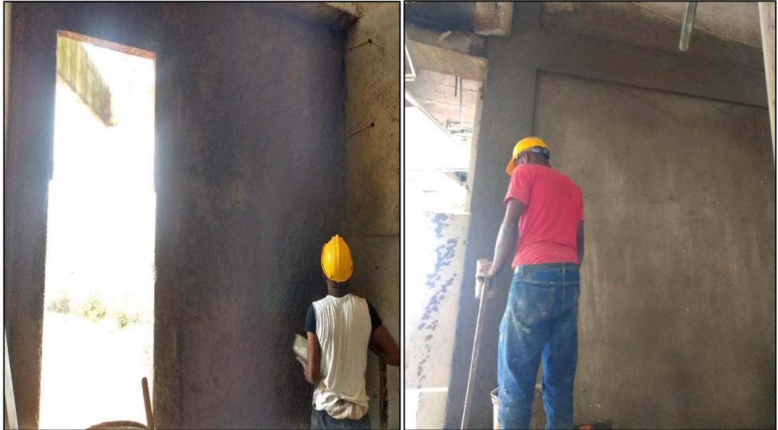
Ilustración 40 Repello de muro y repello de columnas.
