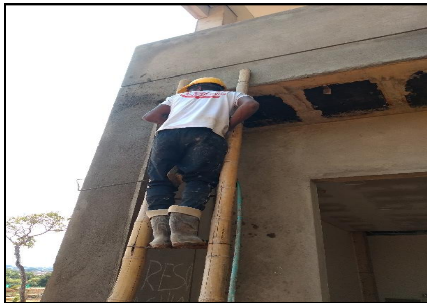
Ilustración 41 Repello exterior.
