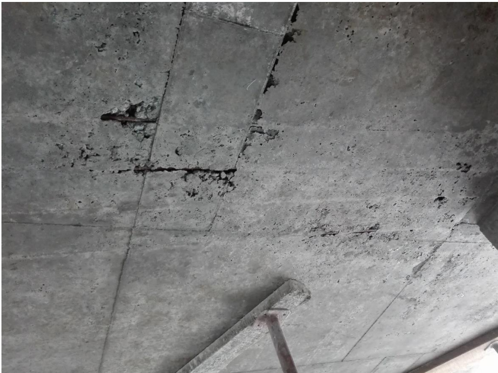
Fotografía 7 Acero expuesto, mal confinamiento. Falta de separadores de losa y vibrado deficiente. Tomada por Jennifer Ospina.
