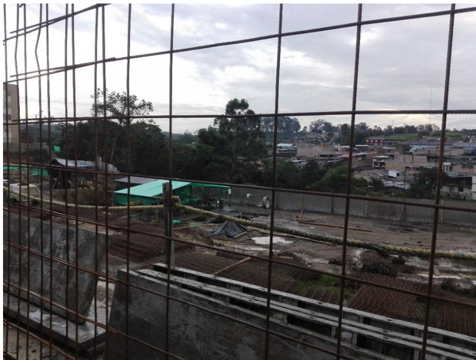
Fotografía 9 Malla electrosoldada incompleta. Tomada por Jennifer Ospina.
