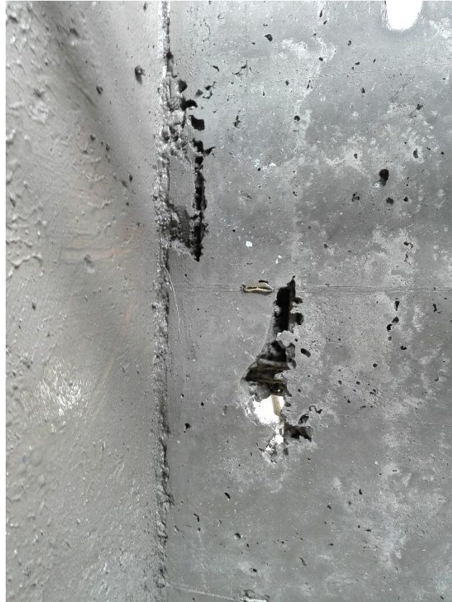
Fotografía 5 Mal confinamiento. Mal vibrado y falta de separador en la malla. Tomada por Jennifer Ospina.
