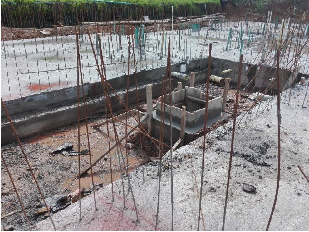
Fotografía 11 Malla electrosoldada torcida. Tomada por Jennifer Ospina.
