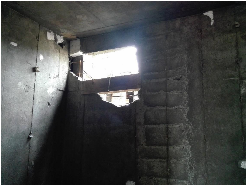
Fotografía 13 Mal confinamiento, mal vibrado, falta de separadores de muro. Tomada por Jennifer Ospina.
