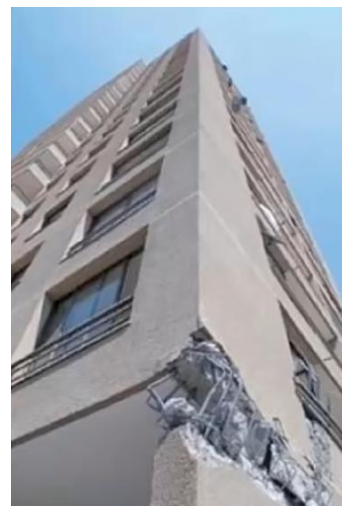
Imagen 11 Deficiente confinamiento en los elementos de borde. Tomada de Scielo.org
