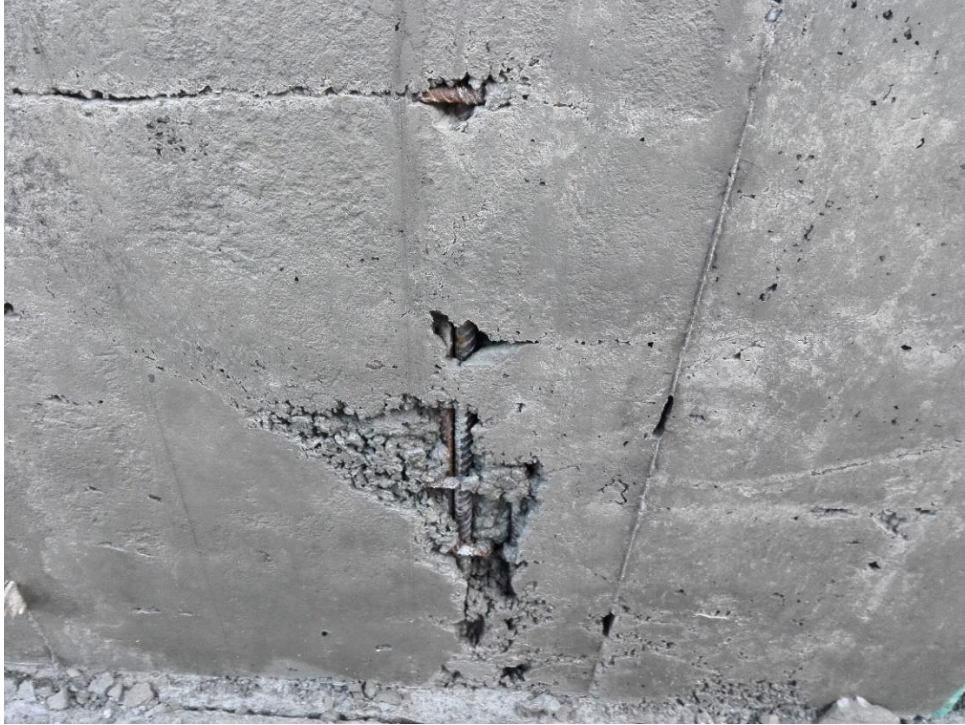
Fotografía 16 Losa con acero expuesto por mal vibrado, falta de separador de losa. Tomada por Jennifer Ospina.
