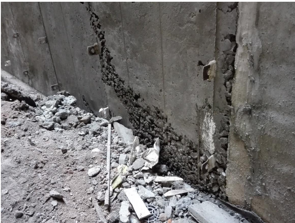
Fotografía 19 Hormiguo en muro por mal vibrado. Tomada por Jennifer Ospina.
