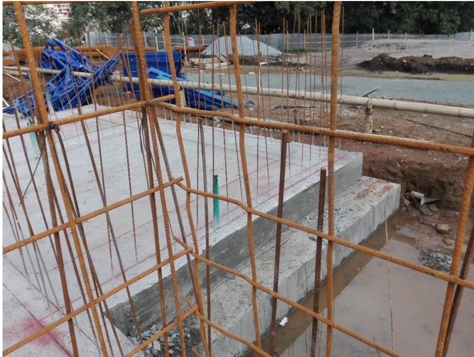
Fotografía 11 Malla electrosoldada torcida. Tomada por Jennifer Ospina.
