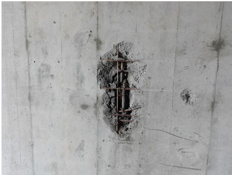
Fotografía 5 Mal confinamiento. Mal vibrado y falta de separador en la malla. Tomada por Jennifer Ospina.
