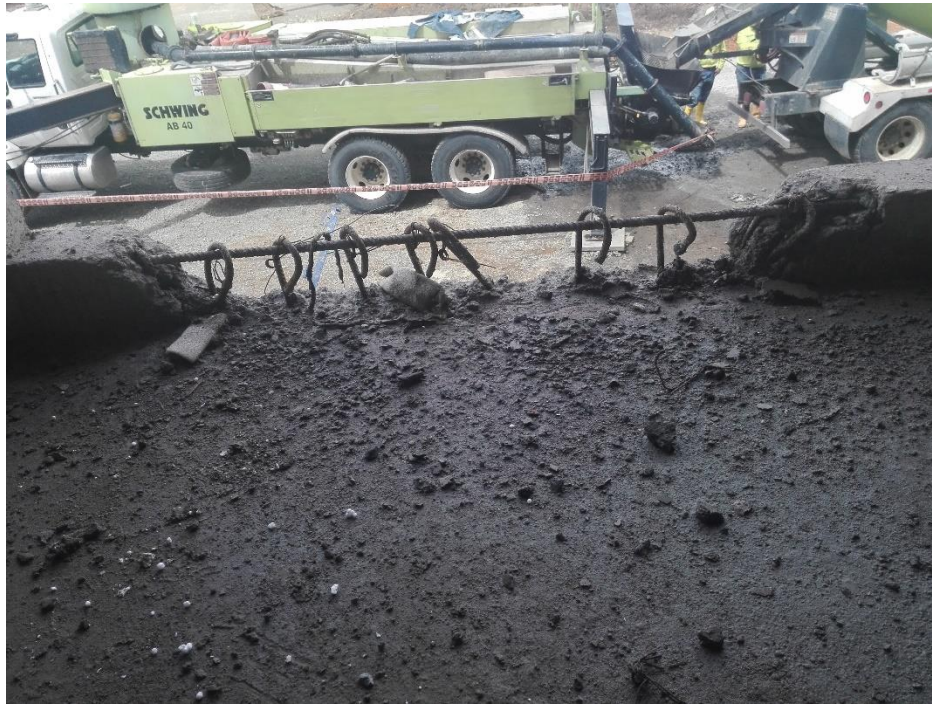
Fotografía 9 Malla electrosoldada incompleta. Tomada por Jennifer Ospina.
