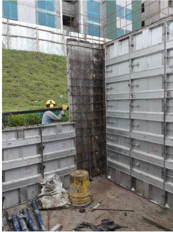
Fotografía 13 Mal confinamiento, mal vibrado, falta de separadores de muro. Tomada por Jennifer Ospina.
