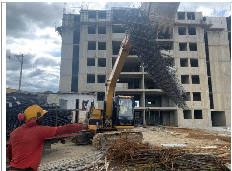
Ilustración 60. Recepción malla electro soldada. Fuente: Propia
