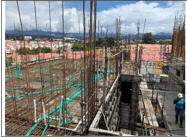
Ilustración 59. Apartamento con las instalaciones, listo para ser fundido. Fuente: Propia
