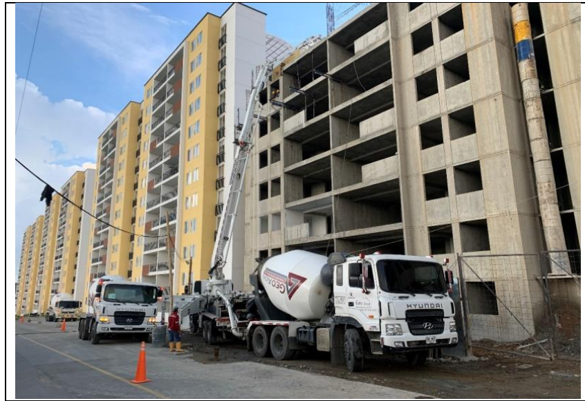
Ilustración 15. Fundición con Autobomba Fuente: Propia
