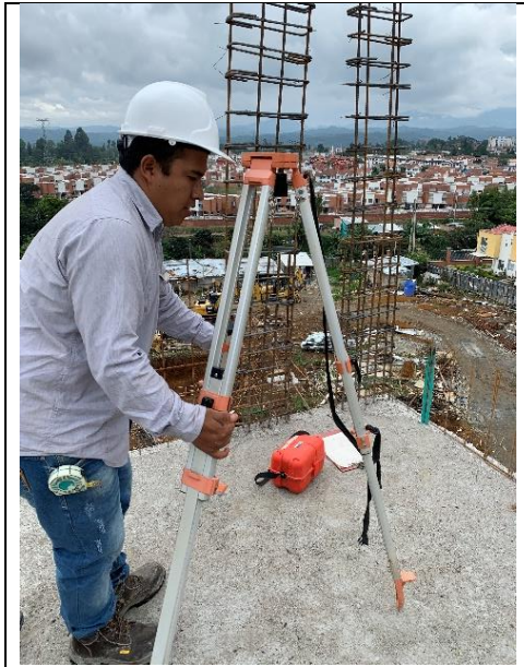
Ilustración 39. Acomodo del equipo de nivelación.
