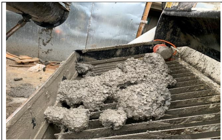
Ilustración 33. Masa de concreto presente en fundición. Fuente: Propia
