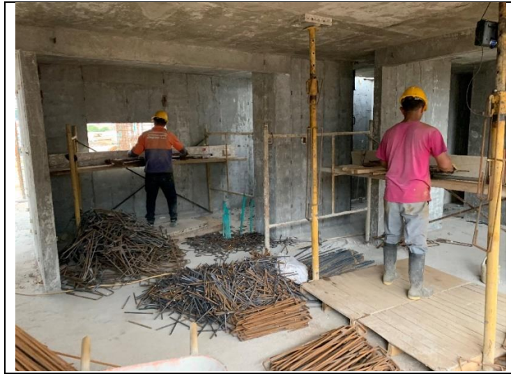
Ilustración 35. Actividad de doblada de estribos. Fuente: Propia
