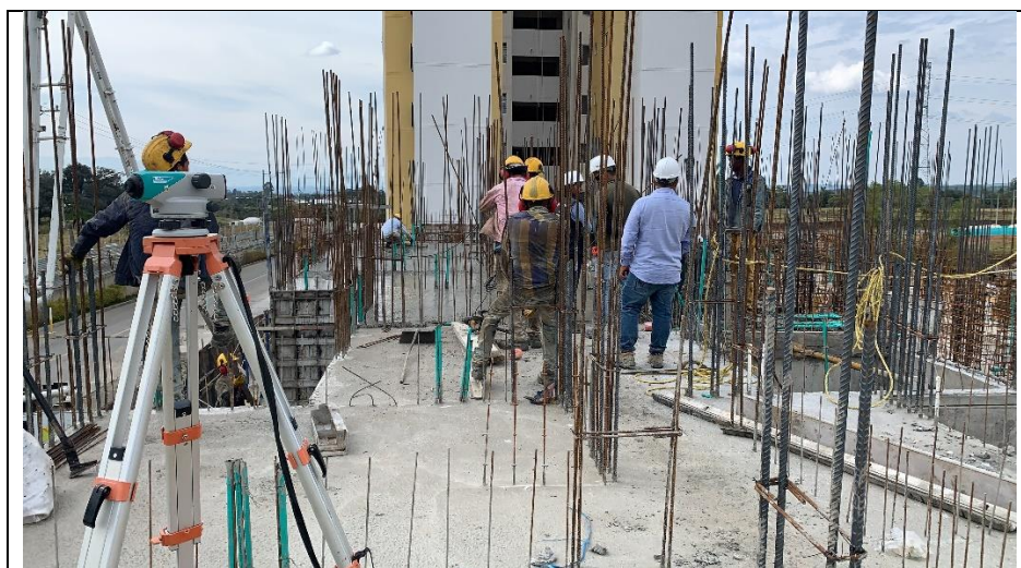
Ilustración 38. Nivelación del segundo nivel de la torre A. Fuente: Propia
