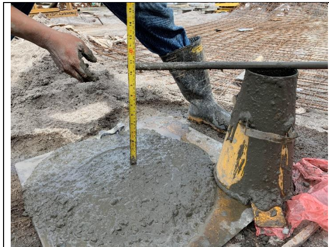
Ilustración 14. Medida de prueba del SLUMP Fuente: Propia
