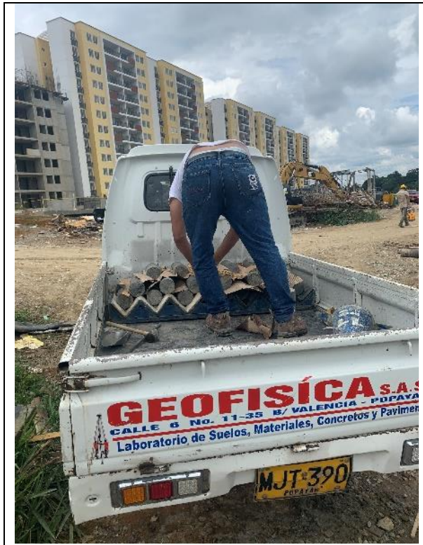
Ilustración 29. Recolección cilindros de concreto Fuente: Propia
