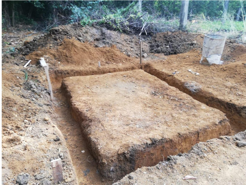
Ilustración 32: Excavación estructura de sobrecimiento. Fuente propia.
