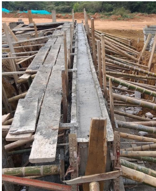
Ilustración 24: Final del vaciado. Fuente propia.
