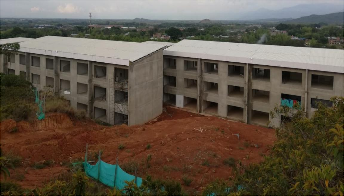
Ilustración 16: Parte trasera de los bloques 1 y 2. Fuente propia.
