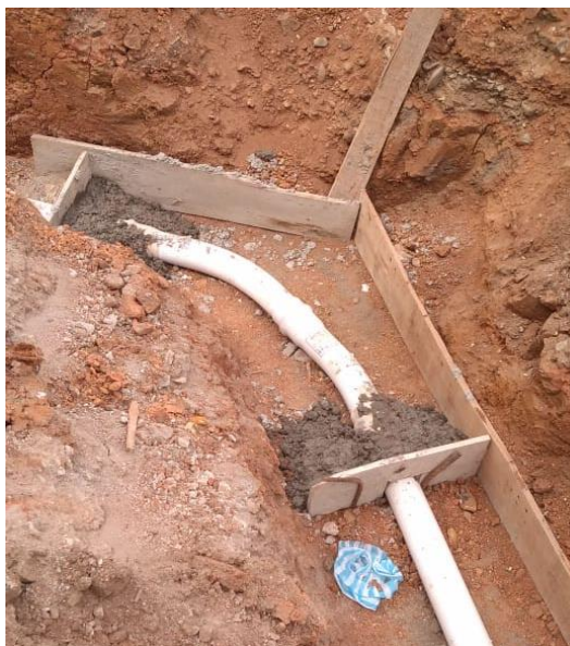
Ilustración 48: Codos de gran radio. Fuente propia.
