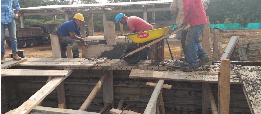
Ilustración 23: Vaciado de concreto alzada. Fuente propia.
