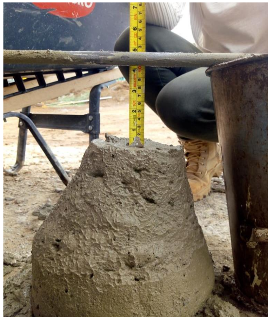
Ilustración 11: Medición de asentamiento. Fuente propia.
