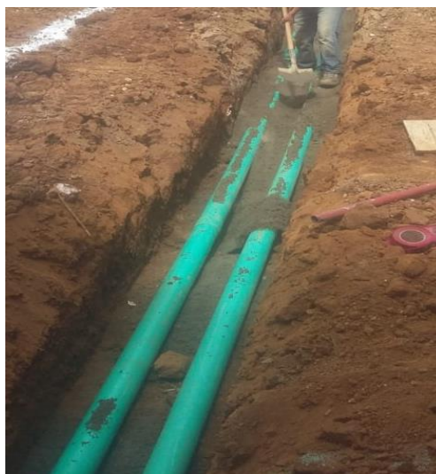
Ilustración 54: Instalación de tubería Conduit de 4".
