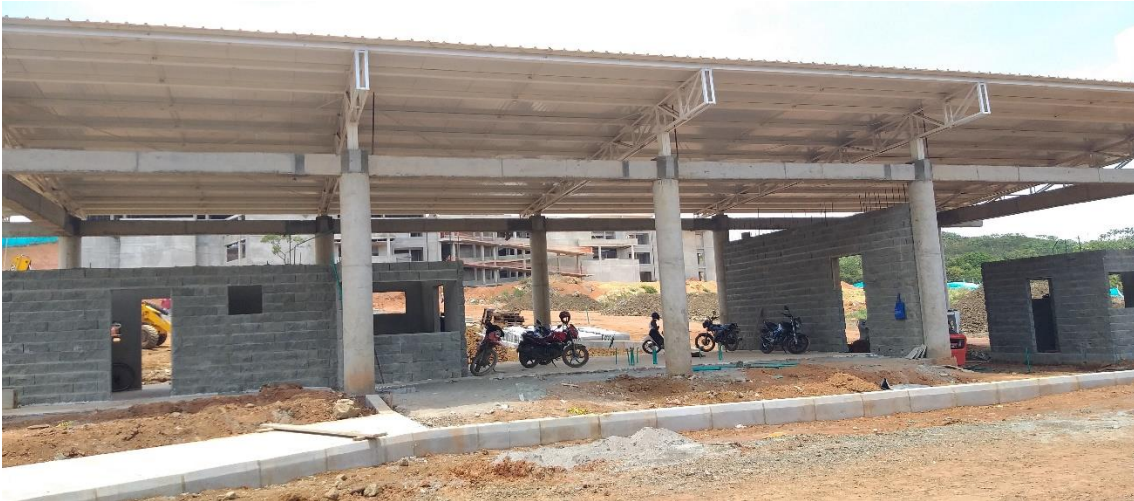
Ilustración 4: Portería de acceso vehicular y peatonal. Fuente propia.
