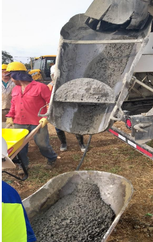
Ilustración 21: Muestra de concreto para elaboración de ensayos. Fuente propia.
