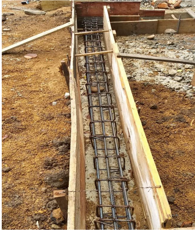
Ilustración 39: Instalación formaletas viga de sobrecimiento. Fuente propia.
