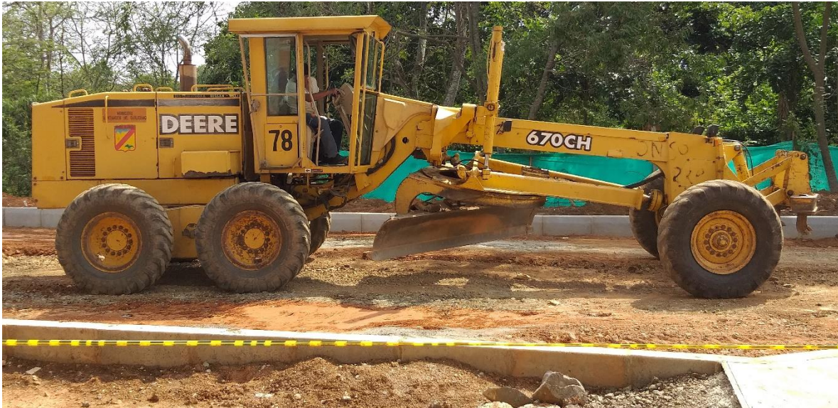
Ilustración 46: Nivelación de terreno en vía de acceso. Fuente propia.
