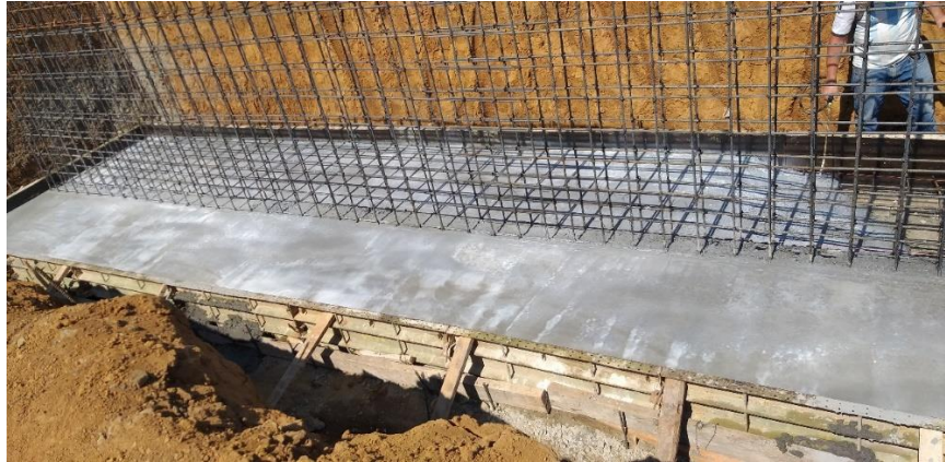
Ilustración 19. Aplicación de Antisol en el concreto. Fuente propia.
