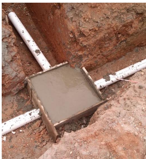
Ilustración 49: Anclaje en concreto para accesorio de tubería hidráulica. Fuente propia.
