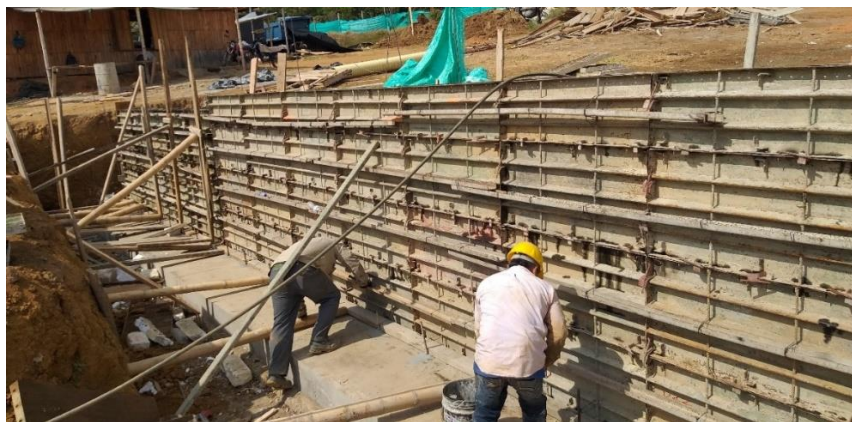
Ilustración 22: Proceso de apuntalamiento de la formaleta. Fuente propia.
