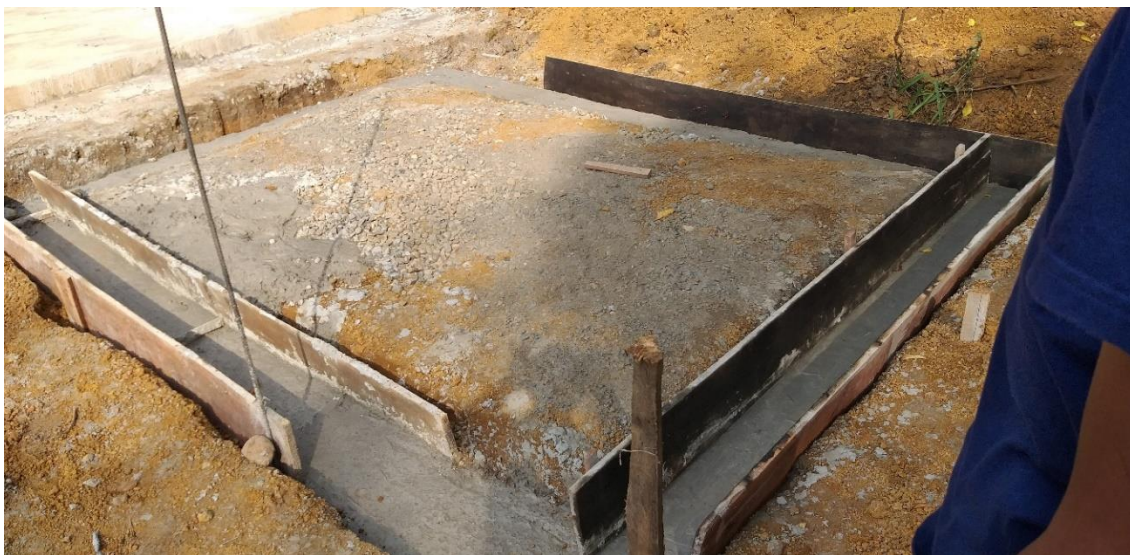
Ilustración 33: Viga en concreto ciclópeo. Fuente propia.
