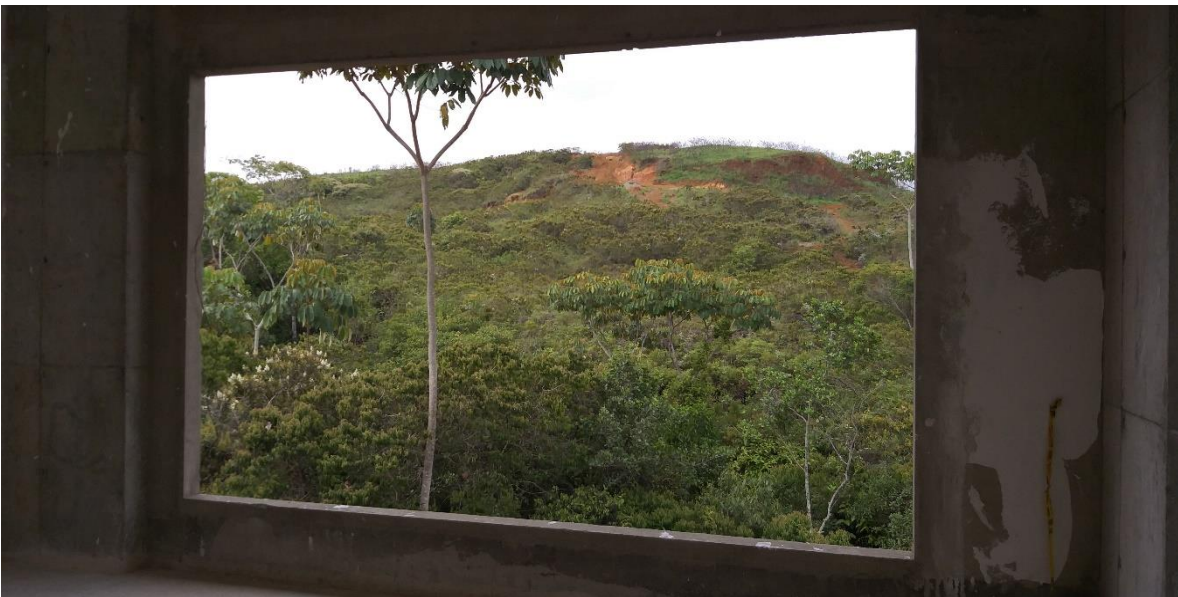
Ilustración 17: Ventana aula. Fuente propia.
