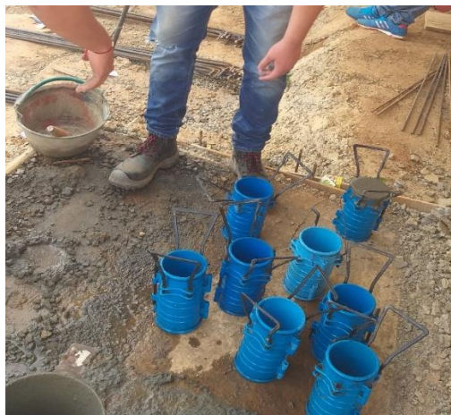
Ilustración 12: Elaboración de cilindros de concreto. Fuente propia.
