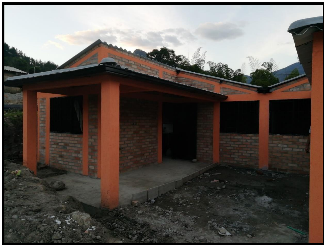
Figura 21 Acabado con graniplast naranja en columnas y vigas exteriores.
