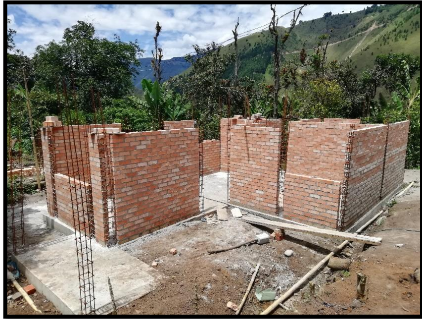
Figura 12 Muros confinados en proceso de construcción vivienda tipo 1.
