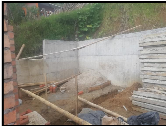
Figura 20 Construcción de muro de contención para vivienda en zona de riesgo.
