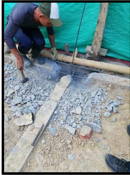
Figura 10 Alineamiento de vigas de cimentación.
