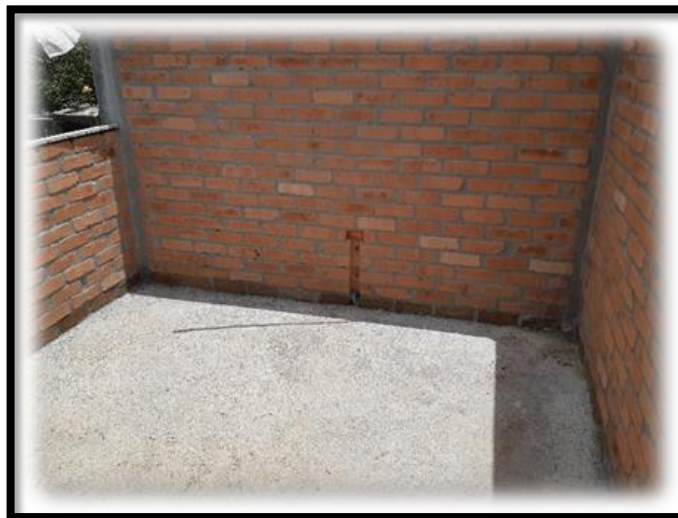
Figura 13 Registro y chequeo de muros.
