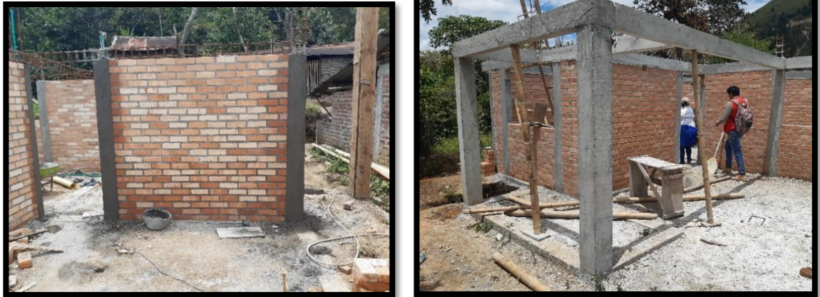
Figura 14 Chequeo de vigas de amarre y columnetas.
