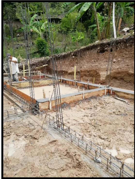
Figura 17 Inicio construccion de vivienda, fundicion de vigas de cimentacion.
