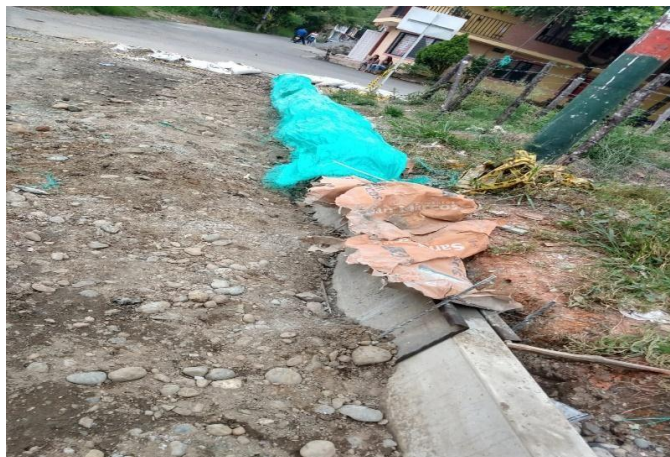
Ilustración 58. Cubrimiento de sardinel por motivo de lluvia
