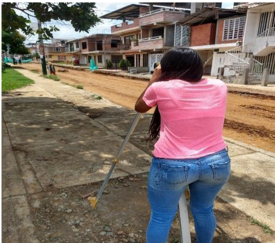
Ilustración 17. Toma de Niveles Subrasante
