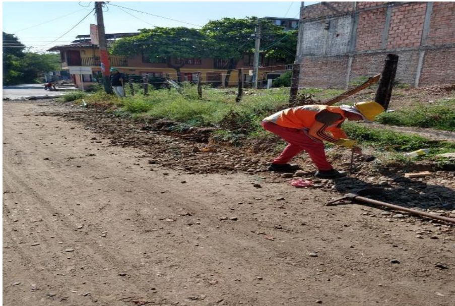
Ilustración 47. Puesta de pines y excavación
