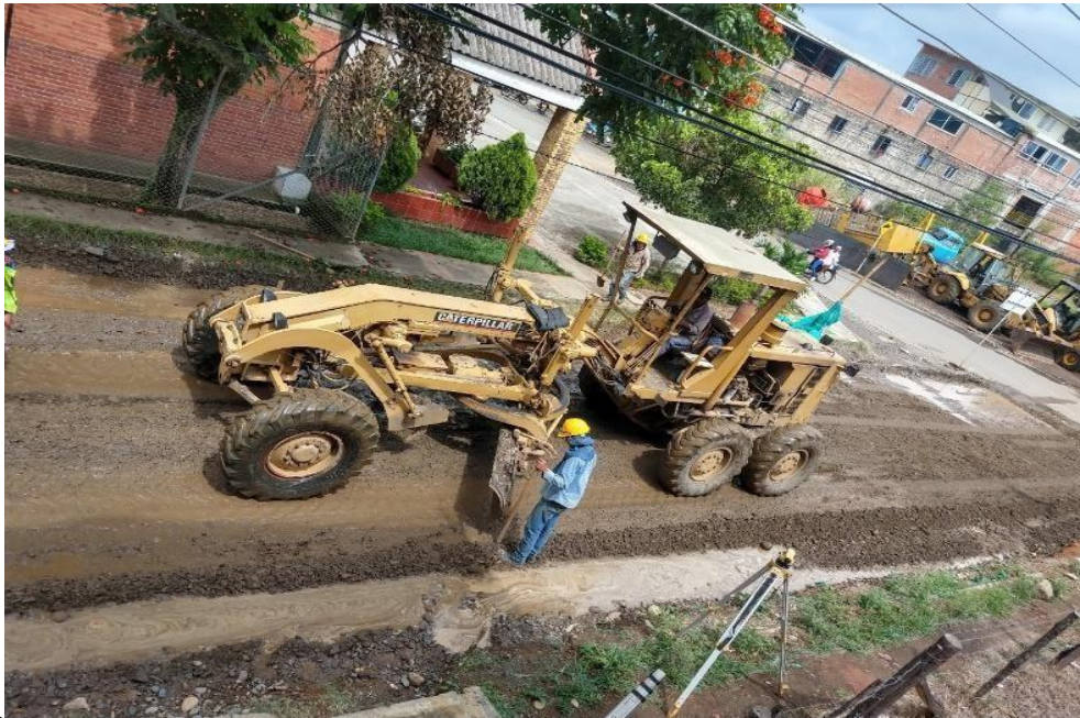
Ilustración 35. Conformación del material sub base
