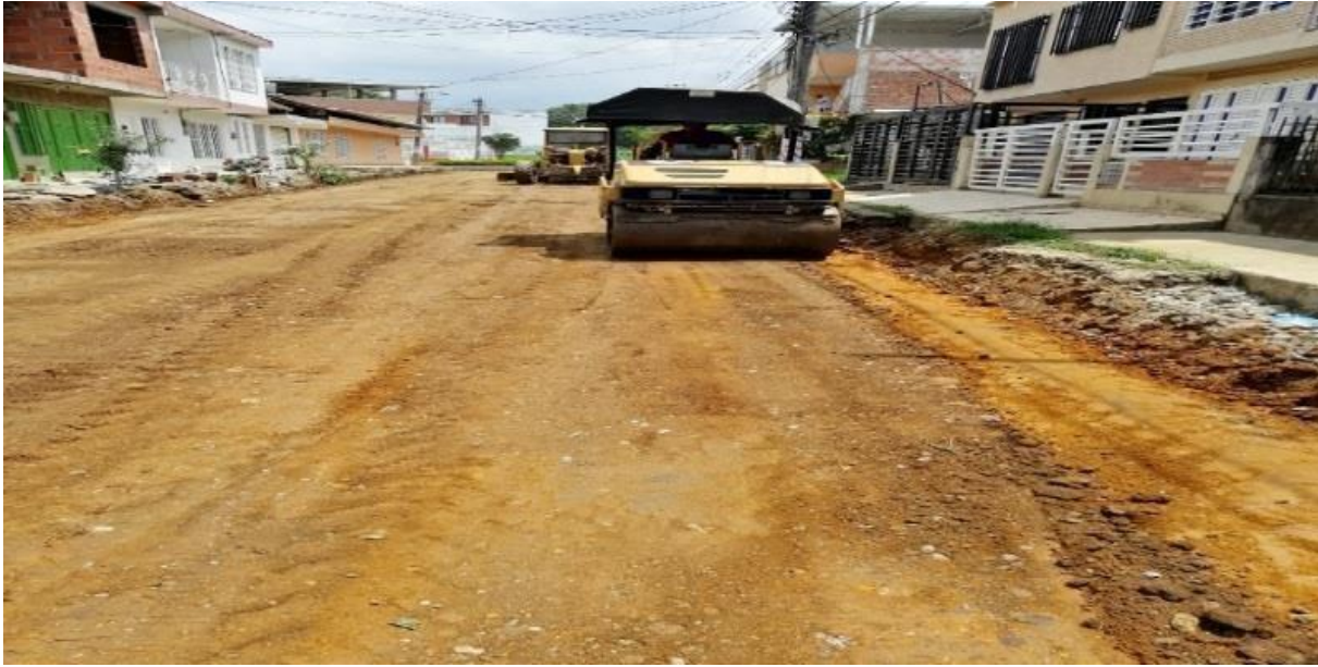
Ilustración 28. Compactación Subrasante
