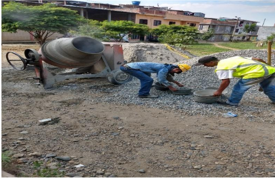
Ilustración 49. Dosificación del material
