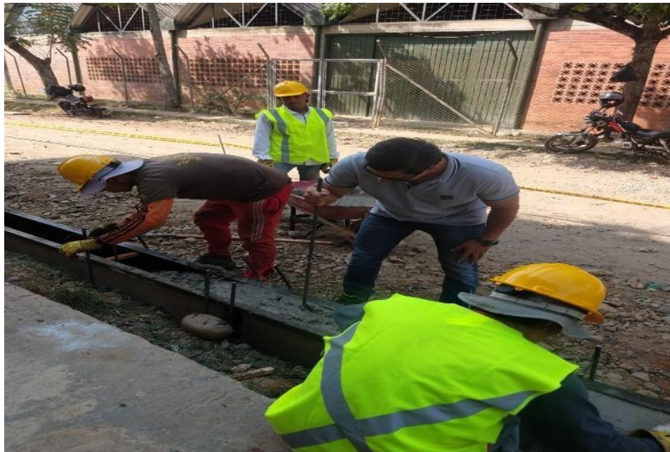
Ilustración 50. Fundición Sardinel
