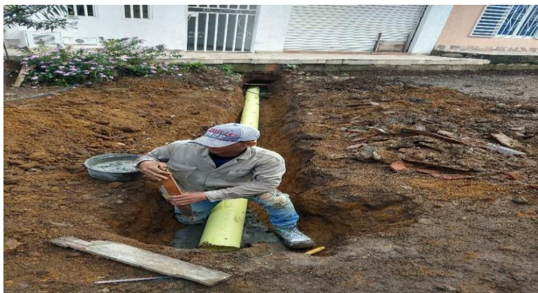
Ilustración 23. Cambio a tubería PVC
