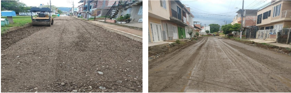
Ilustración 36. Compactación, conformación del material Sub-base
