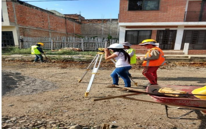
Ilustración 46. Toma niveles de sardinell
