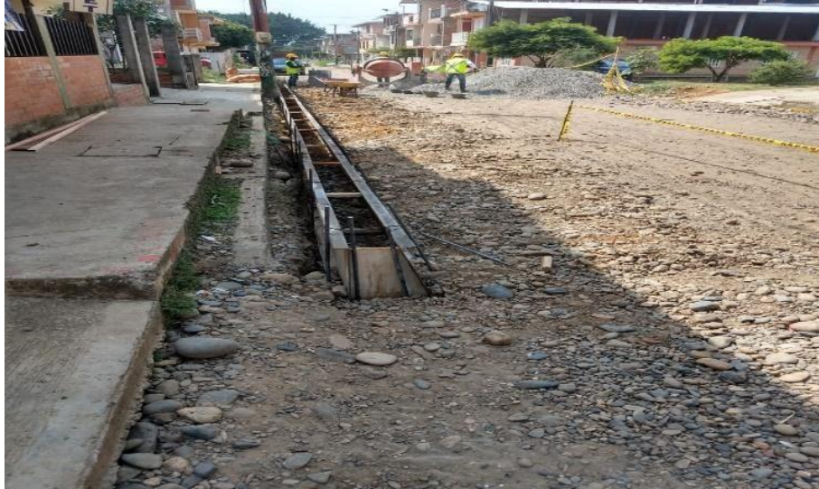
Ilustración 48. Colocación formaleta
