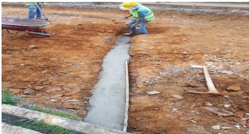
Ilustración 26. Red domiciliaria recubierta
