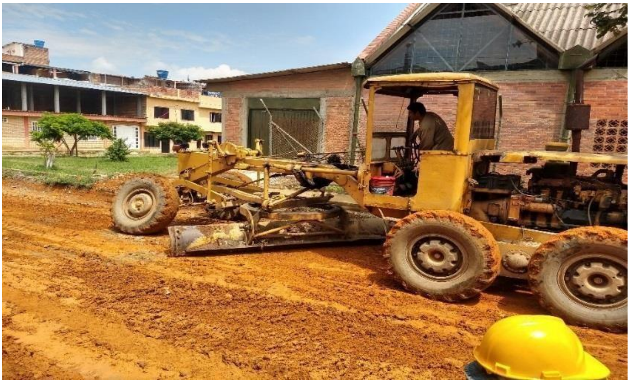
Ilustración 27. Conformación subrasante
