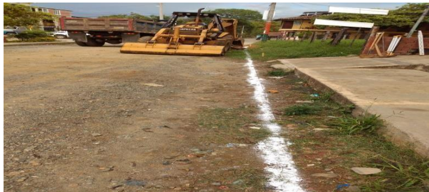
Ilustración 15. Señalización con Cal. Calle 11B entre carrera 16 y 18.
