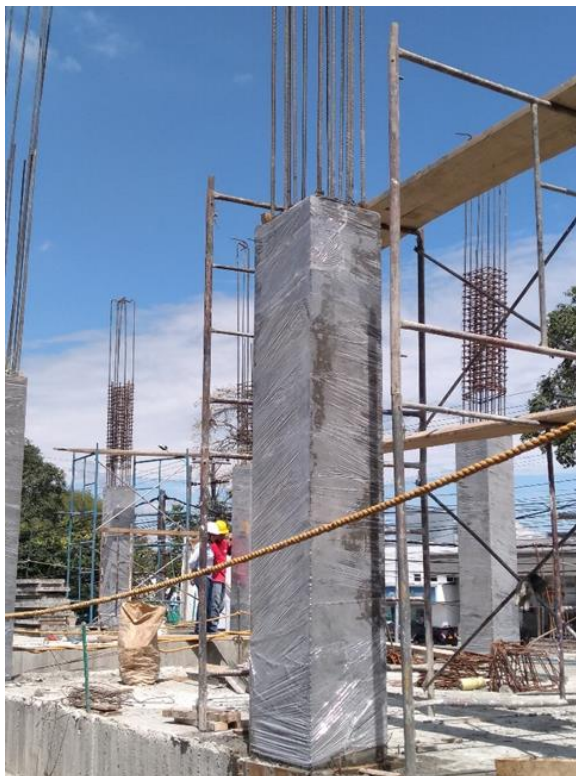
Figura 18. Colocación de la película plástica en toda la columna.
