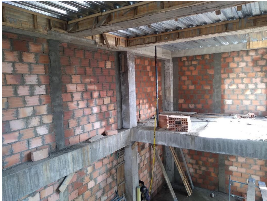
Figura 45. Mampostería instalada en los ejes 5 y D en el primer y segundo piso.
