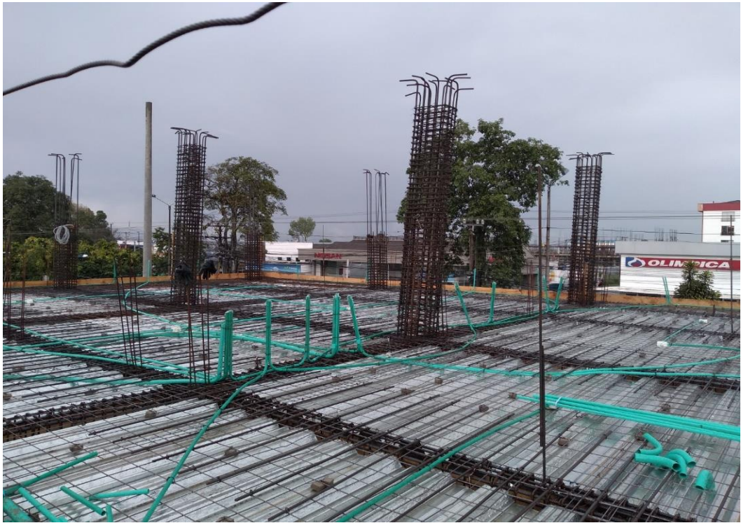
Figura 32. Colocación de los separadores en concreto con espesor de 4 cm e instalación de tubería eléctrica.
