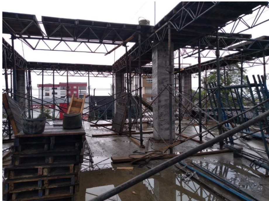
Figura 36. Camas de soporte para las vigas de cubierta.
