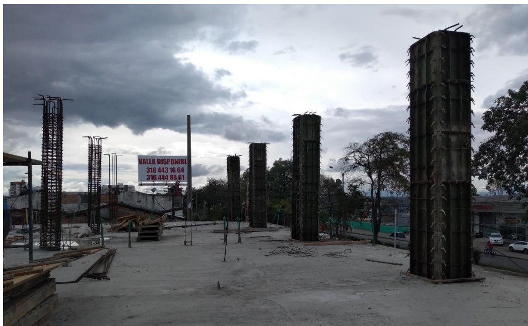
Figura 21. Primera serie de columnas listas para fundir ubicadas en el eje A.
