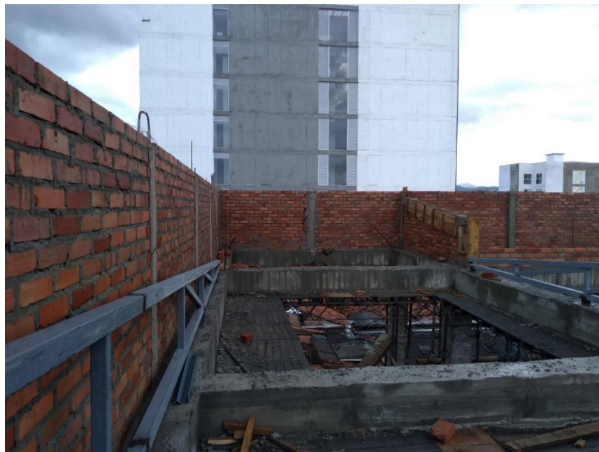
Figura 46. Sección de culata instalada correspondiente al eje D y 5.
