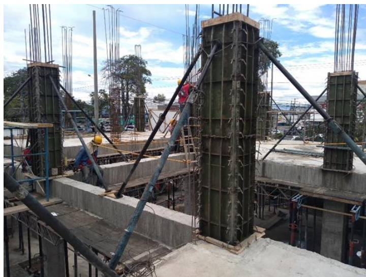
Figura 15. Encofrado de columnas del segundo nivel.
