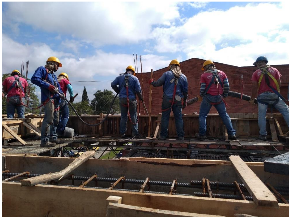
Figura 40. Comienzo de fundición de vigas de cubierta y operario del vibrador de concreto.
