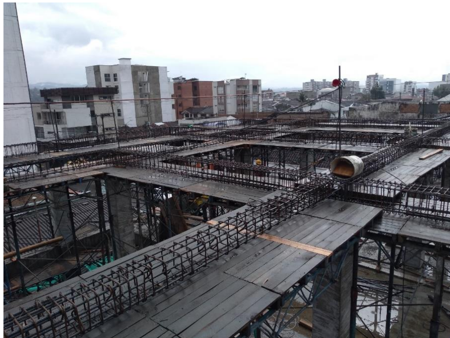
Figura 38. Vigas de cubierta totalmente armadas con sus respectivos aceros longitudinales y transversales.
