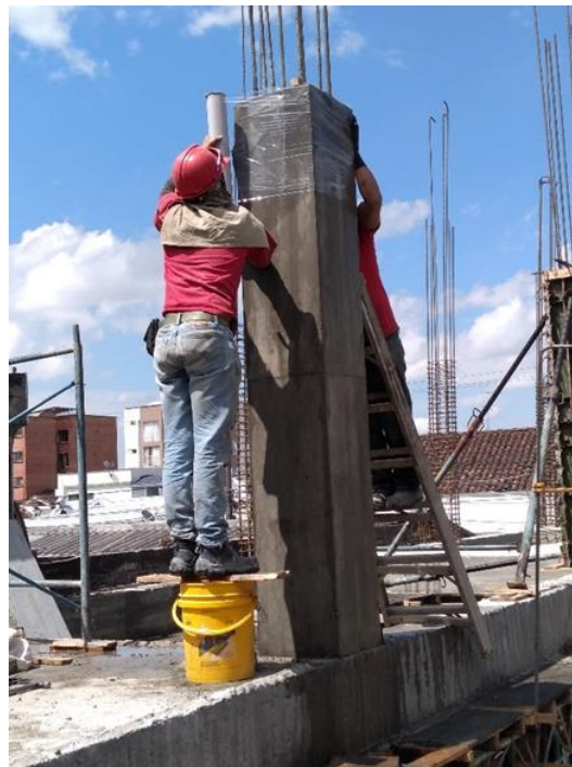
Figura 17. Columna totalmente hidratada y empezando la colocación de la película plástica.
