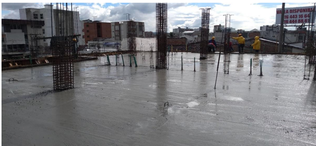
Figura 34. Losa y vigas del tercer piso totalmente fundidos.
