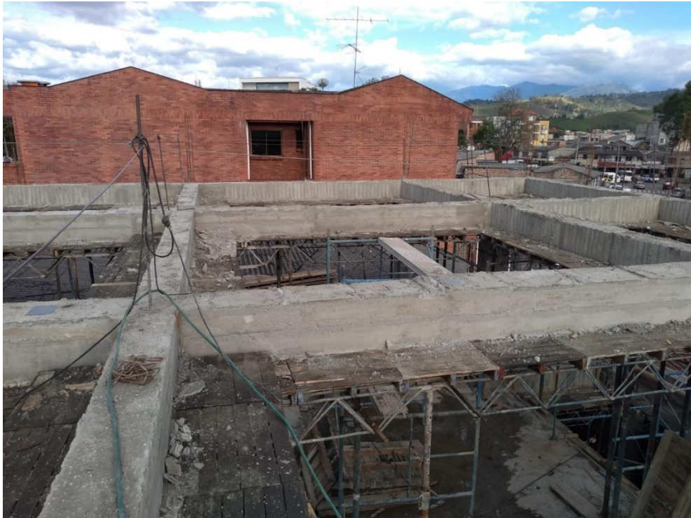
Figura 41. Vigas de cubierta al siguiente día de la fundición.
