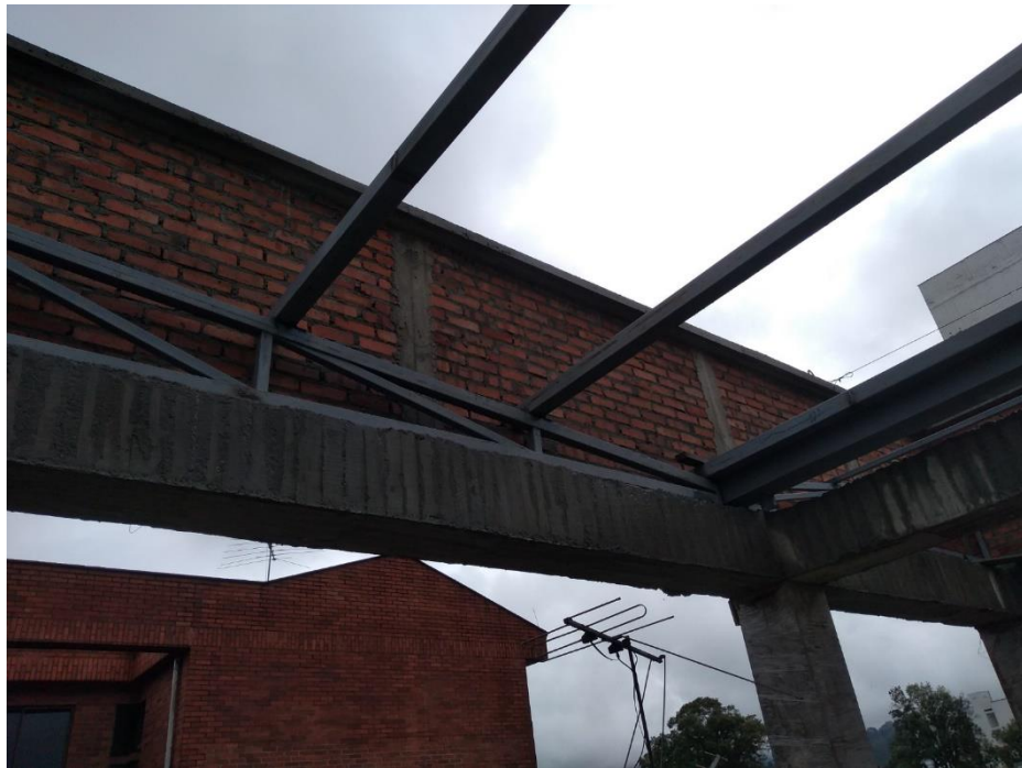
Figura 47. Culata terminada con la alfajía de concreto en la parte superior.
