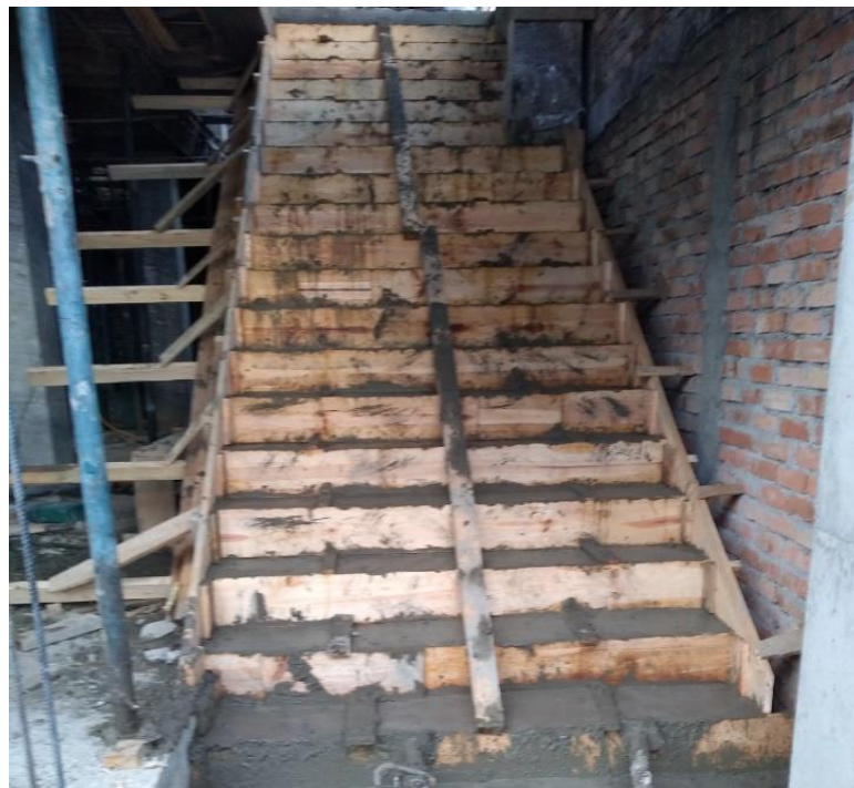
Figura 43. Formaleta para escalera expuesta y totalmente fundida.
