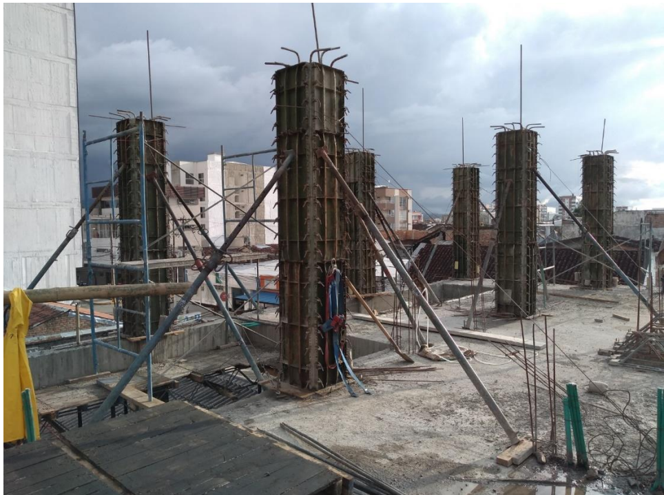
Figura 23. Última serie de columnas fundidas, se observa el apuntalamiento de la formaleta y las plomadas.
