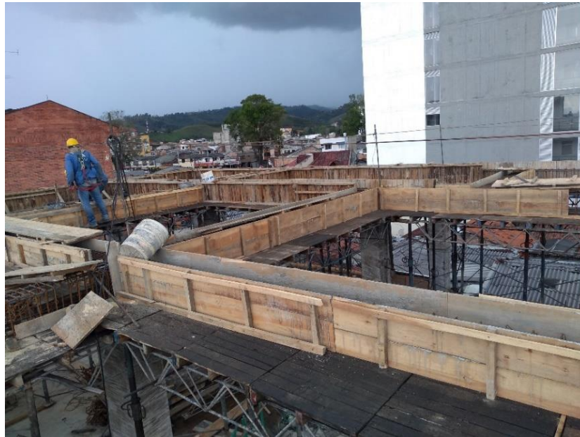
Figura 39. Proceso de encofrado de las vigas de cubierta.
