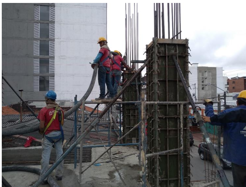
Figura 16. Fundición de columnas del segundo nivel.
