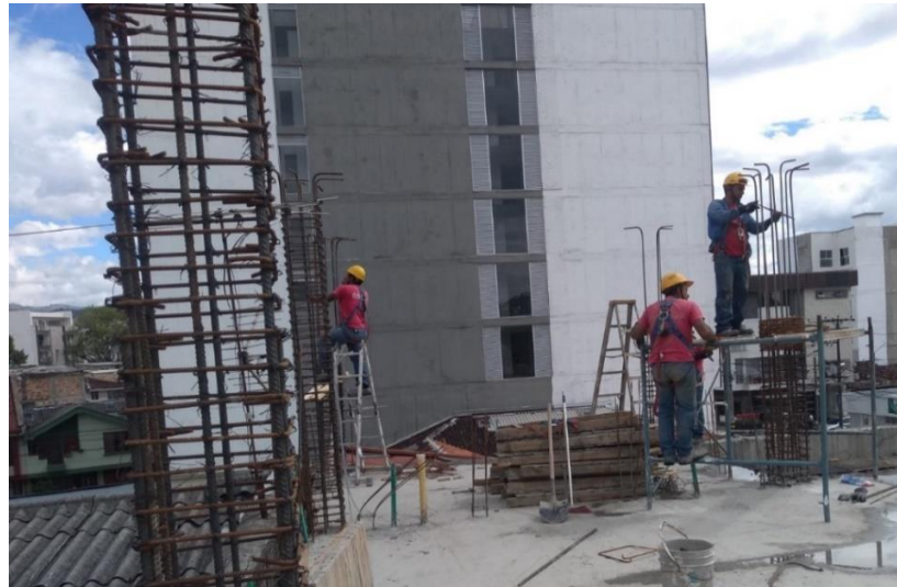
Figura 20. Colocación de estribos y ganchos tipo bastón en las columnas.
