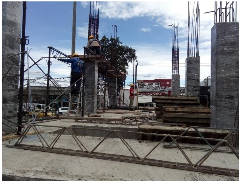
Figura 24. Colocación de cama de soporte en el eje 1.
