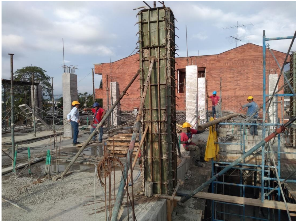
Figura 22. Evidencia de la fundición por series, donde se ve columnas en proceso de curado y columnas encofradas para ser fundidas al siguiente día.
