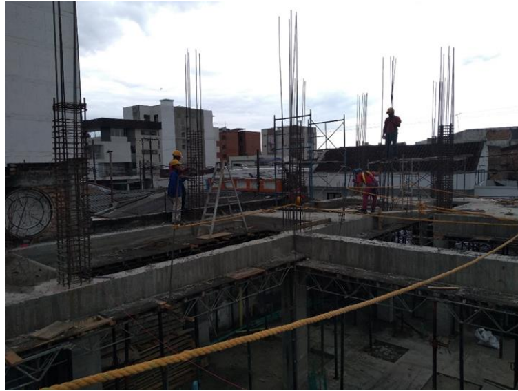
Figura 14. Colocación de estribos en las columnas del segundo nivel.
