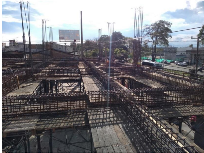
Figura 27. Vigas del tercer piso armadas y listas para empezar a encofrar.
