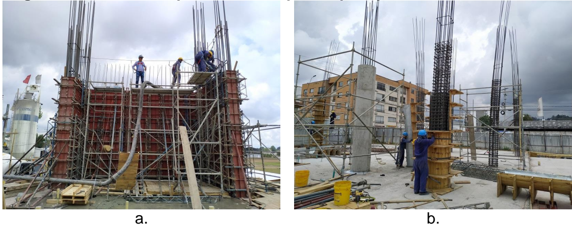
Figura 7 Fundición de pantalla P1 de primer piso y encofrado de columnas
