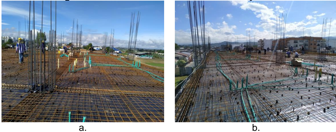
Figura 19 Instalación de tubería hidráulica y electrica
