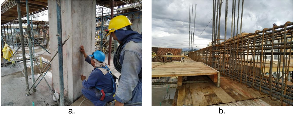
Figura 17 Armado de refuerzo de vigas de tercer piso
