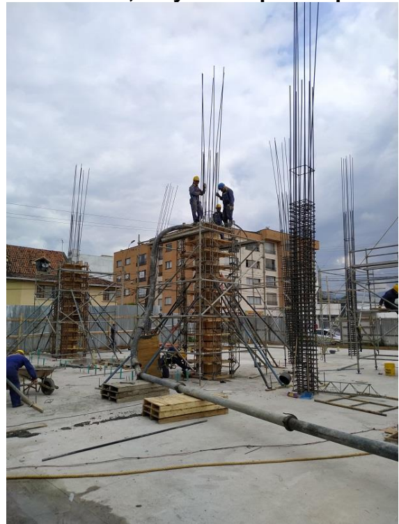
Figura 5 Fundición de pantalla P4 y columnas F3, F4 y G4 de primer piso
