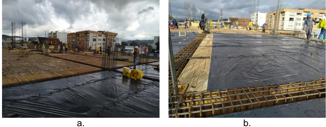
Figura 9 Instalación de tableros para la losa de segundo piso
