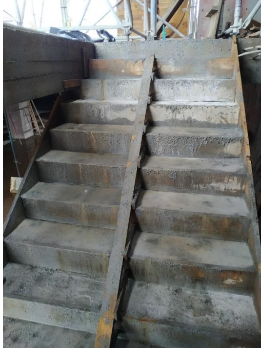
Figura 21 Fundición de escaleras de sótano
