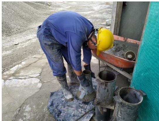
Figura 32 Toma de muestra concreto de losa de cuarto piso
