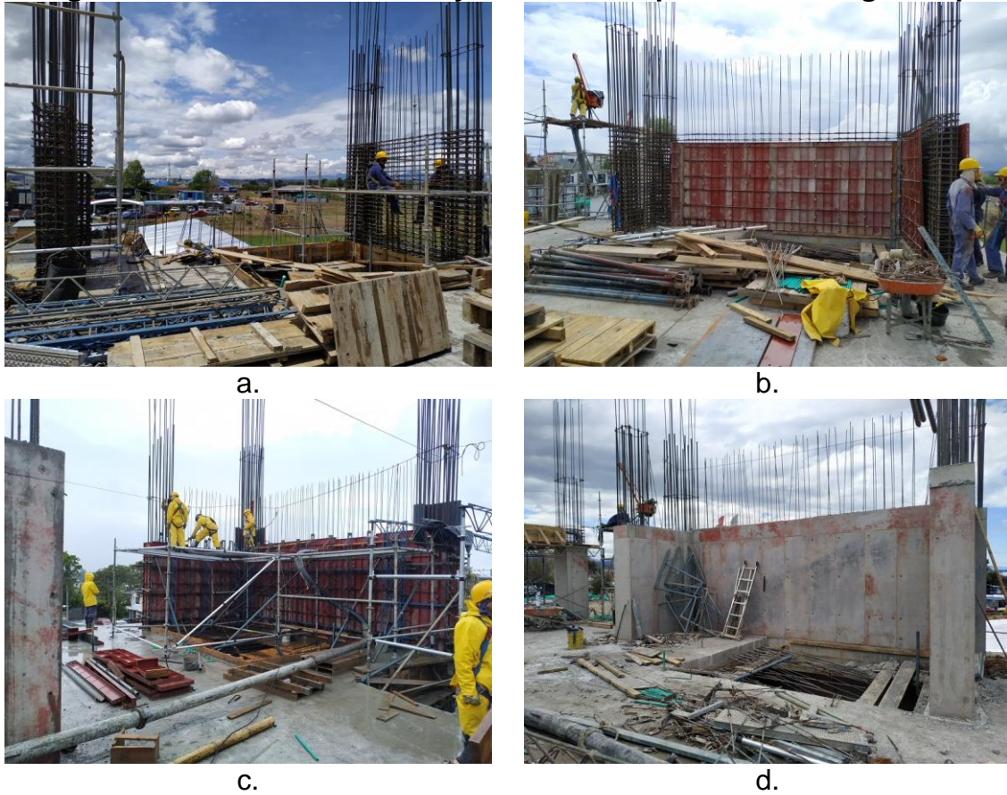
Figura 16 Armado de refuerzo y fundición de pantallas de segundo piso
