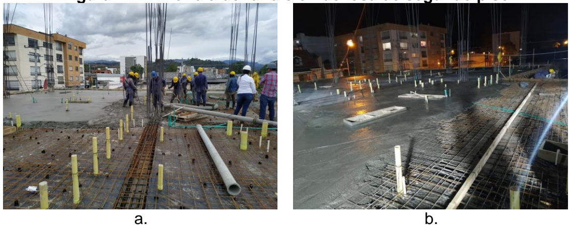
Figura 12 Primer día de fundición de losa de segundo piso
