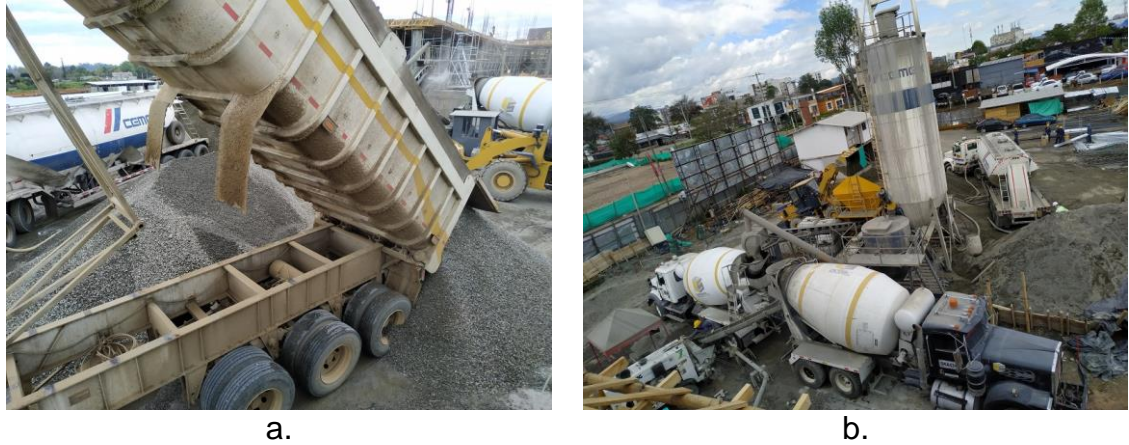
Figura 11 Abastecimiento de material para fundición
