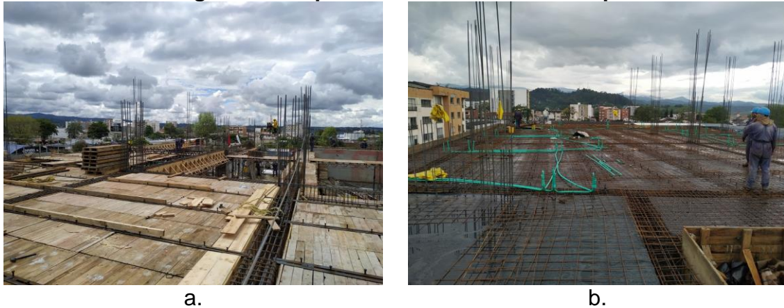
Figura 29 Preparación de losa de cuarto piso
