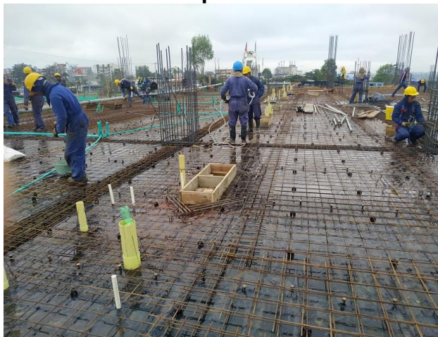
Figura 10 Instalación de malla electro soldada y tubería en losa de segundo piso
