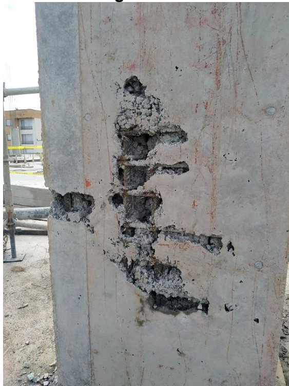
Figura 26 Demolición de columna E2 de tercer piso
