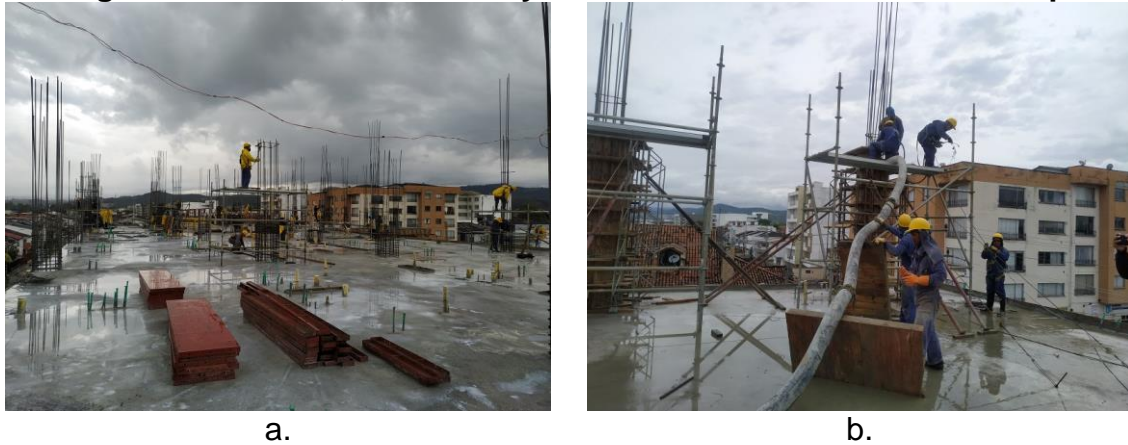
Figura 24 Armado, encofrado y fundición de columnas de tercer piso
