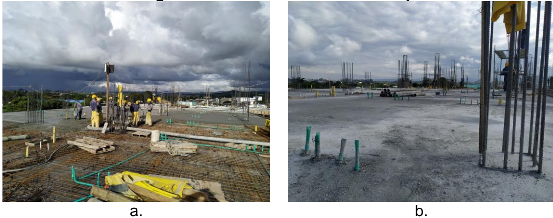
Figura 31 Fundición losa de cuarto piso
