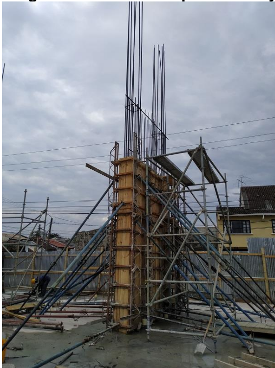
Figura 5 Fundición de pantalla P4 y columnas F3, F4 y G4 de primer piso
