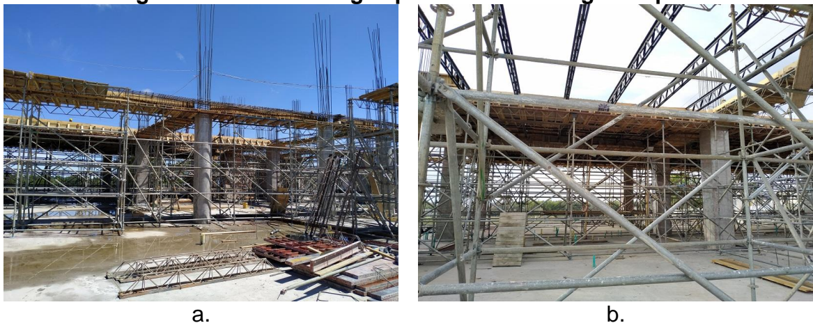
Figura 8 Armado de vigas para la losa de segundo piso
