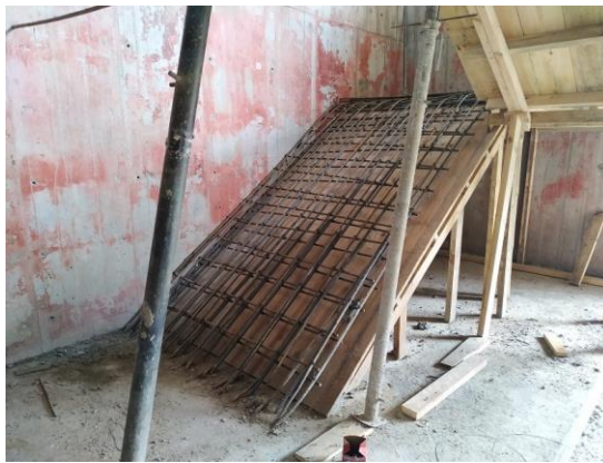
Figura 18. Armado de escalera 1 en nivel de sótano
