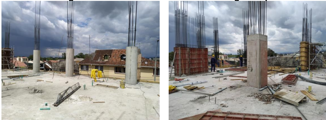
Figura 15 Fundición de columnas de segundo piso
