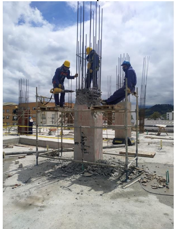
Figura 26 Demolición de columna E2 de tercer piso
