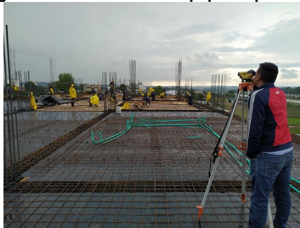
Figura 30 Nivelación con equipo de precisión
