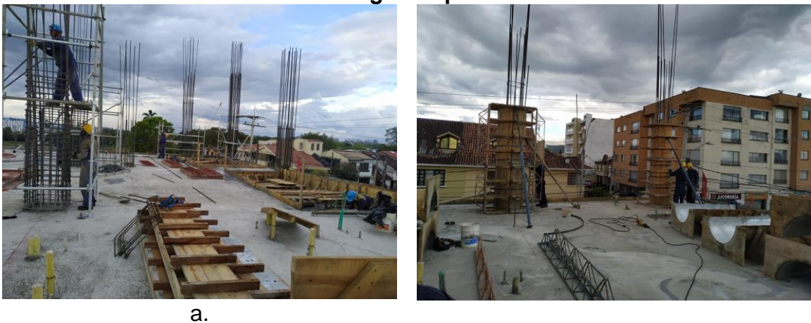
Figura 14 Armado de refuerzo e instalación de formaleta de columnas de segundo piso
