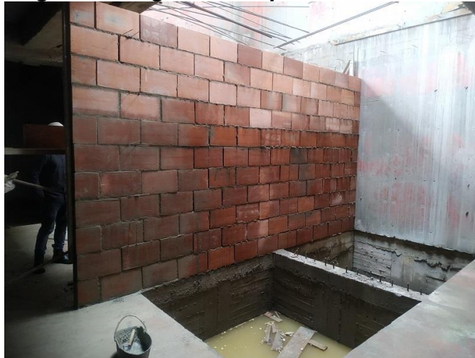
Figura 23 Pega de mampostería en sótano
