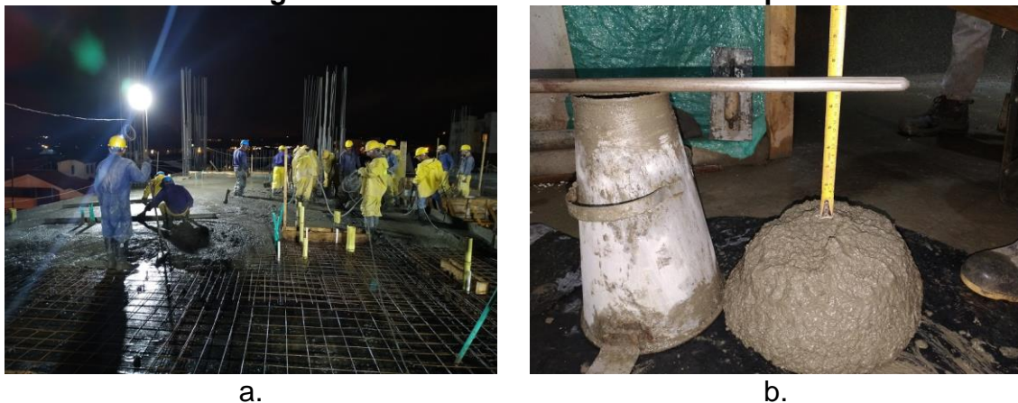
Figura 20 Fundición de losa de tercer piso
