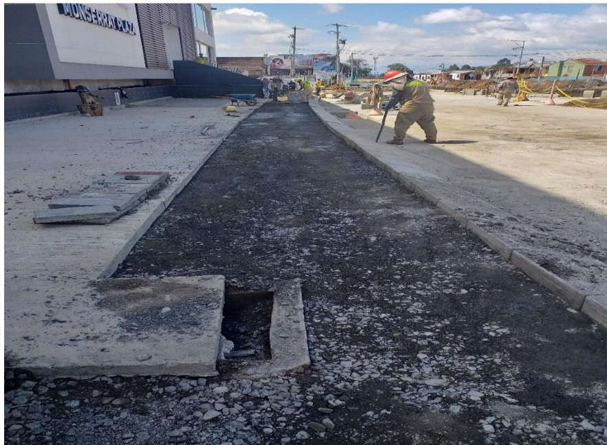
Imagen 42. Capa de arena espesor 4 cm para espacio público.
