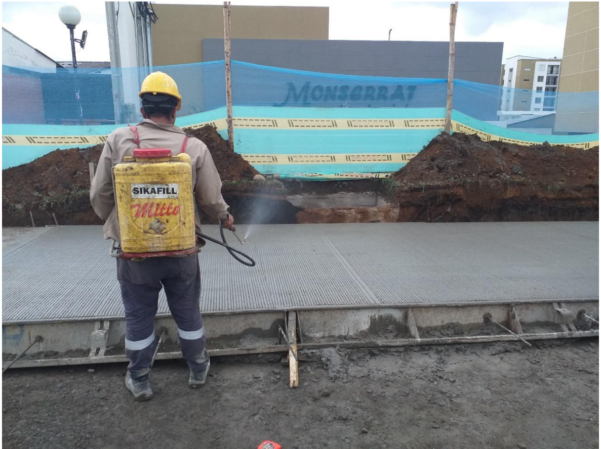
Imagen 24. Aplicación de Anti sol sobre la superficie de concreto.
