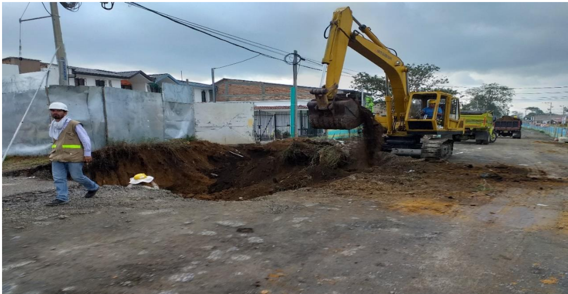
Imagen 10. Segundo frente de excavación K0+330
