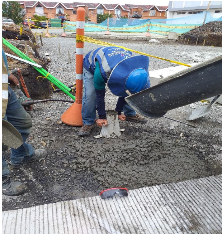
Imagen 35. Control de asentamiento, Slump.
