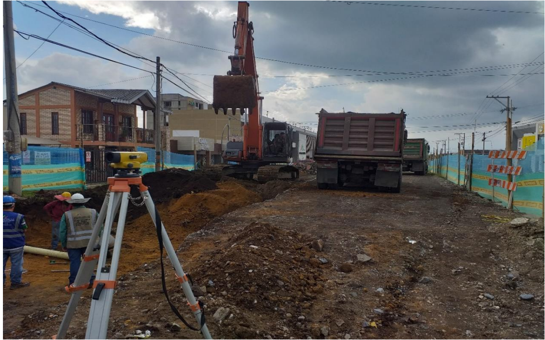
Imagen 9. Primer frente excavación abscisa K0+535
