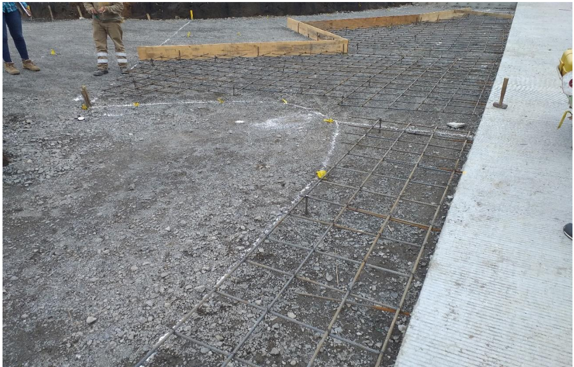
Imagen 30. Parrillas sencillas en losas irregulares.
