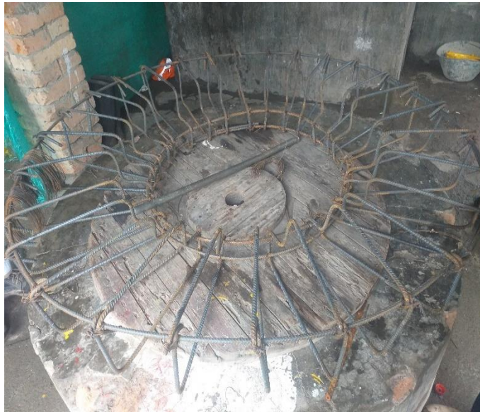
Imagen 40. Acero figurado para construcción de brocal en cámara de inspección.
