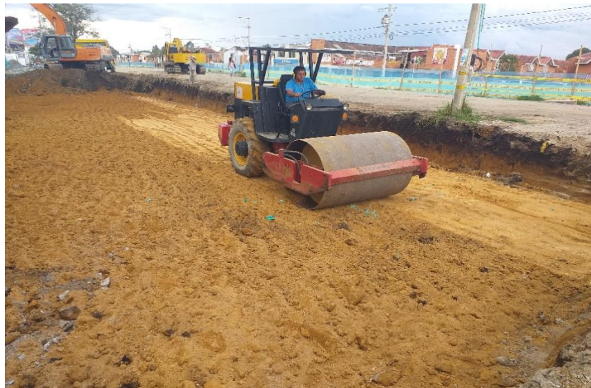
Imagen 14. Compactación de la sub rasante con rodillo liso de 13 ton/m 2 .
