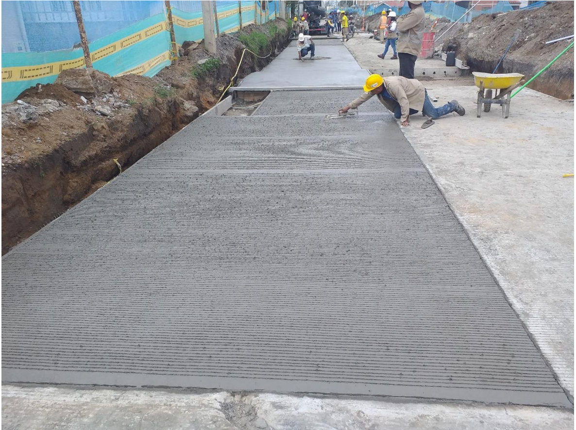
Imagen 23. Macro texturizado de la superficie de concreto.
