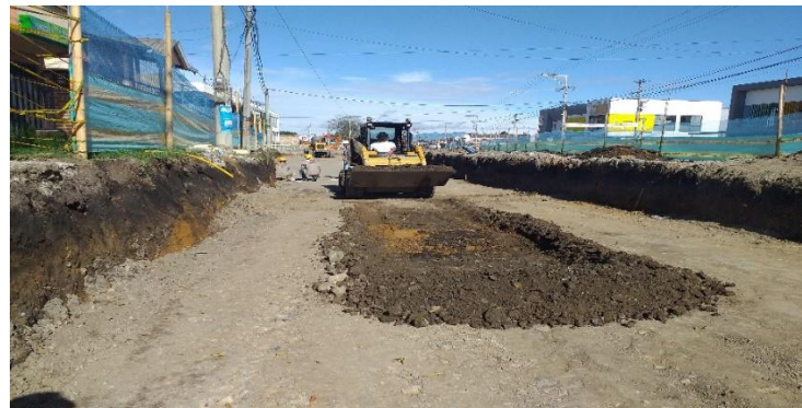
Imagen 17. Retiro de fallo en material de mejoramiento.
