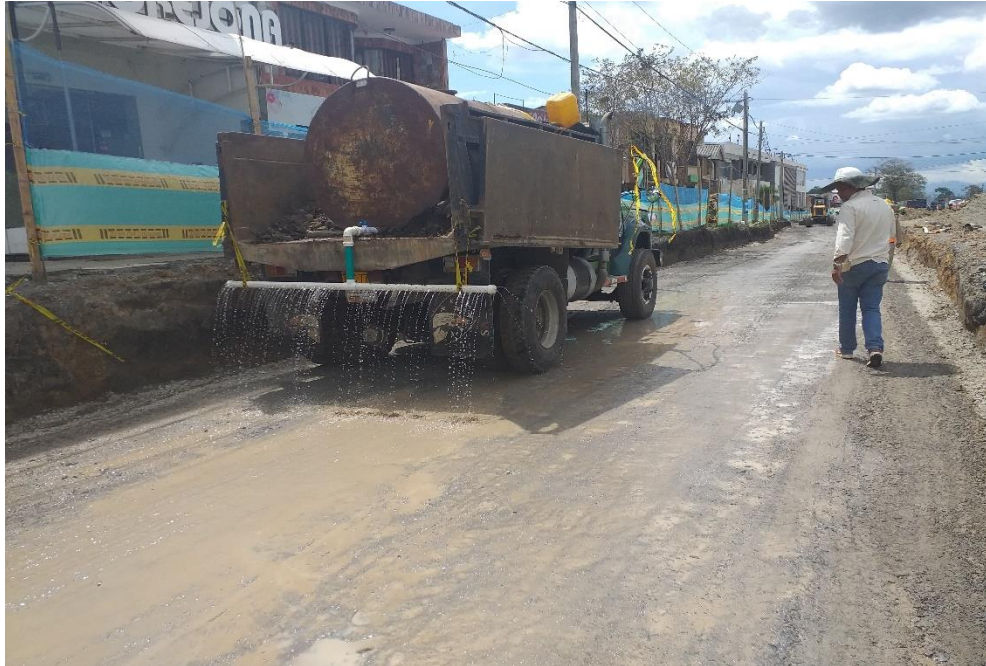
Imagen 15. Tanque de riego para compactar sub base granular.
