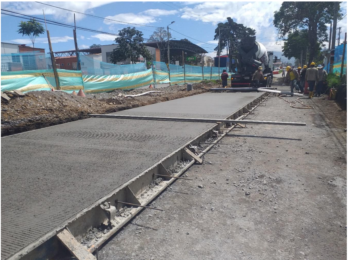
Imagen 25. Barras de amarre perpendiculares en junta longitudinal-carril izquierdo.
