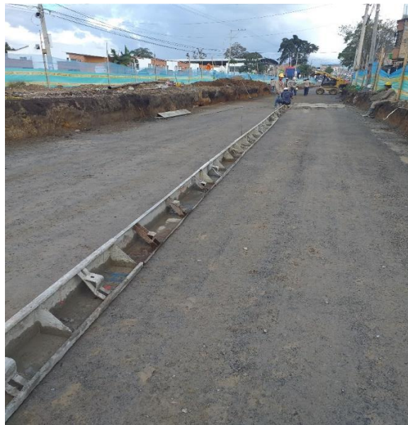
Imagen 18. Instalación de formaleta carril izquierdo.
