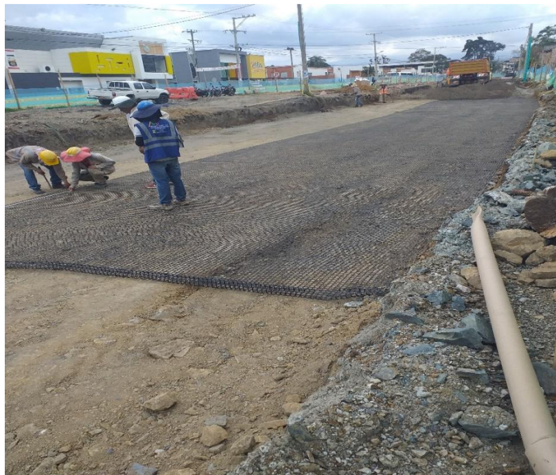
Imagen 13. Geomalla biaxial extendida.
