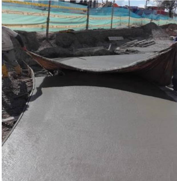
Imagen 22. Proceso de micro texturizado sobre el concreto con tela de fique.
