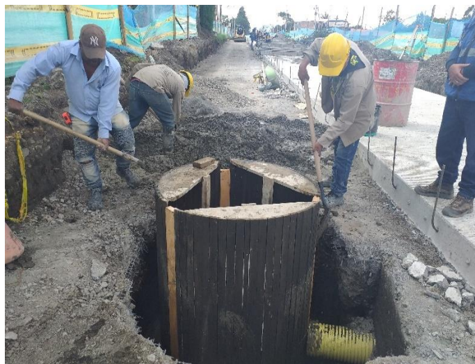
Imagen 41. Formaleta para fundir cámara de inspección de aguas lluvia, K0+220.
