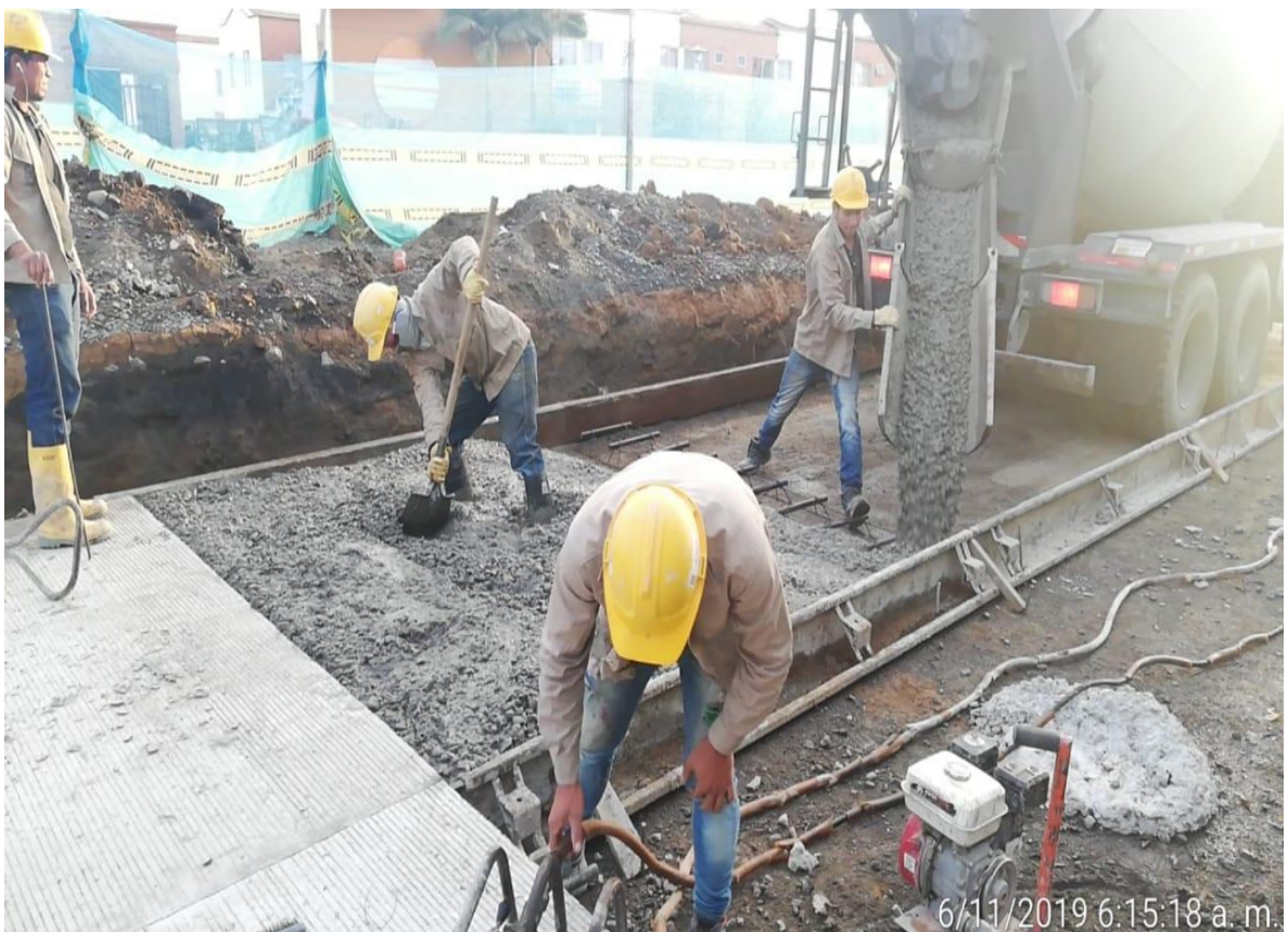
Imagen 19. Vaciado de mezcla de concreto hidráulico.
