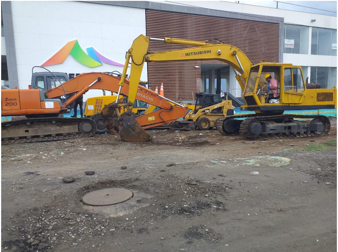
Imagen 11. Retroexcavadoras "Hitachi ZAXIS 200" y "Mitsubishi MS070"
