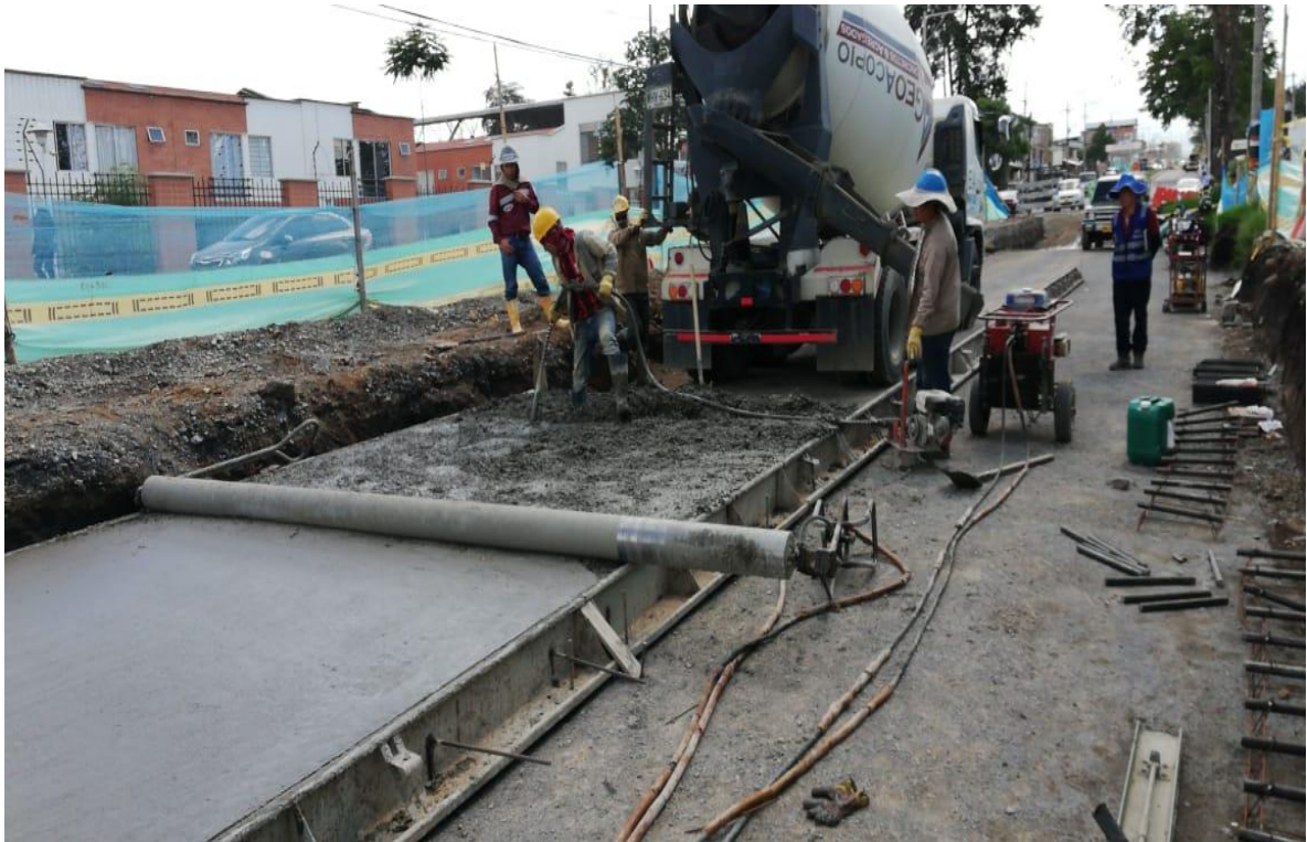
Imagen 20. Vibrado de mezcla de concreto con vibrador de aguja.
