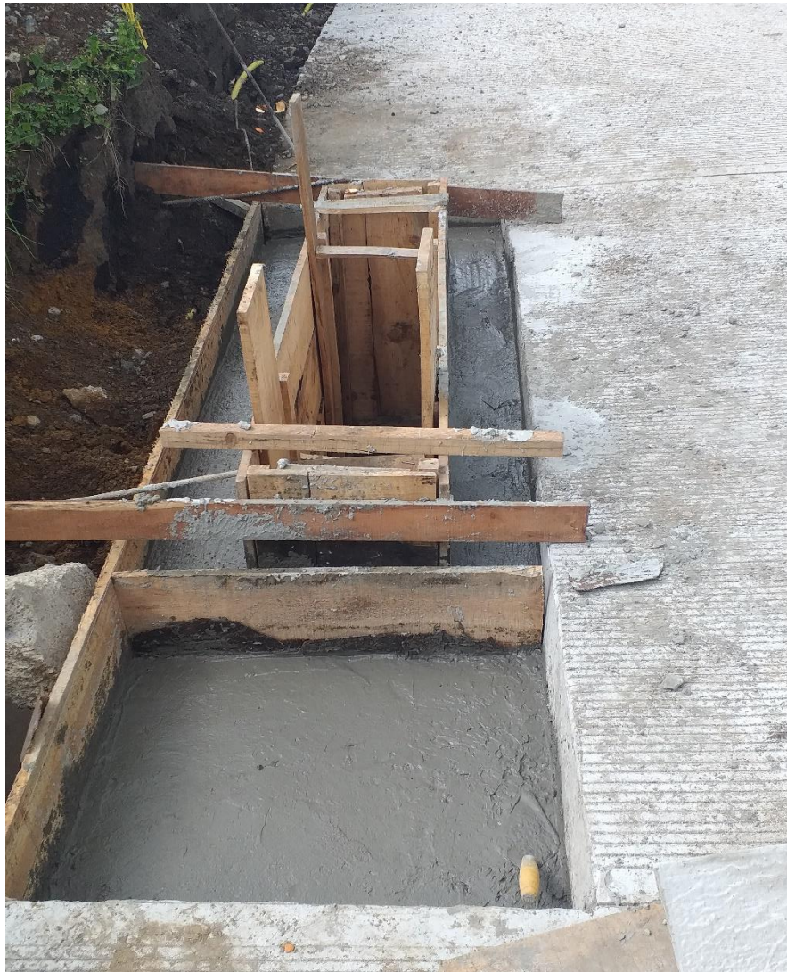
Imagen 37. Sumidero en construcción K0+227.
