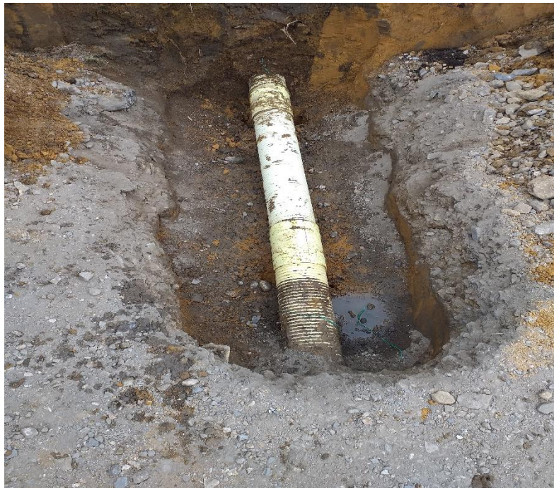
Imagen 38. Tubería de alcantarillado de diámetro 6" reparada con unión en PVC 6".
