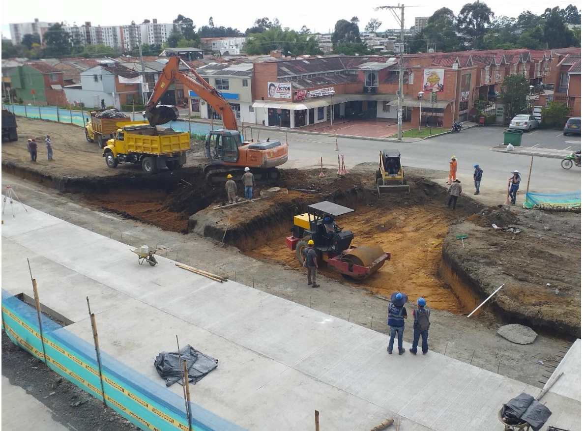
Imagen 1. Proyecto construcción de la calzada sur doble carril vía al bosque.
