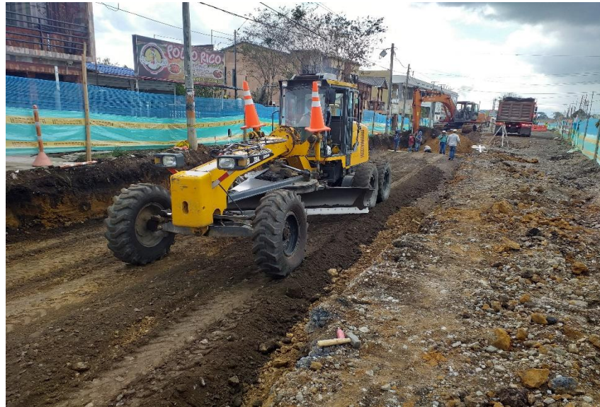
Imagen 12. Material de mejoramiento extendido por la motoniveladora.
