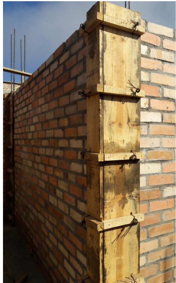
Ilustración 38 Encofrado de columnas de confinamiento.
