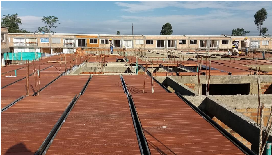
Ilustración 24 Instalación de perfiles y elementos aligerantes (bloques)
