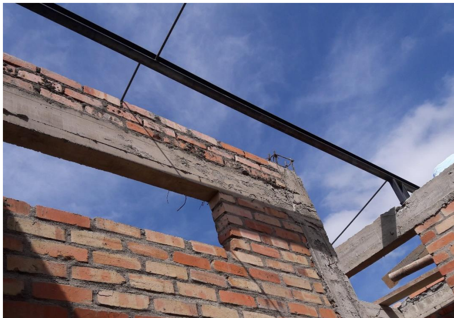
Ilustración 56 Instalación de cubierta
