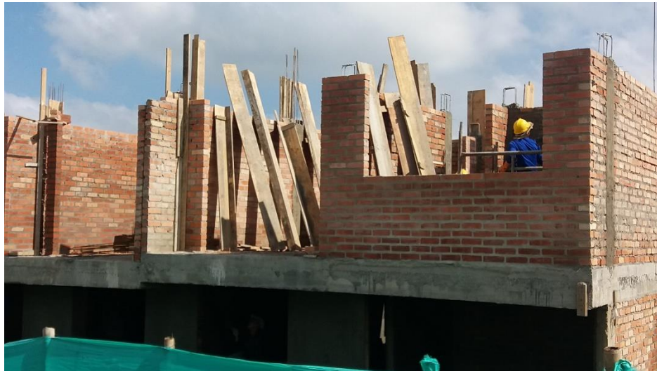
Ilustración 40 Desencofrado de columnas de confinamiento
