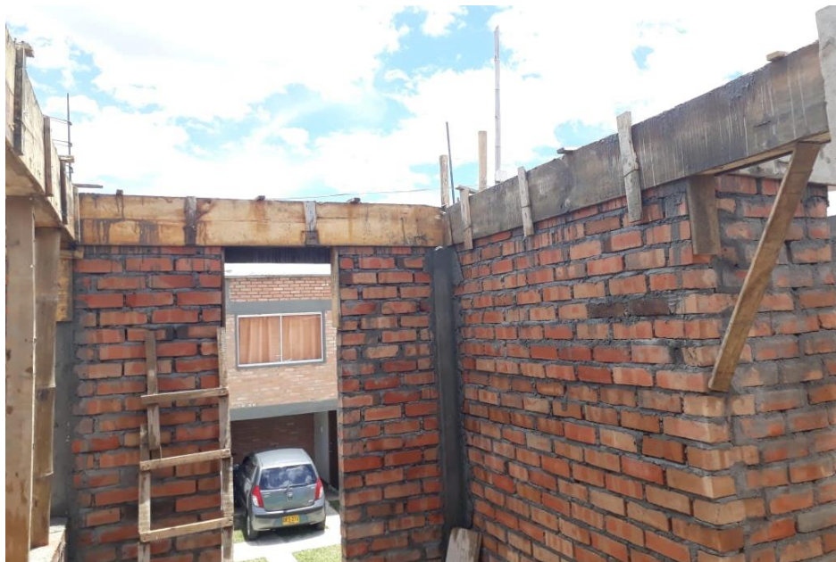
Ilustración 46 Encofrado de vigas de cubierta
