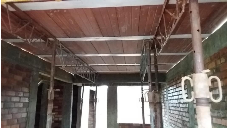
Ilustración 25 instalación de elementos de soporte.
