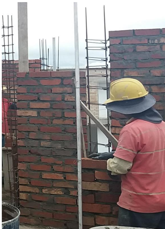
Ilustración 32 Construcción de muros
