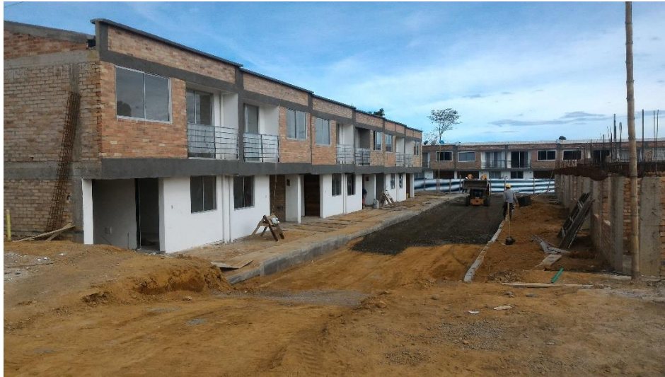
Ilustración 12 Expansión de la subbase
