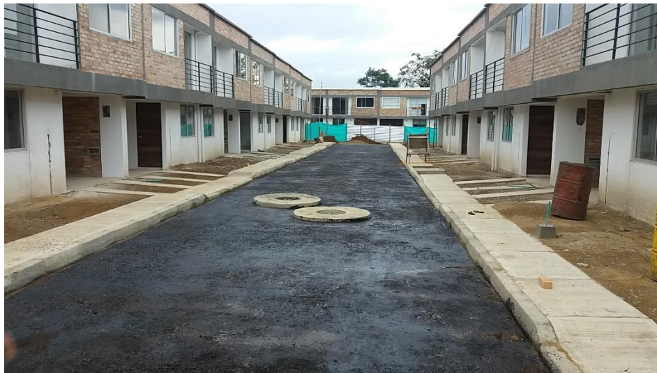
Ilustración 19 Imprimación con emulsión asfáltica.
