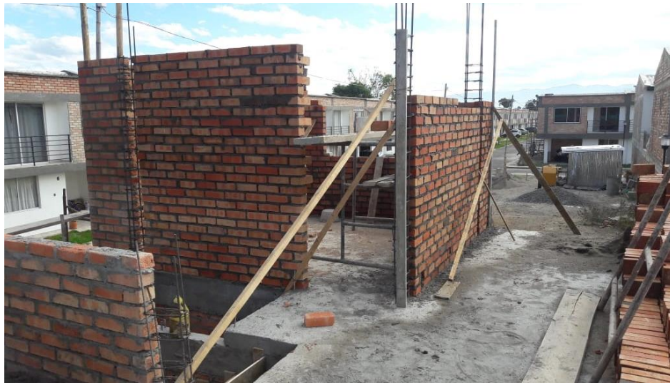
Ilustración 33 Construcción de muros
