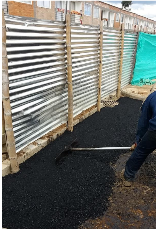
Ilustración 20 Expansión manual de mezcla asfáltica
