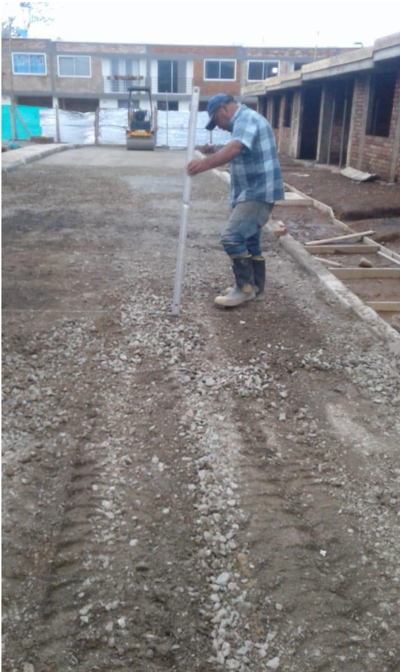
Ilustración 16 Nivelación de la base.
