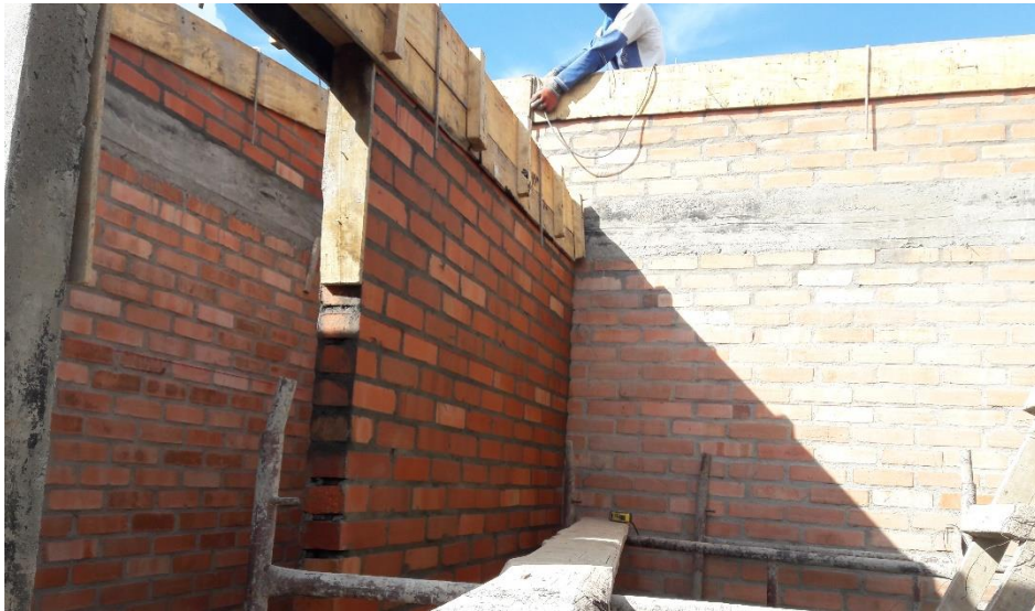
Ilustración 52 Fundición cintas de amarre
