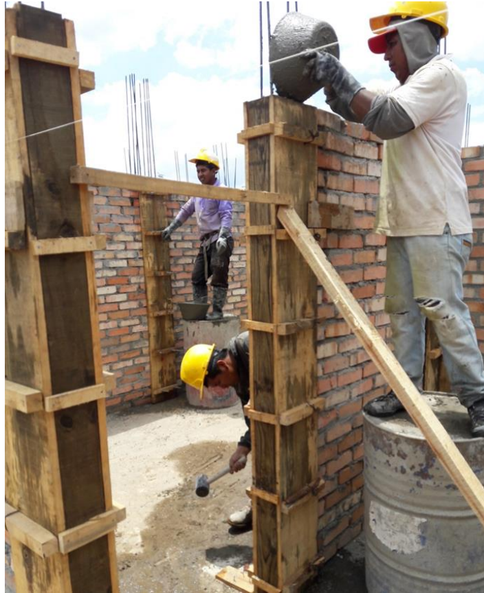
Ilustración 39 Fundición de columnas de confinamiento.
