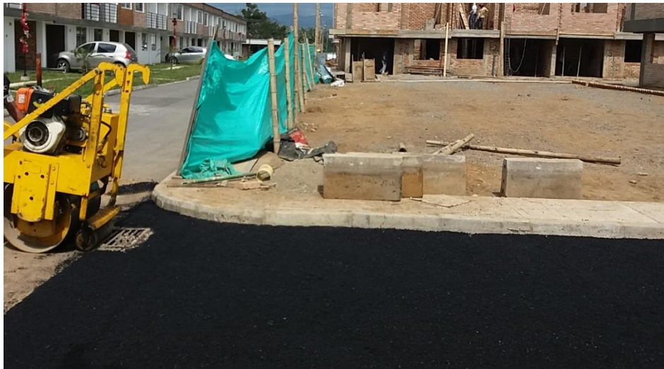
Ilustración 21 Compactación manual de la mezcla asfáltica en sectores de difícil acceso
