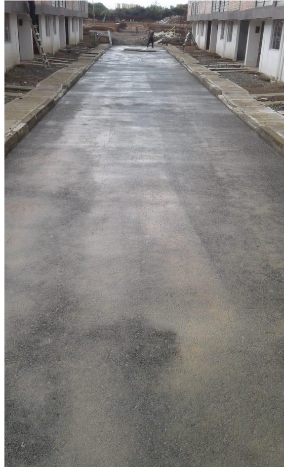
Ilustración 17 Base compactada
