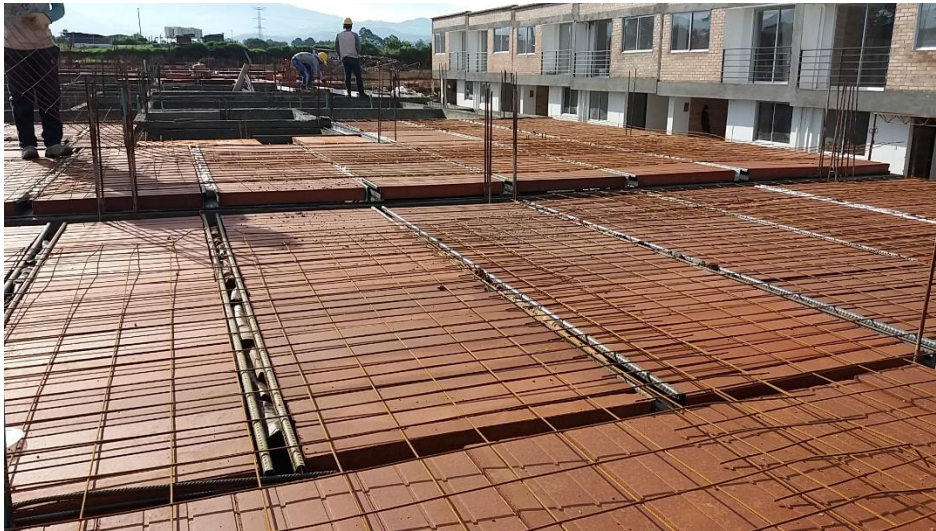
Ilustración 26 Instalación de refuerzo para temperatura (malla electro soldada)
