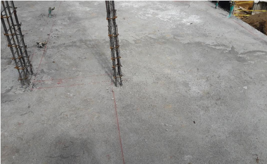
Ilustración 32 Replanteo.
