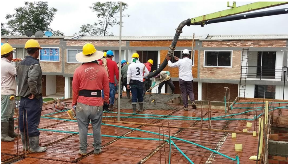
Ilustración 28 Fundición de losa aligerada
