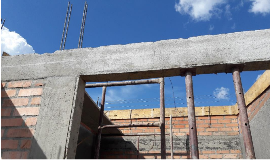
Ilustración 51 Encofrado cintas de amarre
