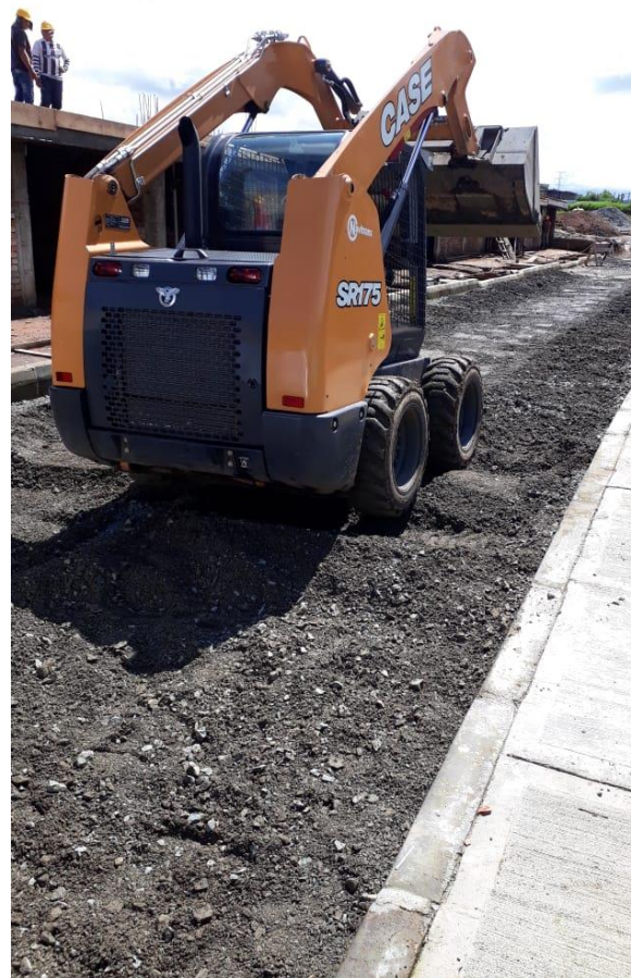
Ilustración 15 Expansión de la base.
