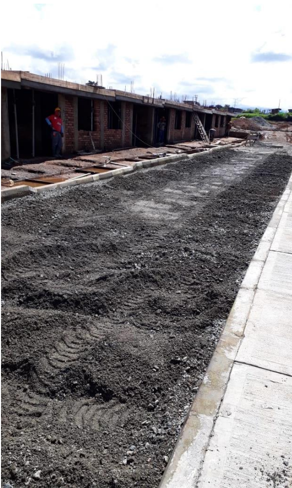
Ilustración 14 Disposición de la base.
