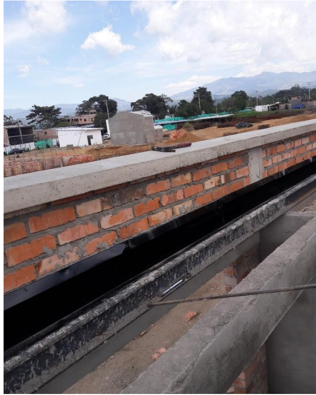
Ilustración 57 Instalación de canal
