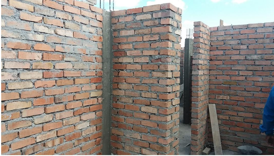
Ilustración 42 Columnetas de confinamiento culminadas
