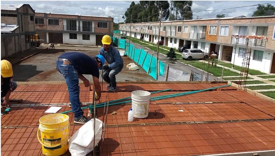
Ilustración 27 Instalación de tubería eléctrica e hidráulica
