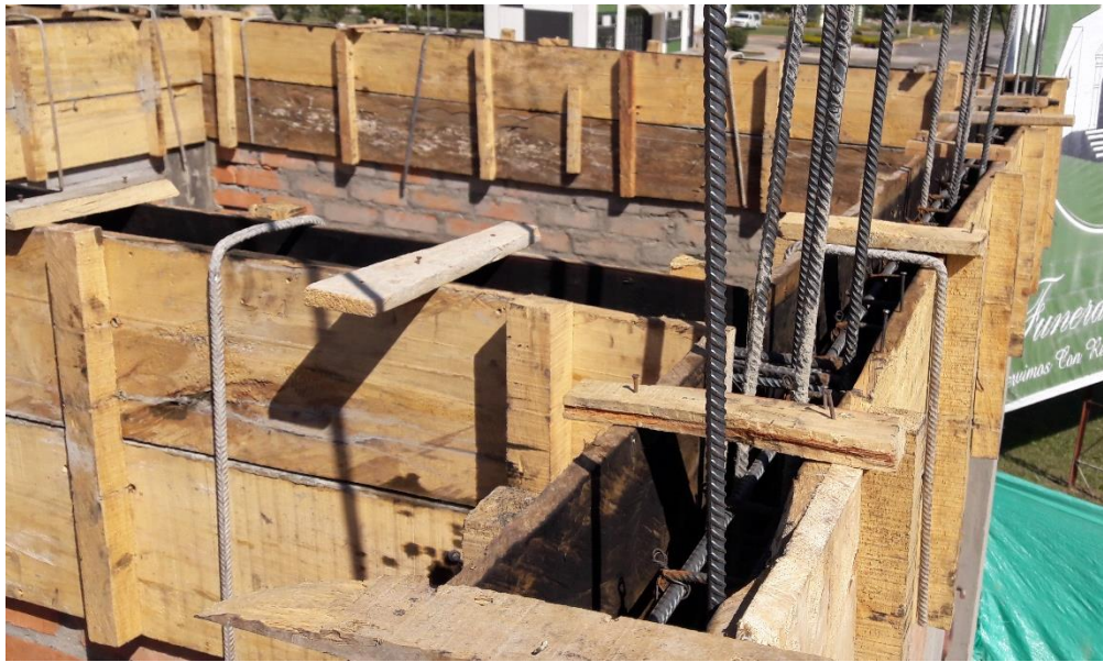
Ilustración 47 Encofrado de vigas de cubierta vista elevación.
