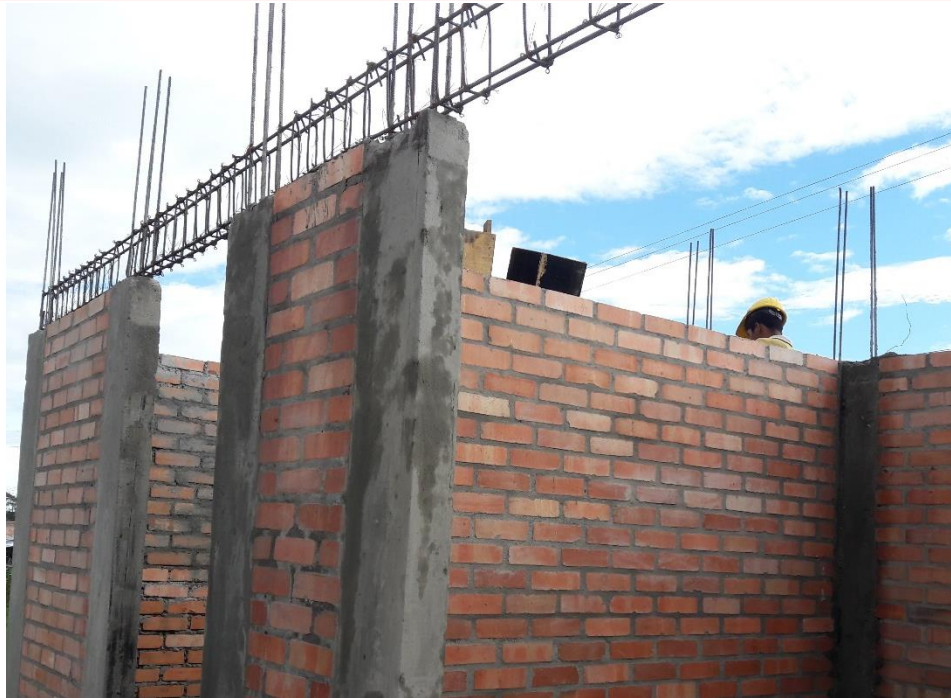
Ilustración 44 Instalación de aceros
