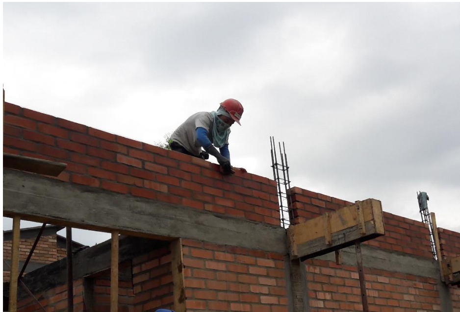
Ilustración 46 Construcción de las culatas
