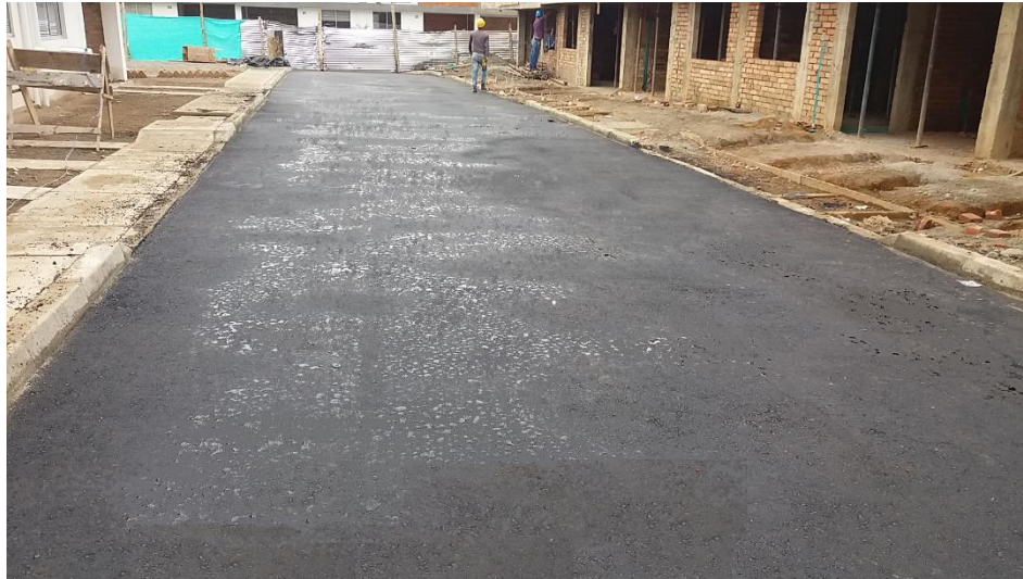
Ilustración 22 Carpeta asfáltica culminada
