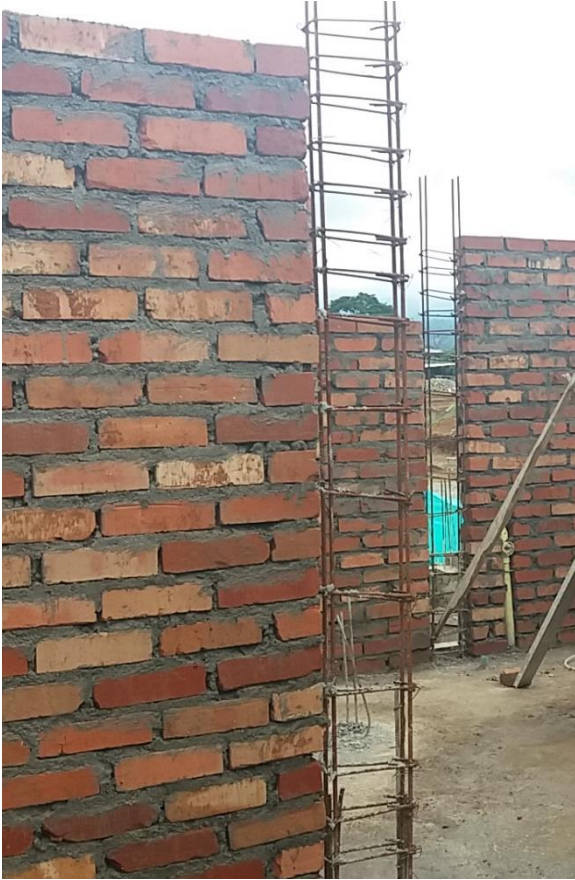
Ilustración 37 Refuerzo de columnas de confinamiento.
