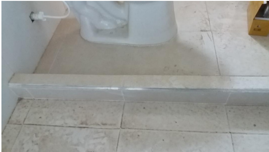
Ilustración 74 Brocal desnivelado
