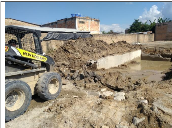
Fotografía 121. Demolición rampa de cargue.
