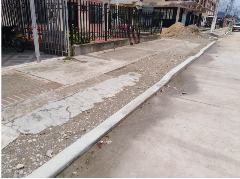
Fotografía 70. Llenado andenes con material tipo recebo saliente de excavación.
