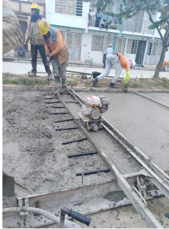
Fotografía 29. Instalación de Dovelas y regla vibratoria.
