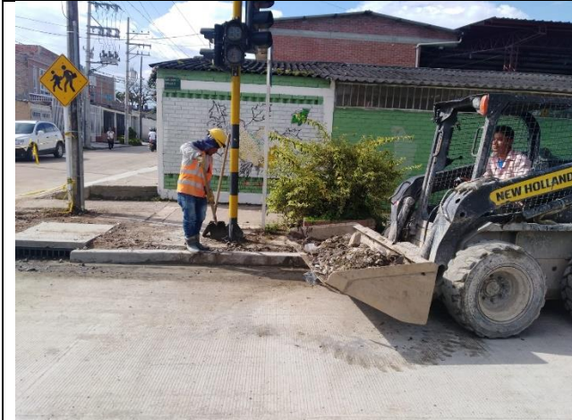
Fotografía 71. Recogida de escombros y sobrantes de obra de andenes.
