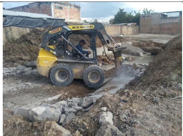
Fotografía 122. Demolición rampa de cargue.
