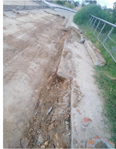
Fotografía 25. Corte de andenes para completar ancho de la vía.
