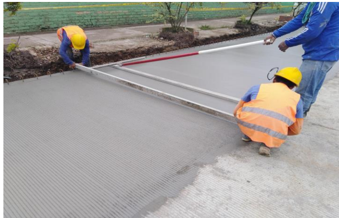
Fotografía 4. Texturizado de superficie de losas.
