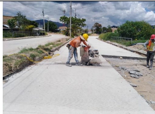
Fotografía 37. Corte de las losas para junta.
