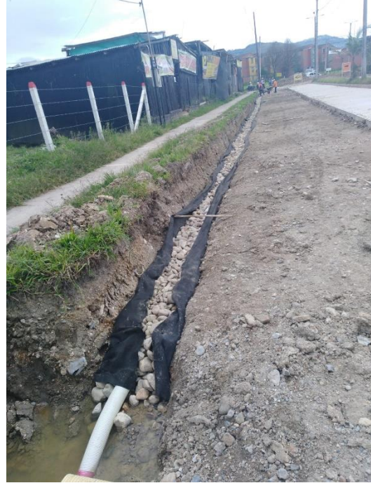
Fotografía 43. Manguera dentro de la piedra y el geotextil que llega a sumidero.
