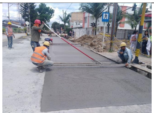
Fotografía 66. Texturizado de concreto después de fundir.
