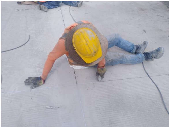
Fotografía 47. Aplicación de pegante Sika.
