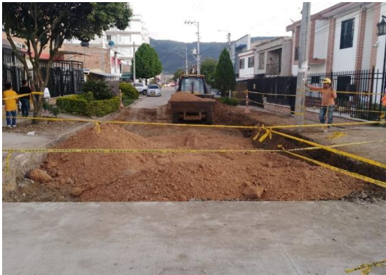
Fotografía 16. Aplicación de sub-base en calle 4.
