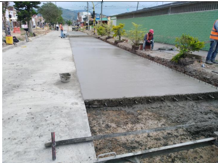
Fotografía 7. Tramo fundido con acero para bordillo instalado.
