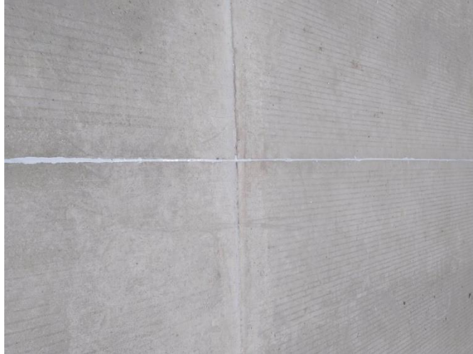
Fotografía 49. Sellado de juntas.
