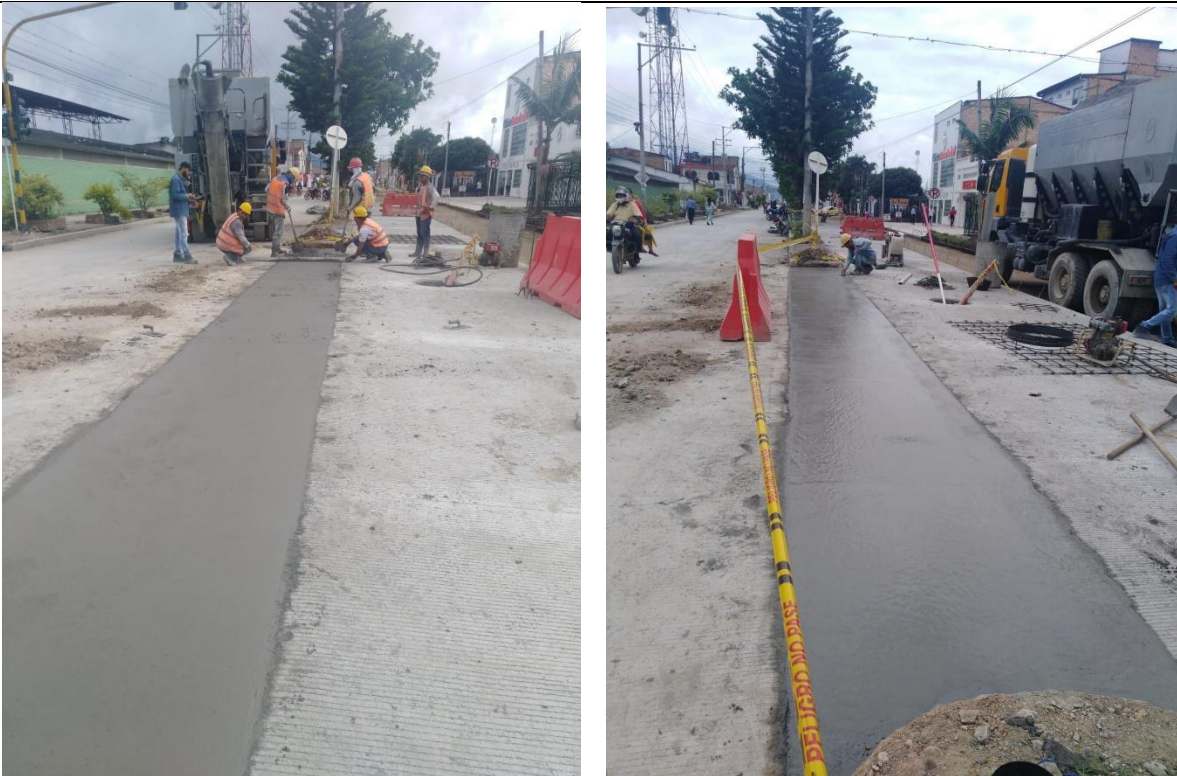
Fotografía 41. Fundición de centrales en intersecciones.
