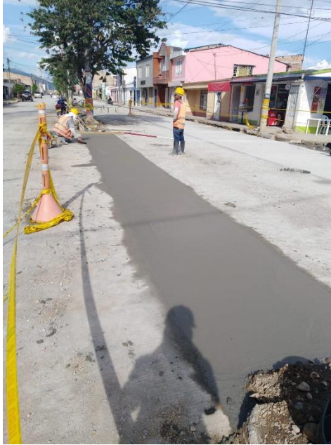
Fotografía 40. Fundición de central en intersección.
