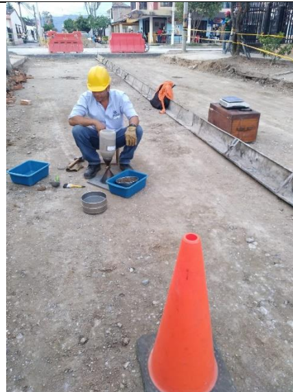
Fotografía 19. Ensayo de arena y cono para determinar densidad de sub-base.
