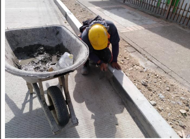
Fotografía 102. Resane de fisuras.
