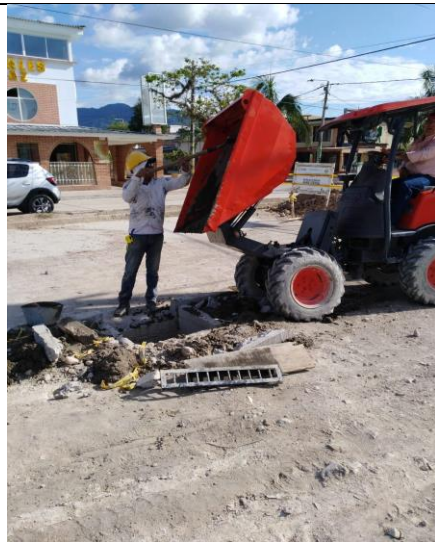
Fotografía 51. Fundición de solado de sumideros e instalación de rejillas de captación lateral.
