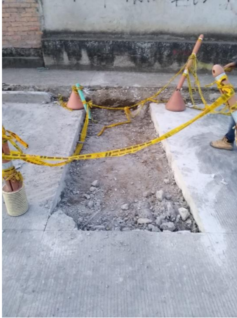
Fotografía 97. Losa demolida libre de escombros.
