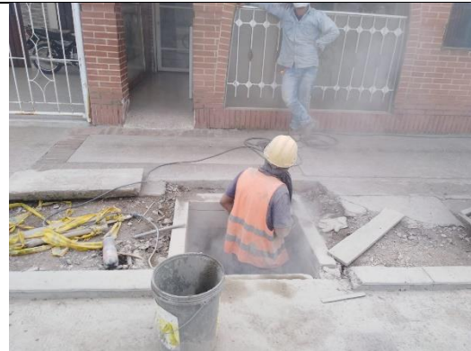
Fotografía 57. Modificación de sumideros a nivel de andén.
