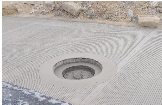
Fotografía 6. Texturizado de pozo.
