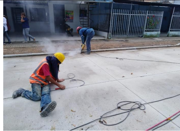
Fotografía 45. Sellado de juntas, limpieza de juntas con soplete, inserción de cordón.
