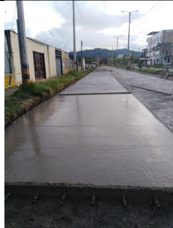
Fotografía 33. Concreto recién fundido cumpliendo proceso de fraguado.
