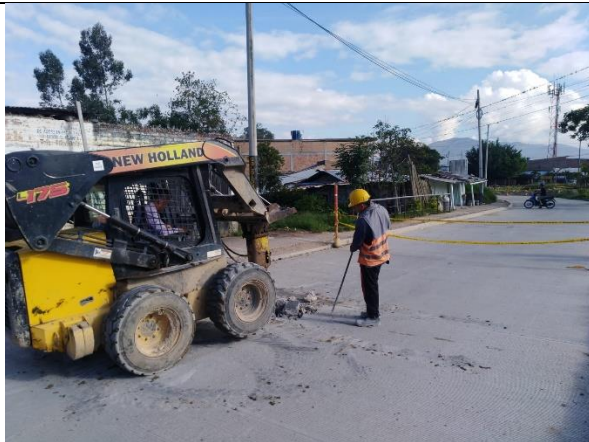
Fotografía 99. Proceso de demolición de losas.
