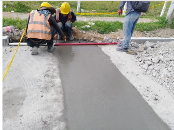
Fotografía 100. Fundición de losa demolida.
