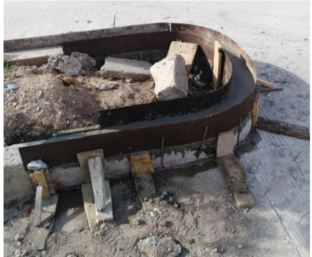
Fotografía 64. Curva de bordillo ya fundida.
