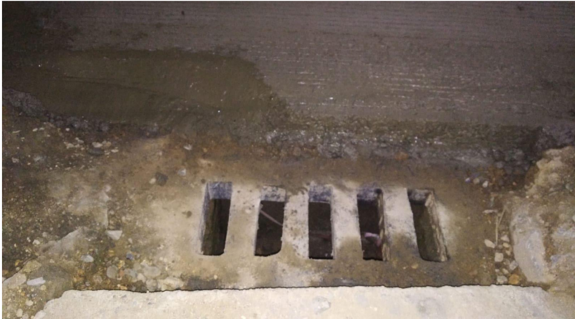
Fotografía 92. Solución a captación de fondo de sumidero adyacente a boca-calle.
