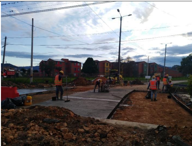
Fotografía 118. corte de juntas de primer carril fundido del empalme final.
