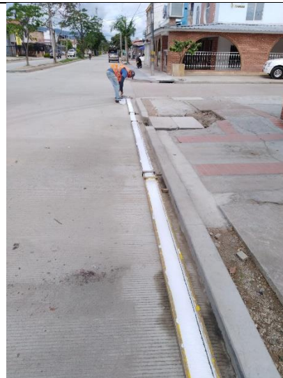
Fotografía 111. Pintura blanca de laterales.
