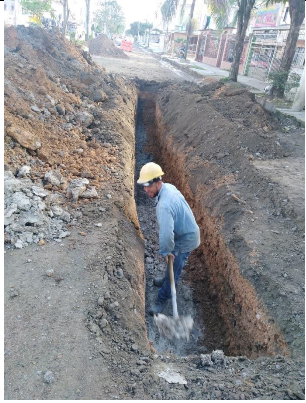
Fotografía 60. Terminando de perfilar área de fallo por humedad.
