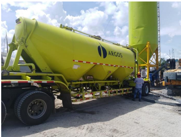
Fotografía 22. Llenado del silo de cemento.
