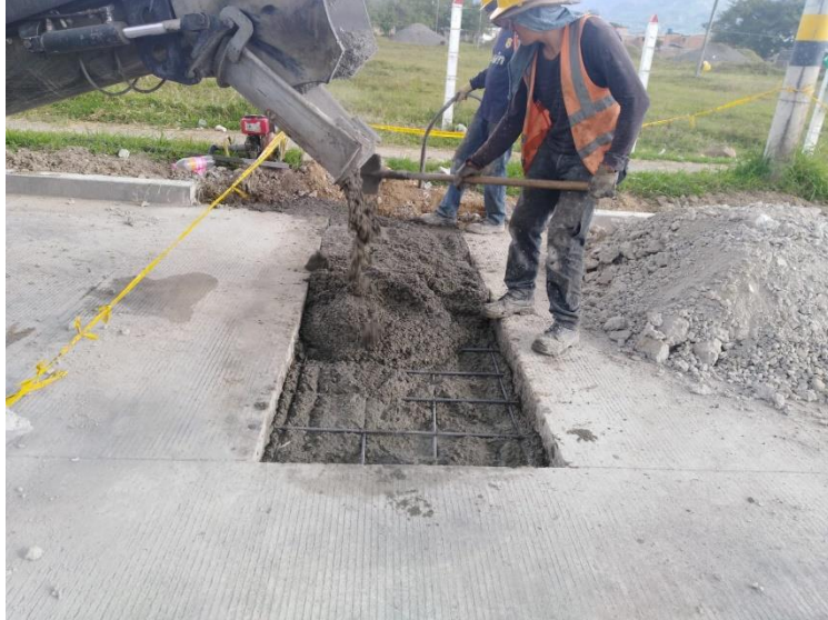
Fotografía 101. Emparrillado para refuerzo de losas demolidas.
