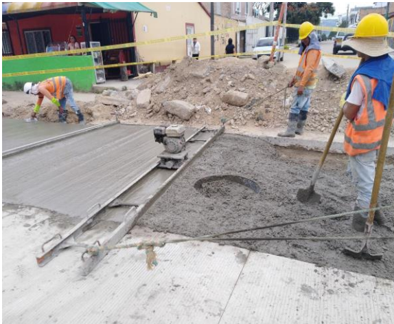
Fotografía 5. Instalación de aro para pozo de aguas negras.
