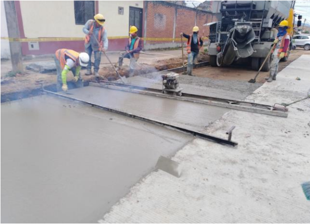
Fotografía 2. Pavimentación tramo 2 calzada izquierda carril izquierdo en k0+390.
