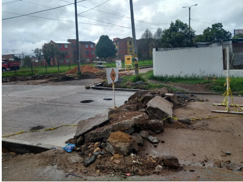
Fotografía 120. Empalme final fundido con boca-calle.
