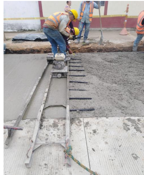
Fotografía 3. Regla vibratoria e instalación de dovelas para transmitir cargas entre losas.
