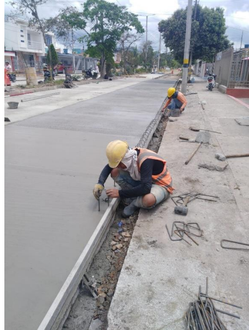
Fotografía 39. Instalación de u para bordillo.
