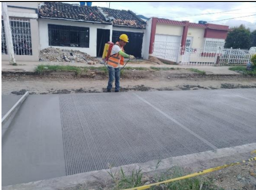
Fotografía 36. Aplicación de anti sol, para que el agua no afecte tanto la superficie al caer y acelere el secado.
