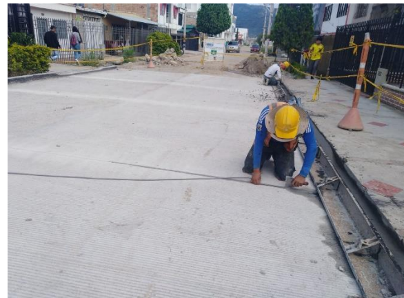
Fotografía 91. Sellado de juntas boca-calle calle 4 calzada izquierda.
