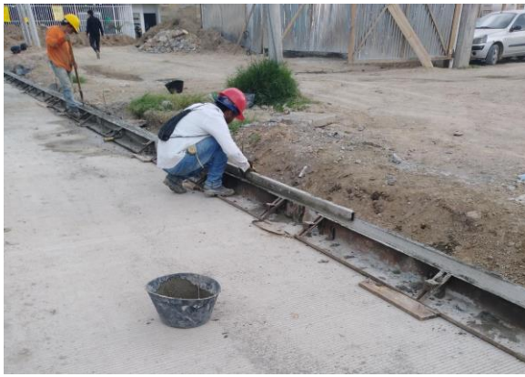
Fotografía 11. Fundición de bordillo en k0+110.
