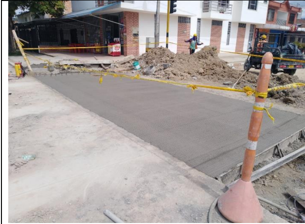
Fotografía 88. Calle 1 boca-calle fundida.
