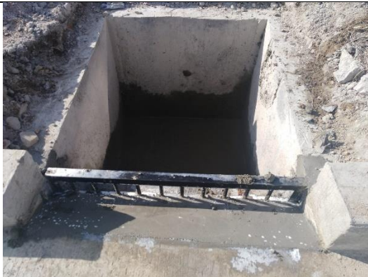
Fotografía 56. nueva pendiente de entrada a Sumideros.
