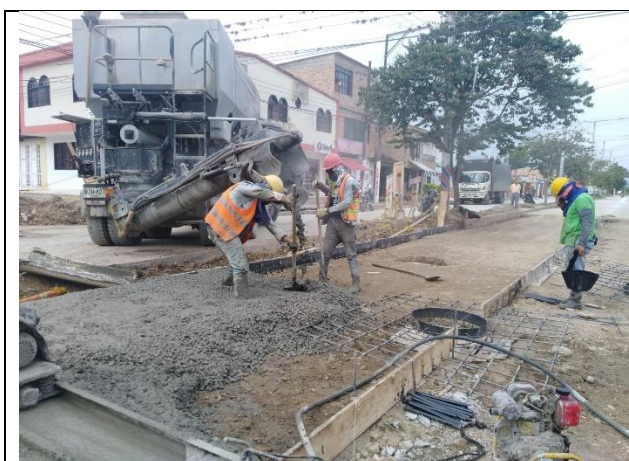
Fotografía 65. Fundición de placas con parrilla para pozo.
