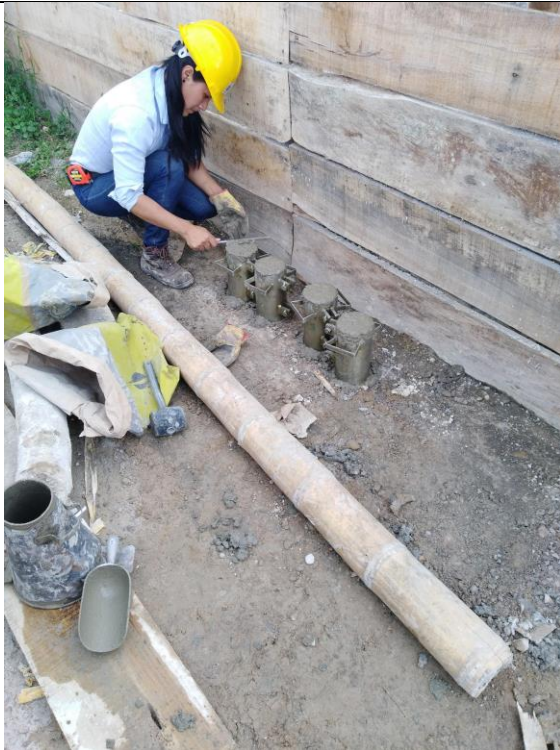
Fotografía 13. Toma de muestras para bordillo en k0+091 -k0+158.5 calzada izquierda lado izquierdo.
