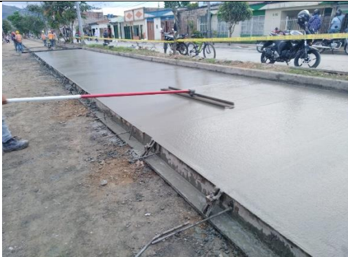
Fotografía 34. Se le da acabado a la superficie con la flotadora.
