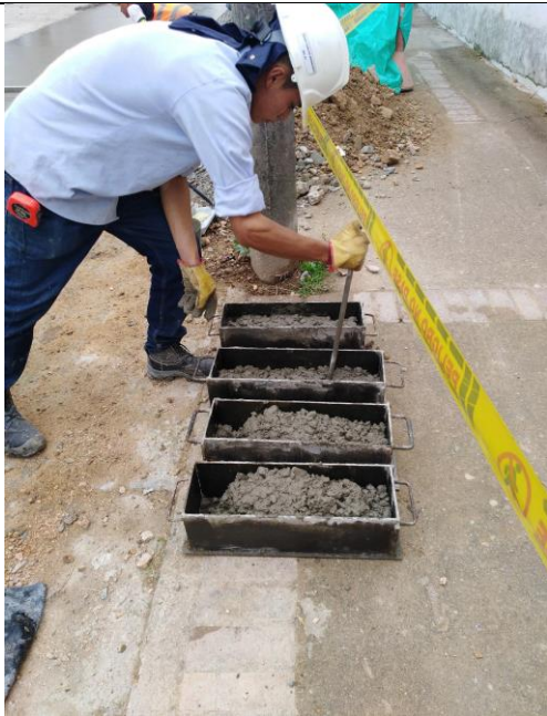
Fotografía 8. Toma de viguetas como muestra del concreto fundido en tramo 2 calzada izquierda carril izquierdo k0+416.
