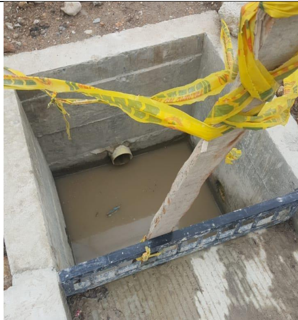
Fotografía 68. Sumidero limpio después de compromiso adquirido en auditoria.
