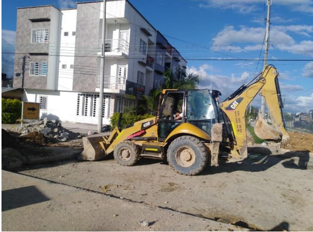
Fotografía 73. Limpieza de escombros que obstruían la vía.
