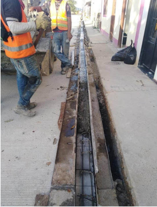
Fotografía 61. Fundición de bordillo, acero de refuerzo longitudinal y transversal instalado.
