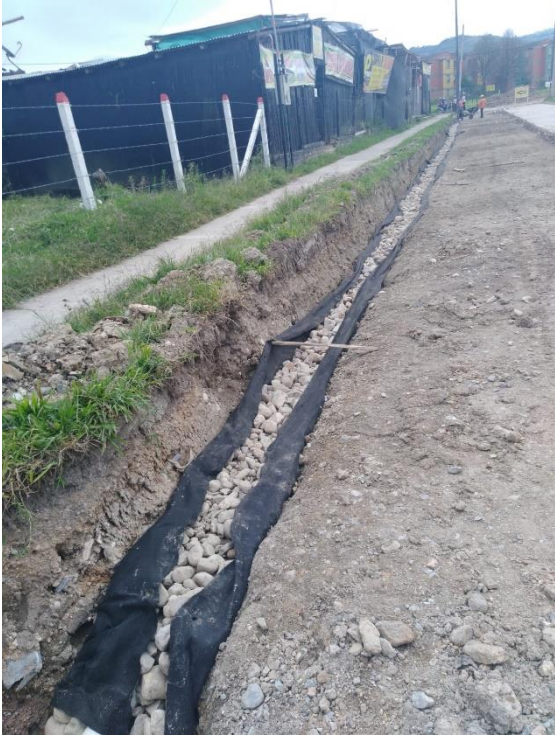
Fotografía 42. Instalación de piedra filtro con geotextil.
