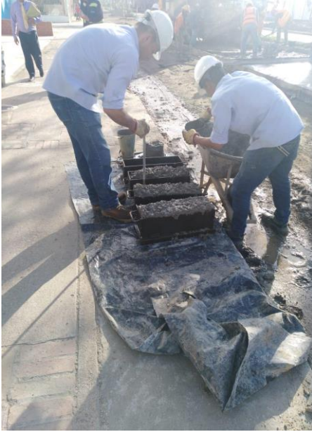
Fotografía 38. Viguetas de concreto para chequear el cumplimiento de las especificaciones.
