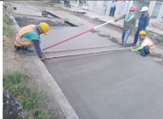
Fotografía 35. Texturizado de concreto.
