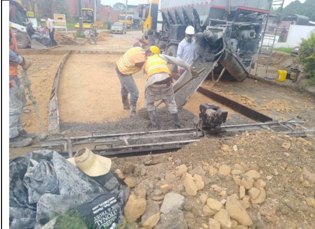
Fotografía 116. fundición de un carril empalme final.
