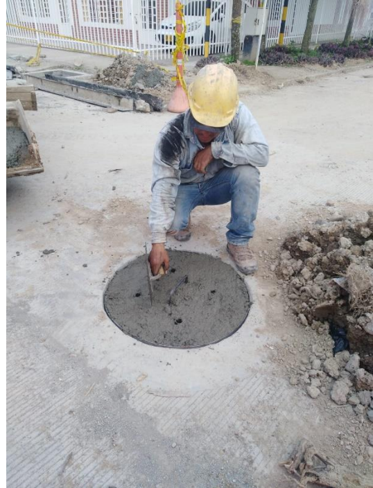
Fotografía 94. Fundiendo tapa en sitio.
