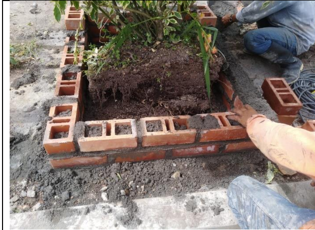
Fotografía 105. Reconstrucción de materas.
