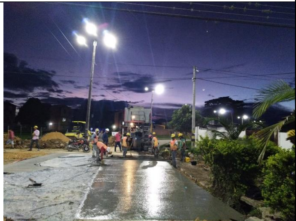
Fotografía 119. tercer carril fundido del empalme final.
