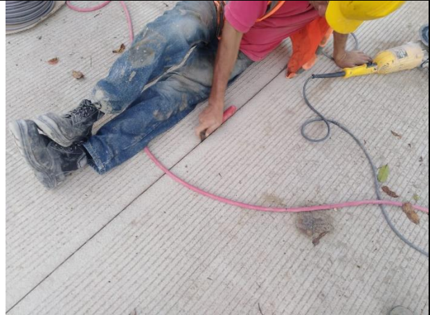
Fotografía 46. Sellado de juntas, profundización de cordón.
