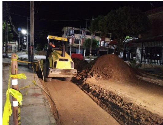
Fotografía 17. Compactación de sub-base en capas.
