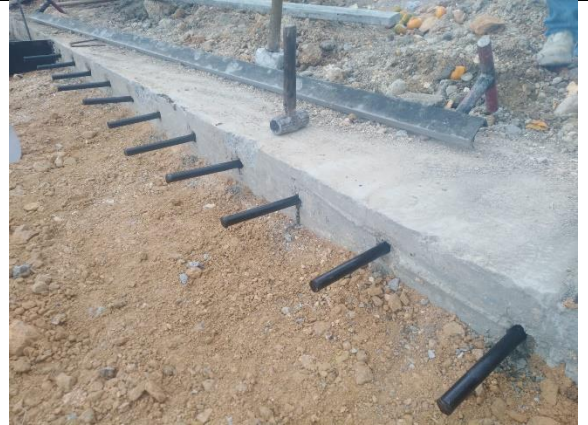
Fotografía 117. Dovelas concreto nuevo.
