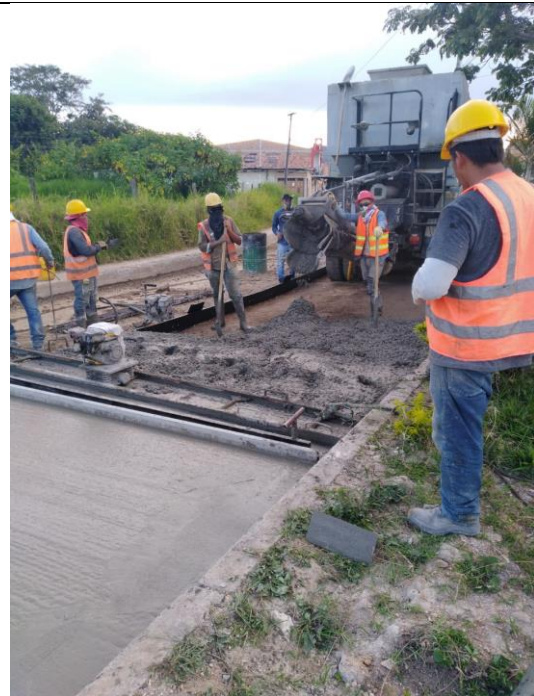
Fotografía 27. Fundición con camión planta.
