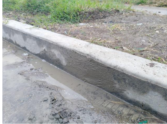
Fotografía 103. Bordillo resanado y sin rebaba.
