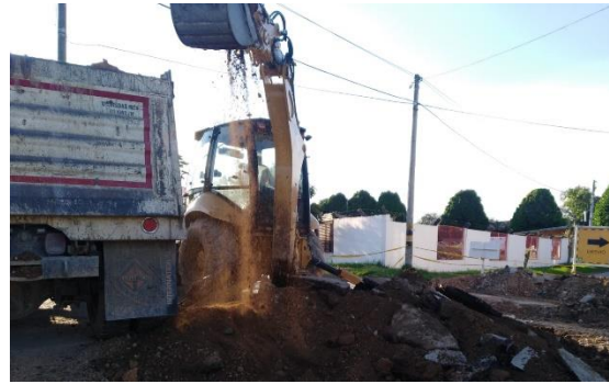
Fotografía 74. Recogida de escombros en exceso en la vía.
