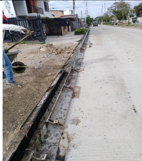
Fotografía 12. Formaleta engrasada en proceso de fundición.
