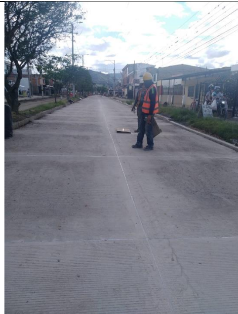
Fotografía 48. Sellado de juntas realizado al final de una jornada de trabajo.
