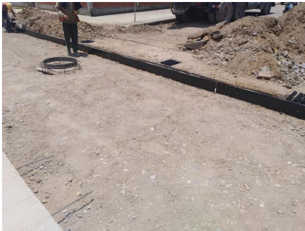
Fotografía 26. Terreno formateado y con aro de pozo instalado.
