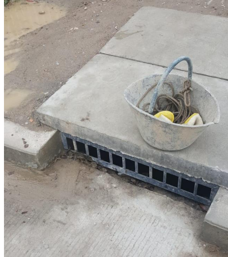
Fotografía 53. Sumideros iniciales con tapas y rejilla instalada.
