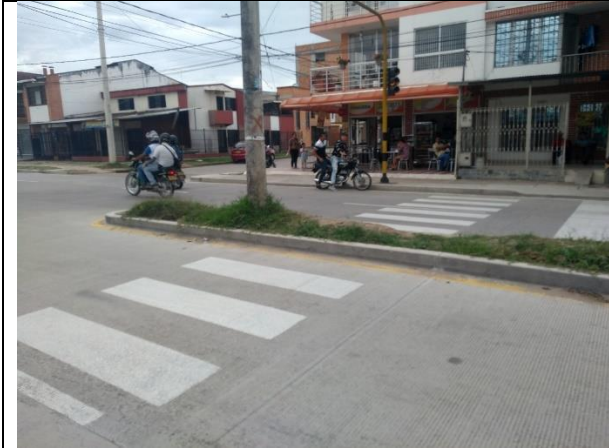
Fotografía 112. Cebras para paso peatonal.
