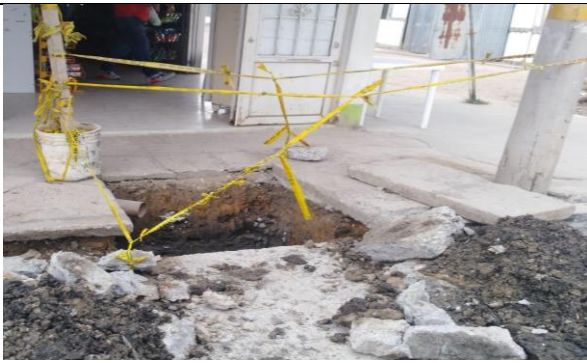
Fotografía 50. Demolición de sumidero.
