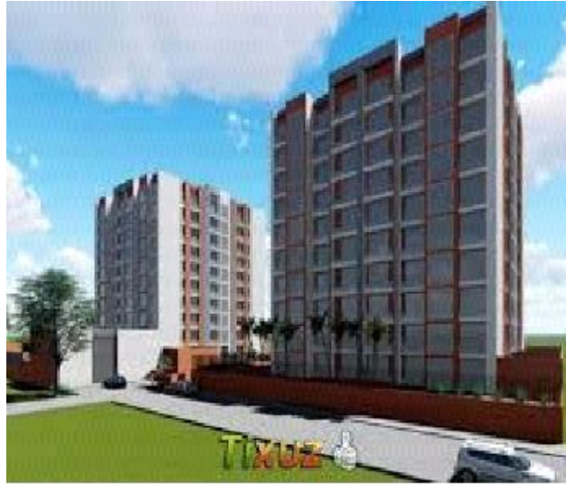
Figura 2. Torre A y B Condominio Marsella. fachada
