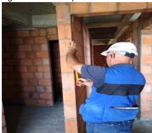
Figura 87. Revisión para altura dintel.
