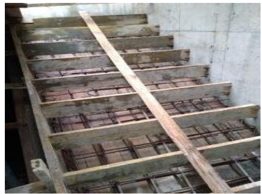
Figura 67. Formaleta de escalones
