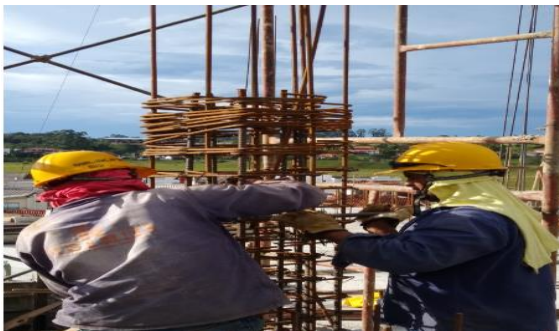
Figura 11. Armado de acero de columnas
