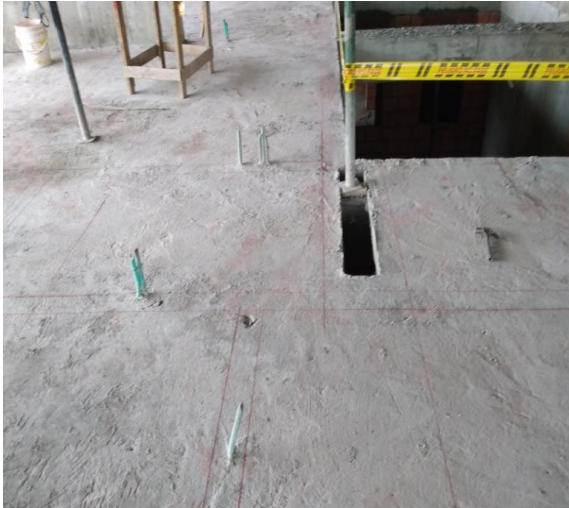
Figura 71. Replanteo para muros
