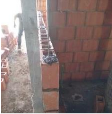
Figura 76. Fundición de dovelas
