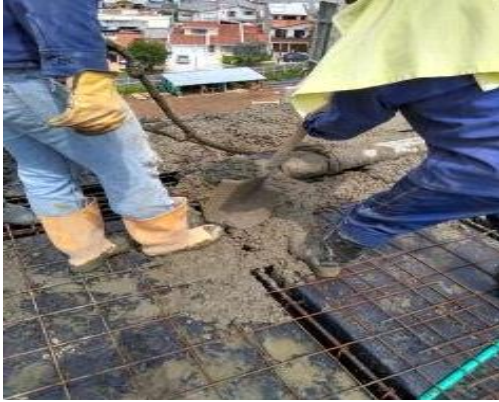
Figura 55. Colocación del concreto
