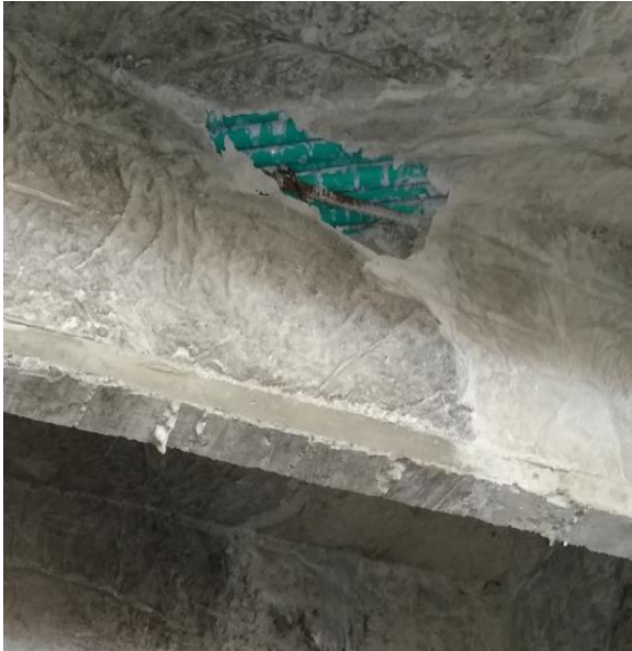
Figura 61. Inconsistencias en fundición
