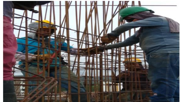
Figura 12. Armado de acero de pantallas
