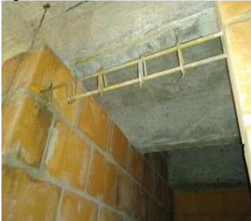
Figura 79. Refuerzo de acero de dintel
