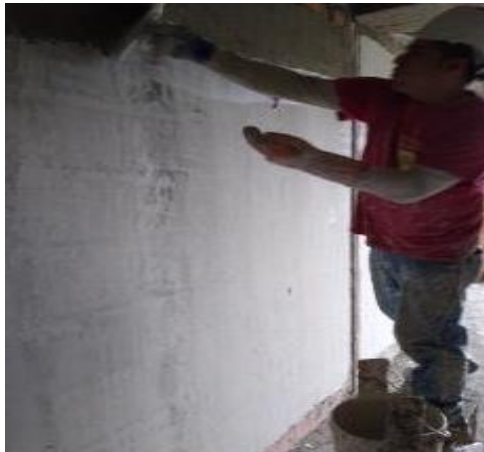
Figura 91. Estucada de muros.
