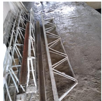
Figura 38. Cercha metálicas
