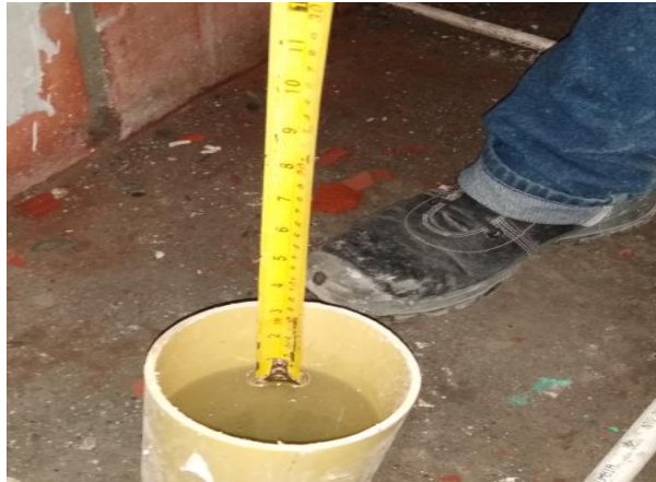
Figura 102. Medición para prueba de estanqueidad.
