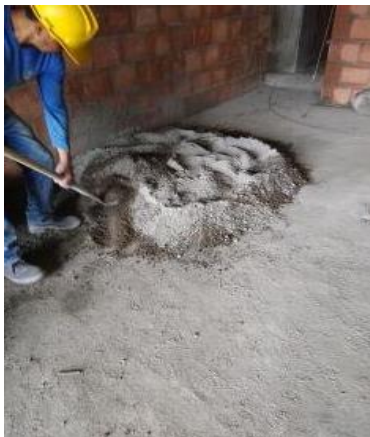
Figura 73. Preparación de mezcla
