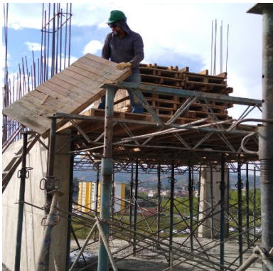
Figura 39. Montaje de tableros.
