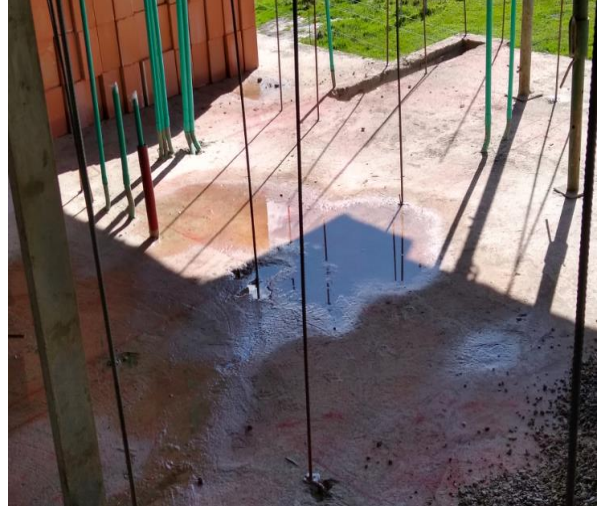
Figura 72. Anclaje de dovelas.
