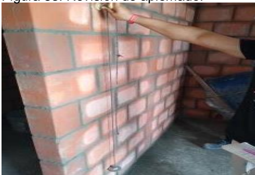
Figura 83. Revisión de aplomado.
