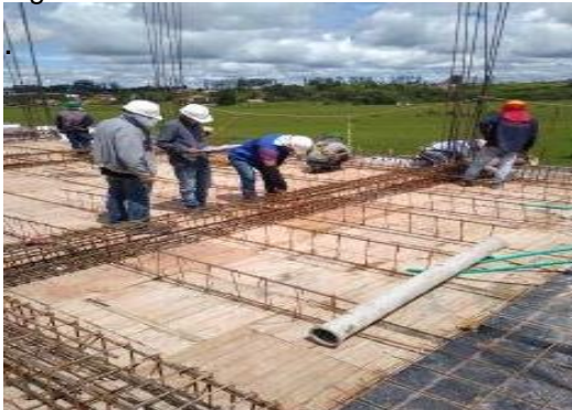
Figura 49. Revisión de armado de acero
