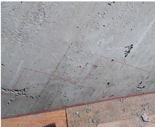
Figura 64. Replanteo con cimbrado. Escaleras
