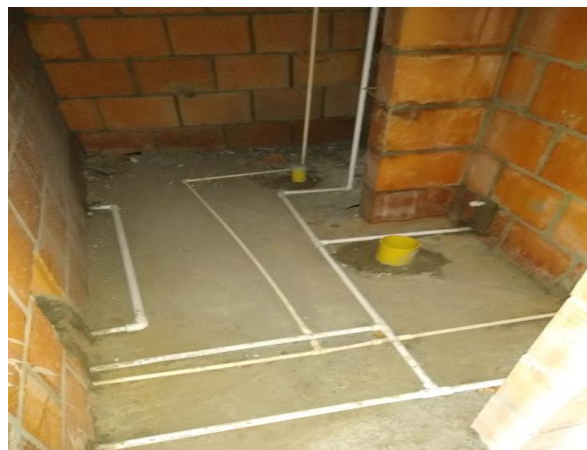
Figura 98. Puntos hidráulicos y sanitarios
