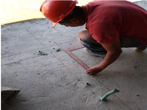
Figura 82. Revisión de replanteo.
