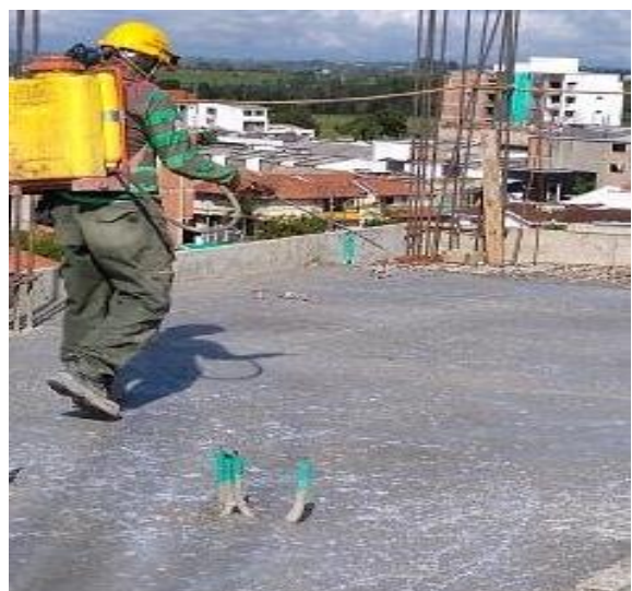
Figura 58. Aplicación de antisol
