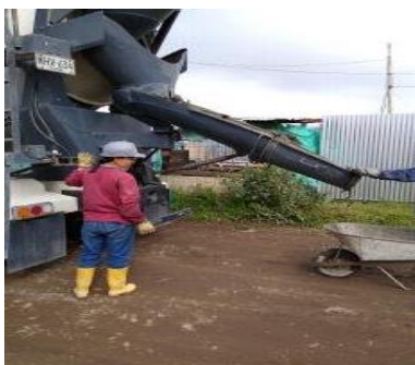
Figura 29. Muestra de concreto
