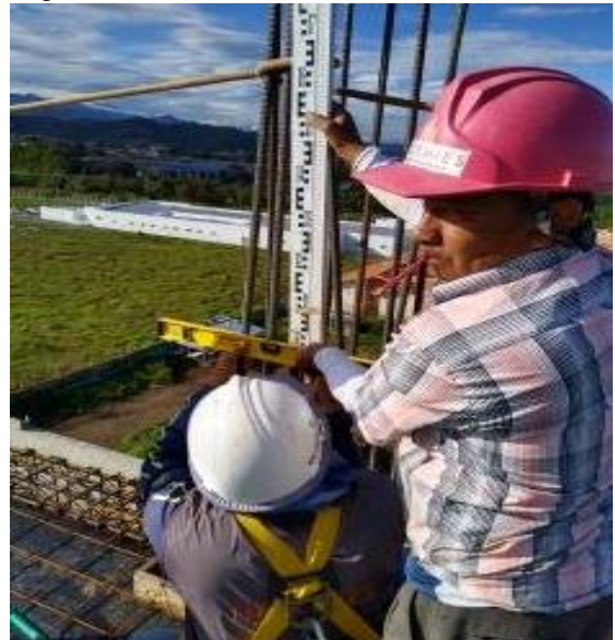
Figura 54. Nivelación mira estadimetrica
