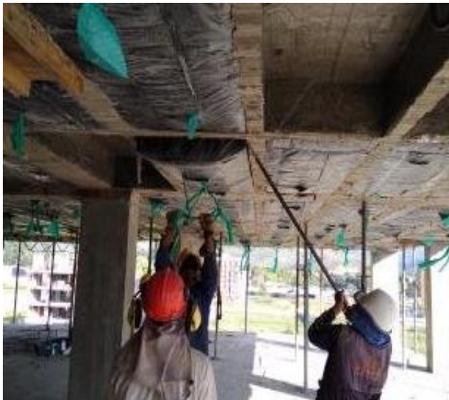
Figura 59. Desencofrado de losa
