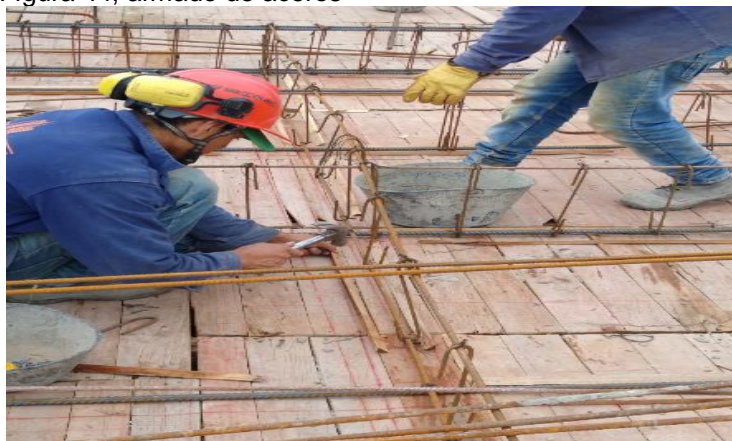
Figura 44, armado de aceros
