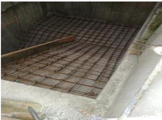
Figura 66. Armado de aceros de escalera
