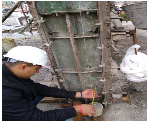
Figura 28. Prueba de verticalidad.
