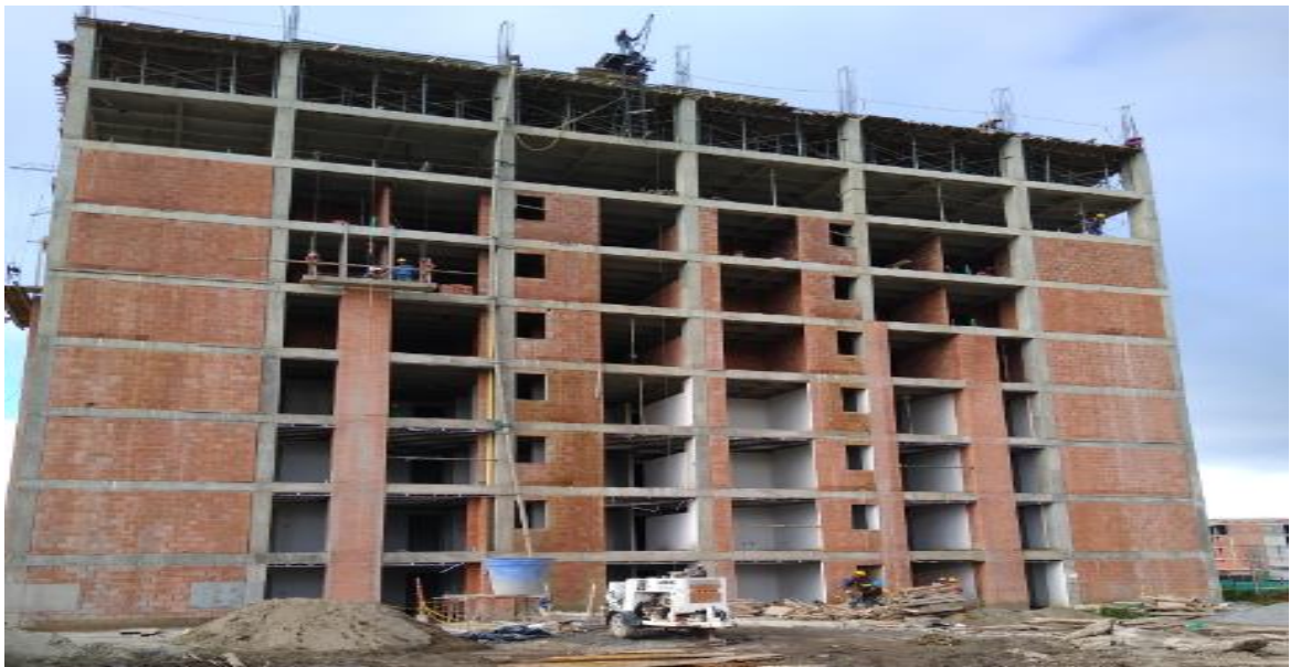
Figura 4. Obra Marsella. Sistema estructural. Columnas y losas.
