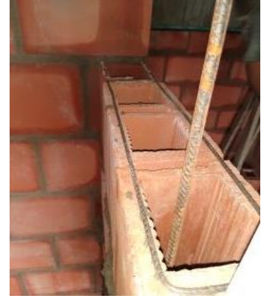
Figura 75. Colocación de grafiles,
