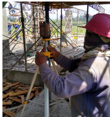
Figura 40. Nivelación con láser
