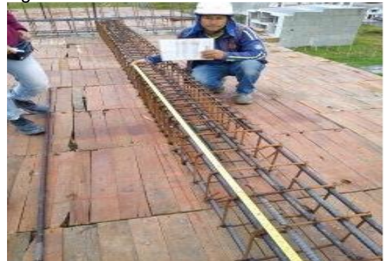
Figura 50. Revisión de armado de acero
