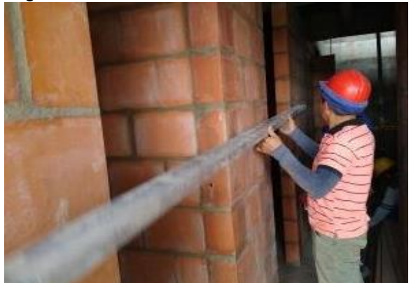
Figura 86. Prueba codal alineamiento con vanos
