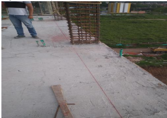
Figura 19. Replanteo de columnas
