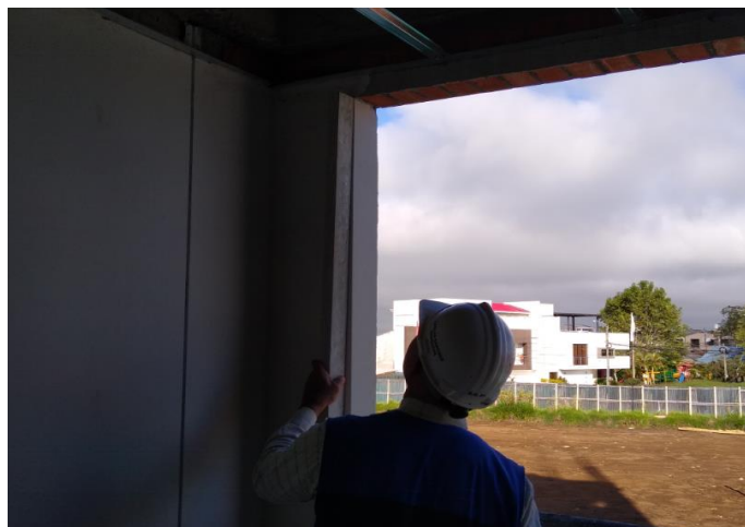
Figura 97. Medición de Vanos de puertas y ventanas
