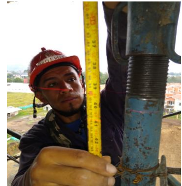
Figura 41. Nivelación, cinta
