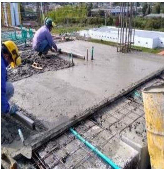
Figura 57 Pulimento de losa
