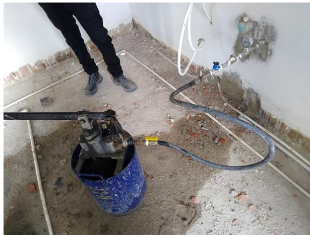
Figura 99. Bomba manual con manómetro
