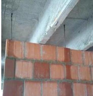
Figura 77, Anclaje de varillas.
