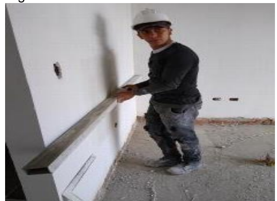
Figura 94. Prueba codal horizontal
