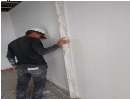
Figura 93. Prueba codal vertical
