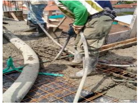
Figura 56. Vibrado del concreto
