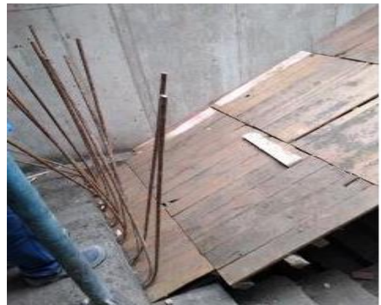
Figura 65. Encofrado de madera. Escaleras
