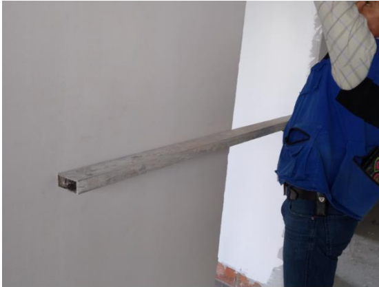
Figura 95. Alineamiento de paredes y vanos
