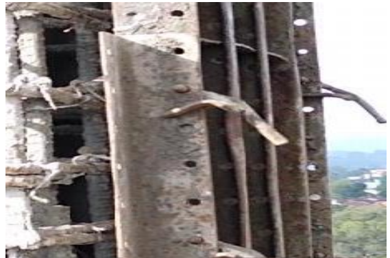
Figura 22. Colocación de pines
