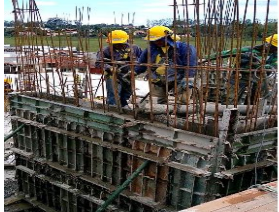
Figura 35. Vaciado de concreto a pantallas
