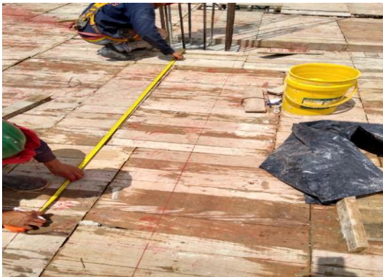
Figura 42. Replanteo en encofrado.
