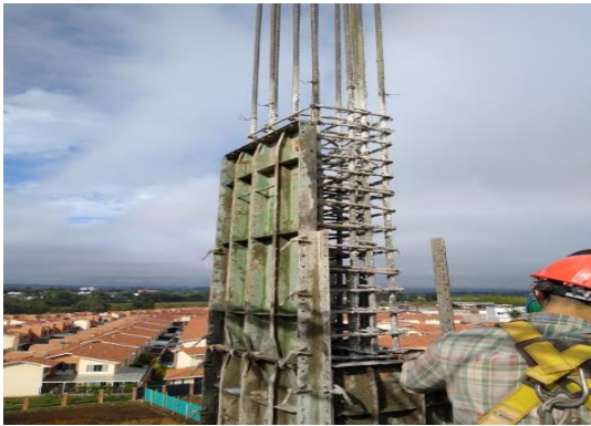
Figura17. Colocación de formaleta columna
