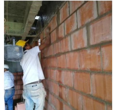
Figura 78. Relleno de rebite
