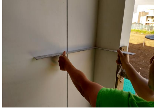
Figura 96. Escuadra en los vértices de los muros
