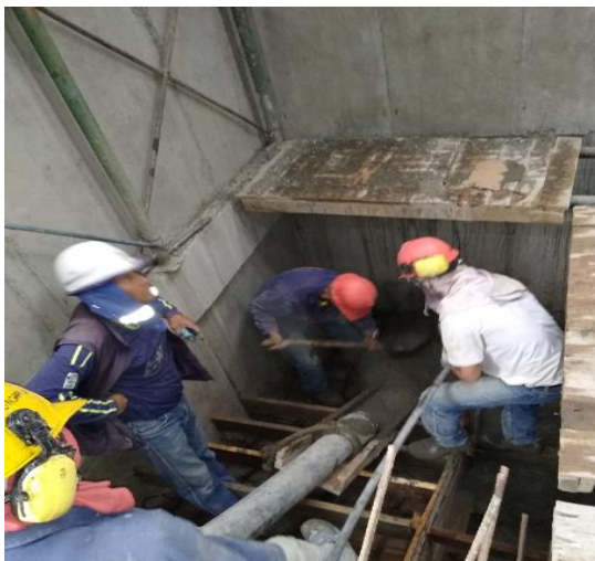
Figura 69. Vaciado de concreto en escaleras
