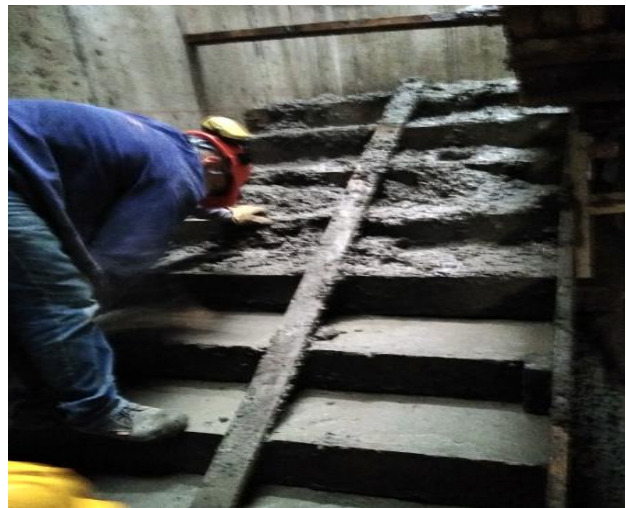
Figura 70. Pulimiento del concreto de escaleras
