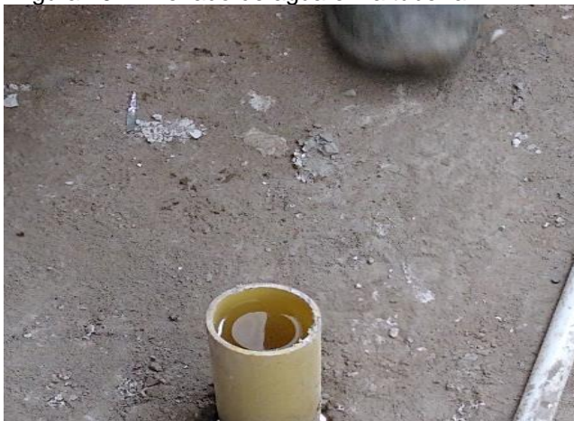
Figura 101. Llenado de agua en la tubería
