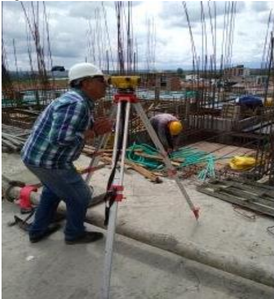
Figura 53. Nivelación con mira de precisión
