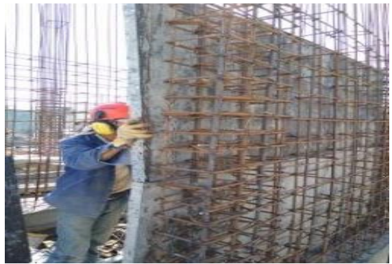
Figura18. Colocación de formaleta pantalla
