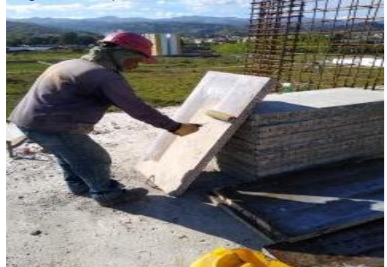
Figura 20. Aplicación desmoldante
