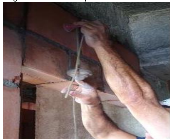
Figura 88. Revisión aplomado dintel.
