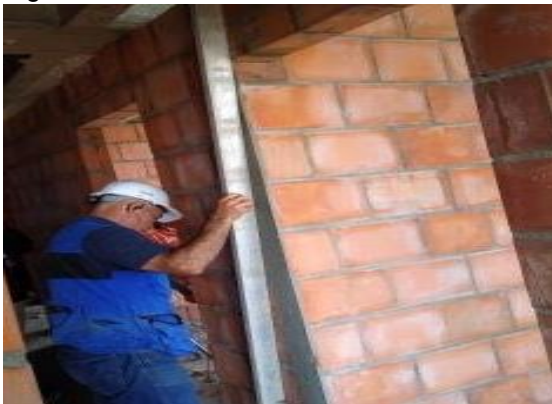
Figura 85. Prueba de codal.
