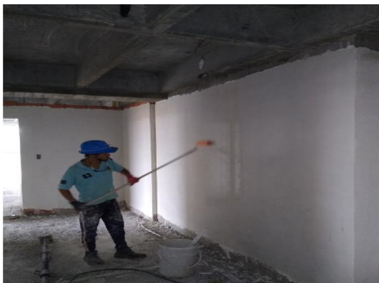
Figura 92. Aplicación de pintura en muros
