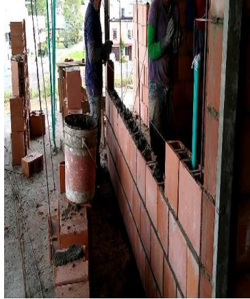
Figura 74. Levantamiento de muro
