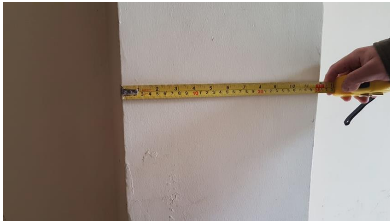
Imagen 126 Columneta 0.30\text{ m} \times 0.30\text{ m} vivienda. Fuente: H y C ingeniería Colombia S.A.S
