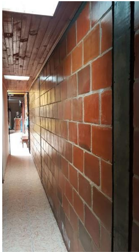
Imagen 129 Muro en mampostería confinada ladrillo a la vista. Fuente: H y C ingeniería Colombia S.A.S
