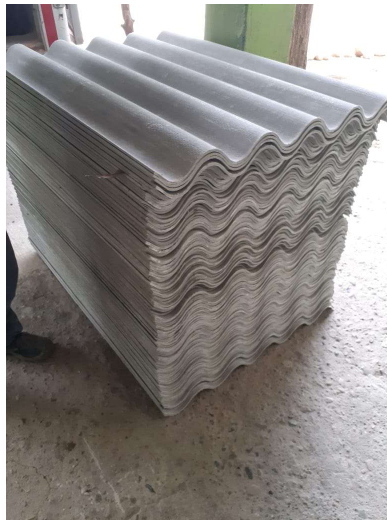
Ilustración 50 Tejas de Eternit No.4 llegando a la correccional. Elaboración propia.
