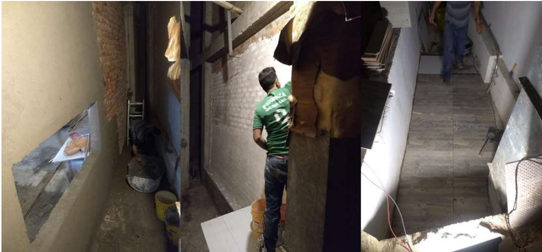
Ilustración 38 Pañetada, estucado de relleno, alistado de piso e instalación de cerámica en el master de luces y sonido. Elaboración propia.
