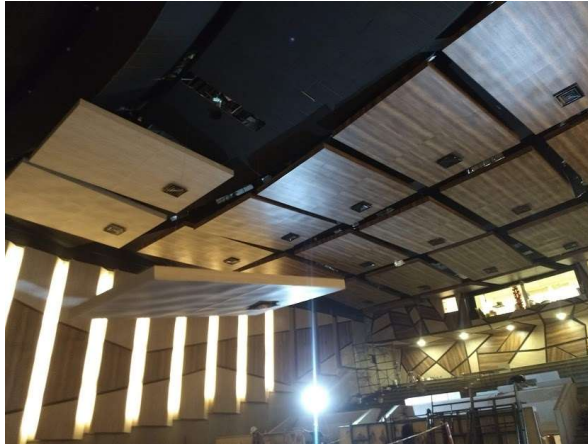
Ilustración 19 Montaje de panel flotante. Elaboración propia.
