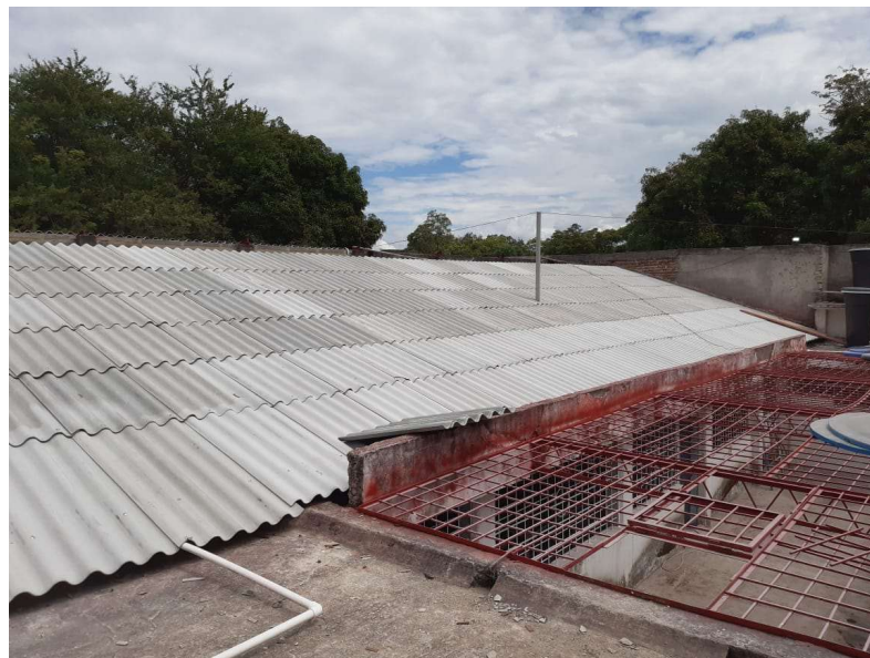
Ilustración 29 Instalación de los 350m de tejas. Elaboración propia.
