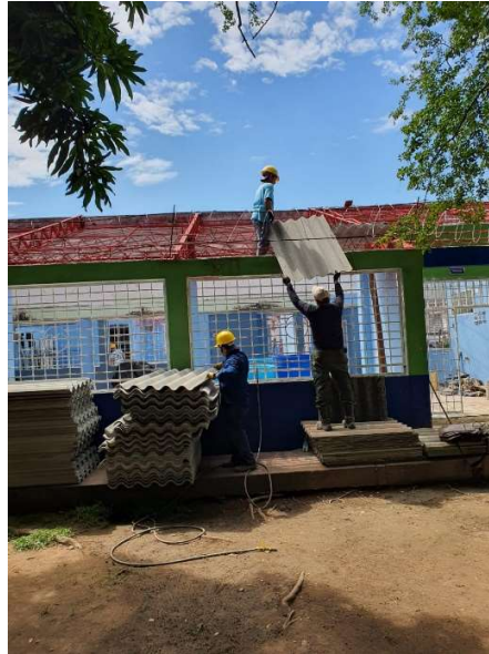
Ilustración 28 Monte de tejas nuevas. Elaboración propia.
