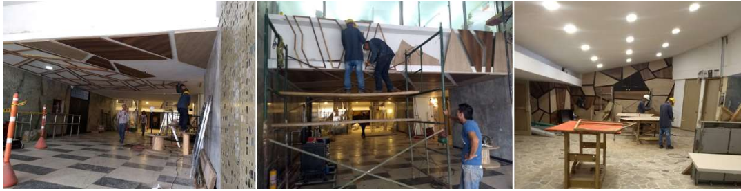
Ilustración 21 Enchape de muro con melamina en entrada y hall. Elaboración propia.
