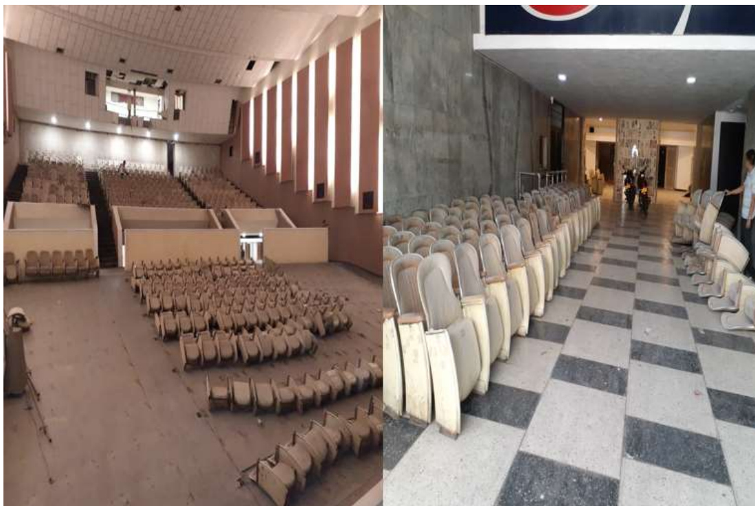
Ilustración 35 Desmonte de gradería. Elaboración propia.
