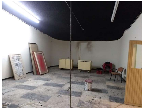
Ilustración 43 Se pinta la parte inferior de la losa de entre piso. Elaboración propia.
