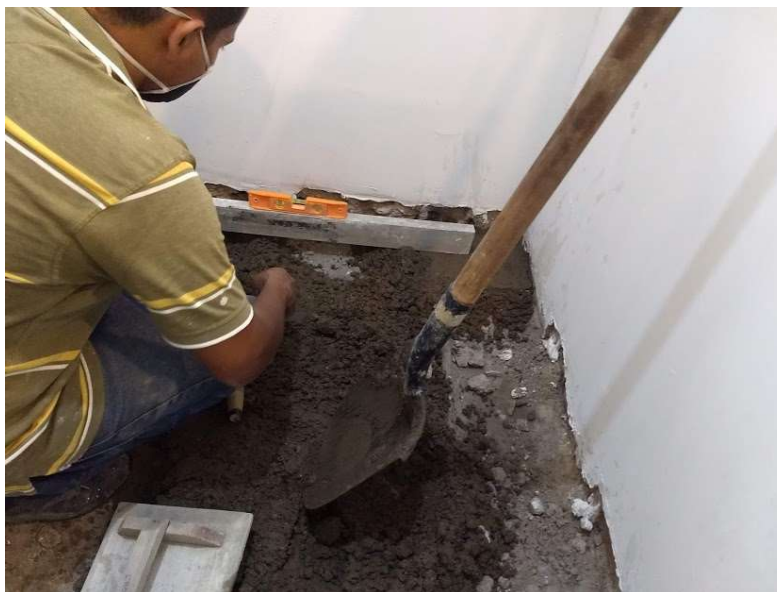
Ilustración 8 Dando nivel en el alistado de piso dentro de la cafetería. Elaboración propia.
