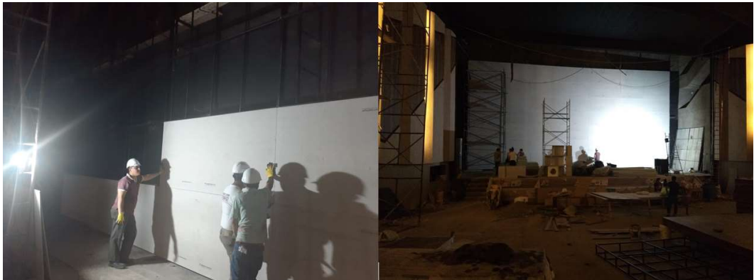
Ilustración 20 Instalación del superboard sobre la estructura metálica y aplicación de estuco sobre superboard. Elaboración propia.
