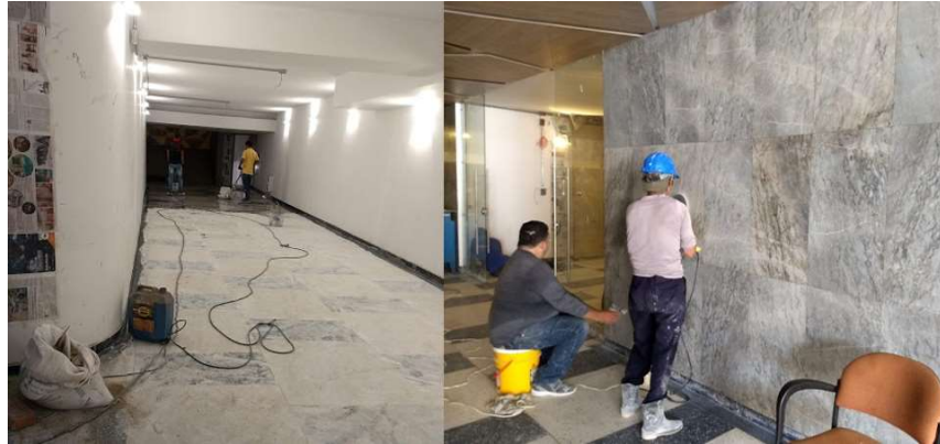
Ilustración 23 Pulido y brillo de piso y paredes. Elaboración propia.
