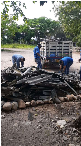
Ilustración 27 Remoción de escombros y tejas. Elaboración propia.
