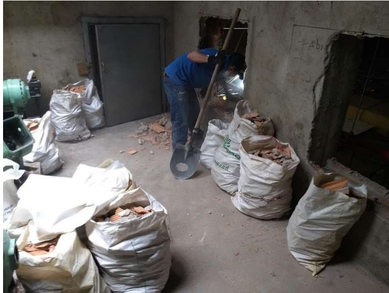
Ilustración 39 Retiro de escombros en el cuarto de aires acondicionados. Elaboración propia.
