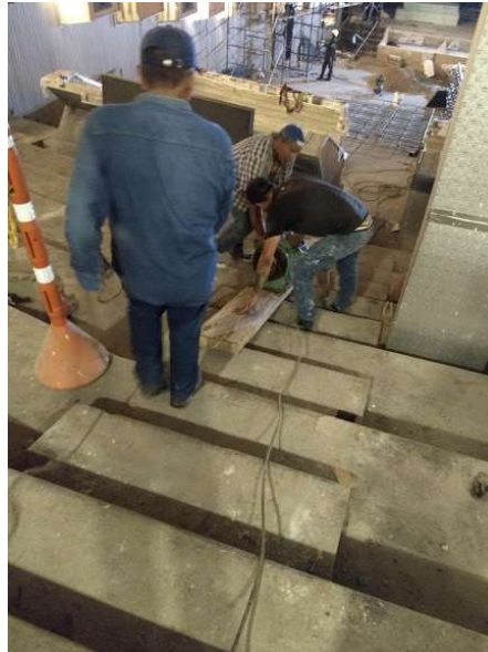
Ilustración 40 Se bajan los motores del cuarto de aires acondicionado. Elaboración propia.
