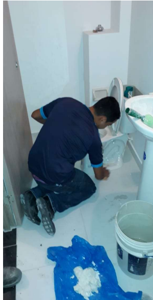
Ilustración 13 Instalación de sanitario en lavamanos. Elaboración Maestro Carlos Alfredo Moreno.
