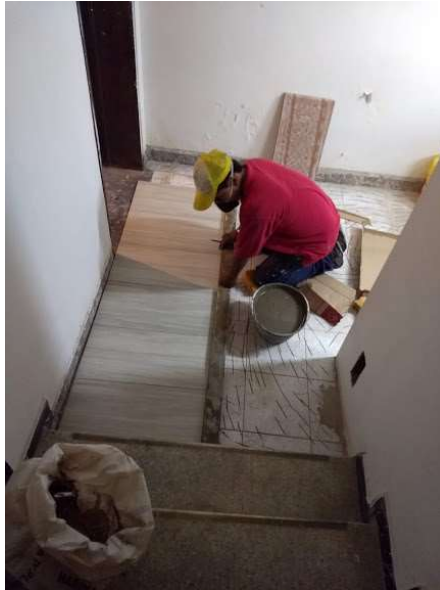
Ilustración 9 Instalación de cerámica sobre cerámica existente en el baño de los hombres. Elaboración propia.
