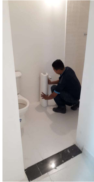
Ilustración 12 Instalación de lavamanos en baño del sótano. Elaboración Maestro Carlos Alfredo Moreno.
