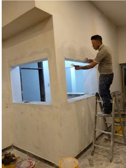
Ilustración 2 Estucado Liso en parte exterior de la cafetería. Elaboración Maestro Carlos Alfredo Moreno.
