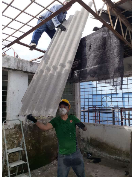
Ilustración 26 Desmonte de tejas deterioradas. Elaboración propia.
