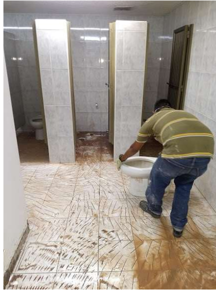
Ilustración 34 Desinstalación de sanitarios. Elaboración propia.
