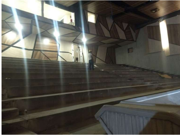
Ilustración 17 Instalación de enchape de muro en zona VIP. Elaboración propia.
