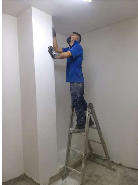
Ilustración 3 Lijada de paredes dentro de la cafetería. Elaboración propia.
