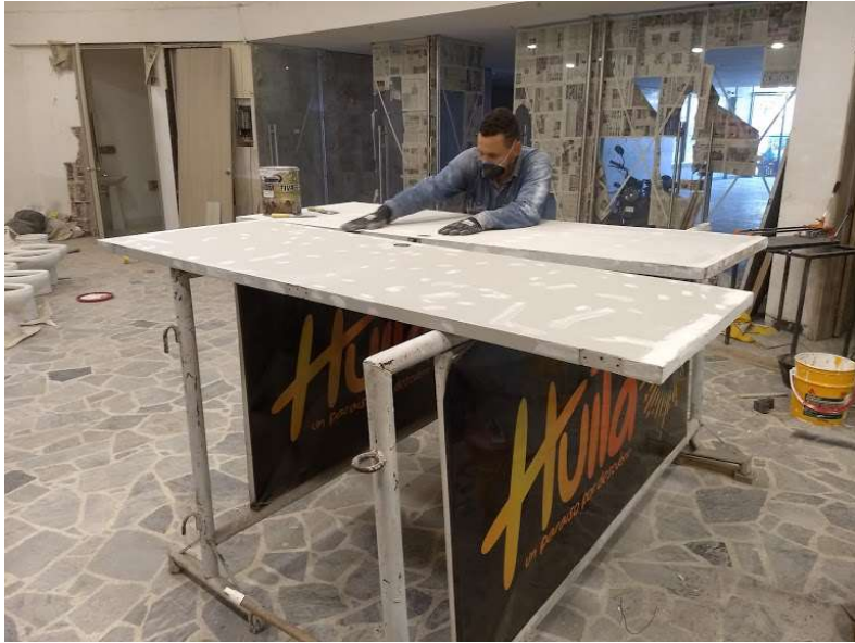
Ilustración 4 Lijada de puerta después de ser masillada. Elaboración propia.
