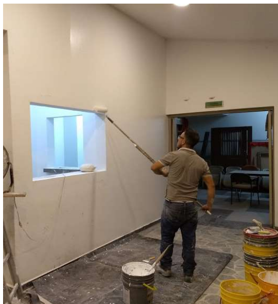
Ilustración 6 Pintada con rodillo de felpa en la parte exterior de la cafetería.
