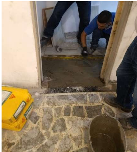
Ilustración 10 Instalación de cerámica sobre alistado de piso en la cafetería. Elaboración propia.
