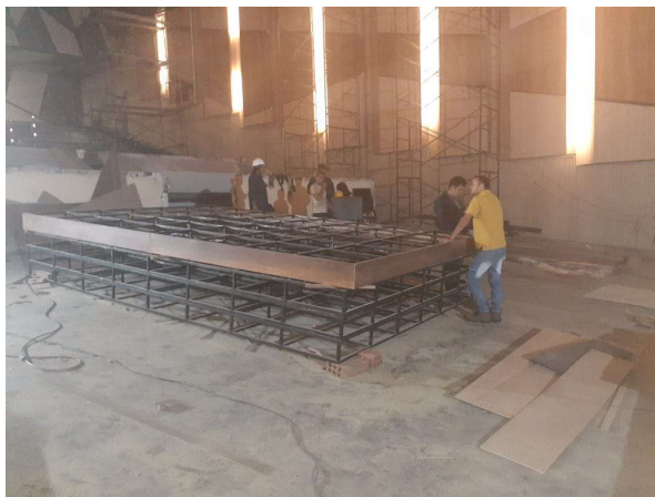
Ilustración 18 Fijación de la melamina a la estructura metálica. Elaboración propia.
