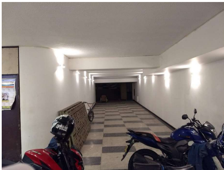
Ilustración 33 Paredes pintadas en la salida de emergencia. Elaboración propia.
