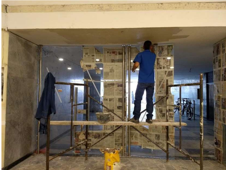
Ilustración 1 Estucado de relleno en placa de entrepiso en la zona de la entrada. Elaboración propia.
