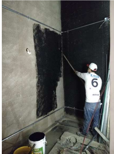
Ilustración 7 Pintada con rodillo de espuma en la parte del escenario. Elaboración propia.
