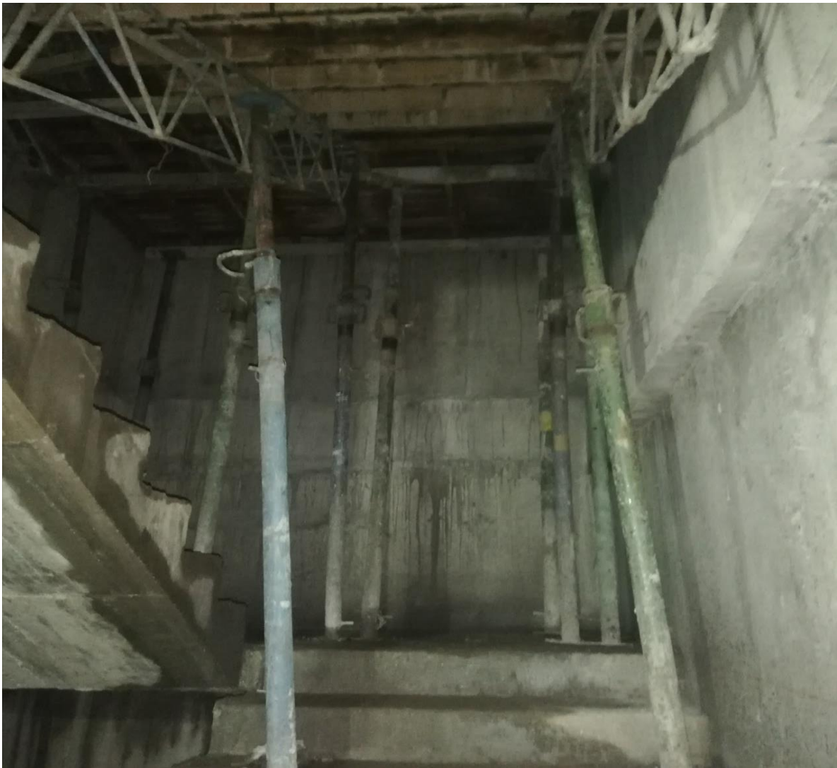
Figura 34 desencofrado por tramos de la escalera Fuente: propia
