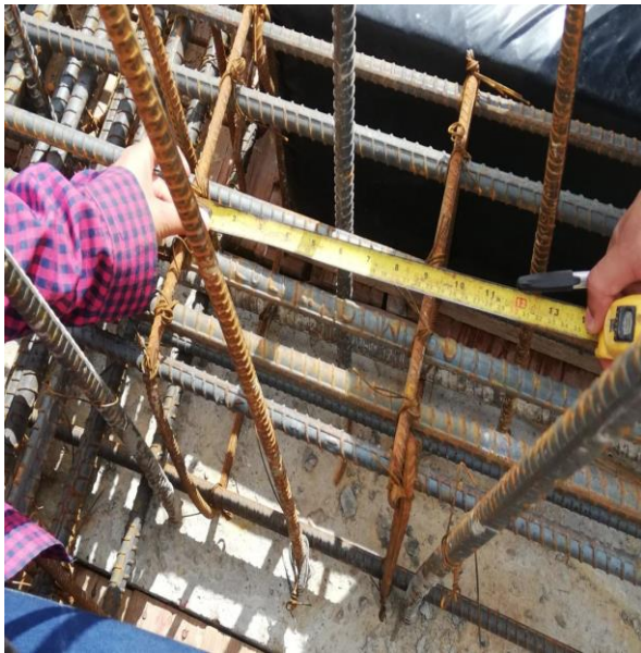
Figuras 7 y 8. Medición de separación entre estribos de vigas y pantallas. Fuente: Propia
