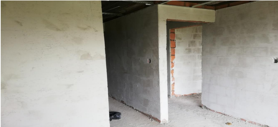
Figura 45. Muros solo con relleno previo antes de añadir estuco Fuente: propia
