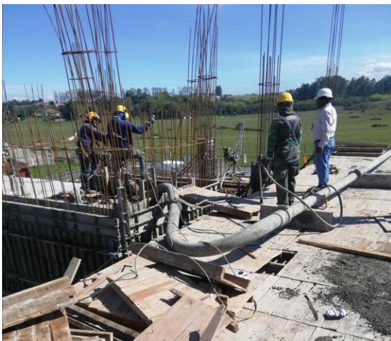
Figuras 27 y 28 vaciado del concreto en elementos verticales. Fuente: Propia
