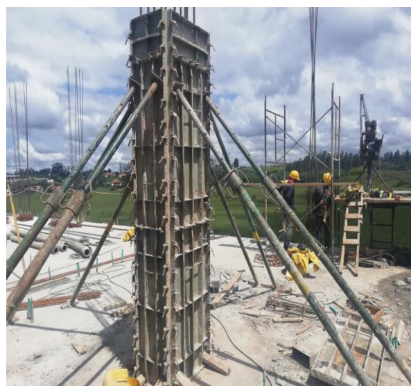
Figuras 15 y 16. Nivelación de formaletas para elementos verticales (columnas y pantallas). Fuente: Propia.
