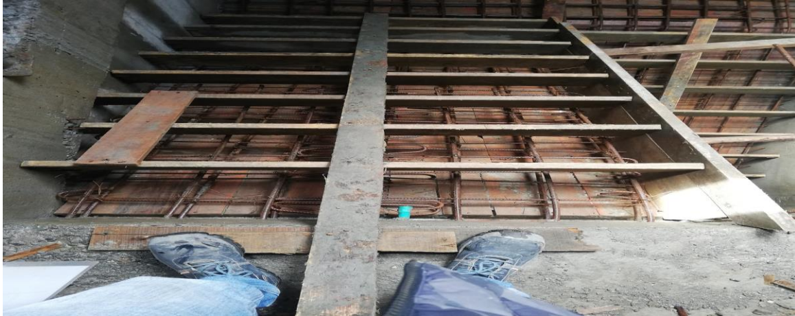
Figura 29 concreto vaciado en escaleras. Fuente: Propia
