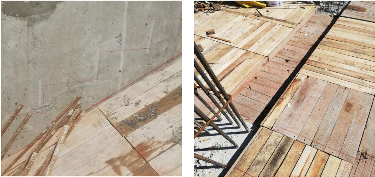
Figuras 4 y 5. Localización y replanteo de elementos estructurales (vigas y viguetas). Fuente: Propia.
