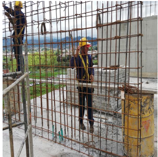
Figuras 7 y 8. Medición de separación entre estribos de vigas y pantallas. Fuente: Propia
