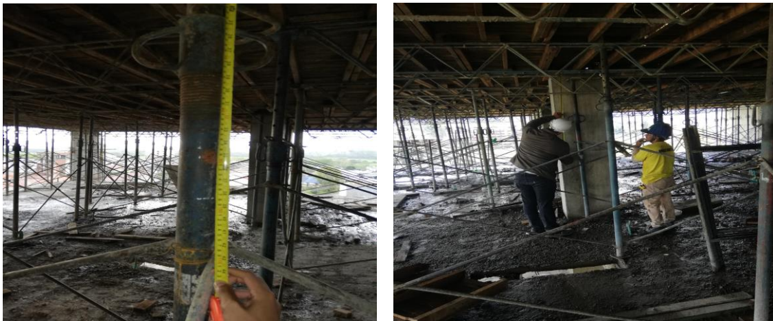
Figuran 12 y 13. Alineamiento de la formaleta para la losa estructural. Fuente: Propia.
