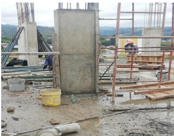
Figura 32 y 33 Desencofrado columna y pantalla p-2 piso 7 Fuente: Propia
