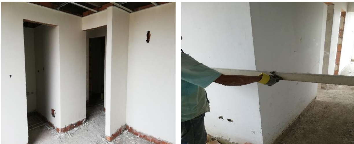
Figuras 46 y 47. Primera mano de pintura en muros internos y rectificación de linealidad con el codal Fuente: propia
