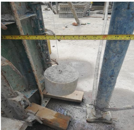
Figuras 15 y 16. Nivelación de formaletas para elementos verticales (columnas y pantallas). Fuente: Propia.
