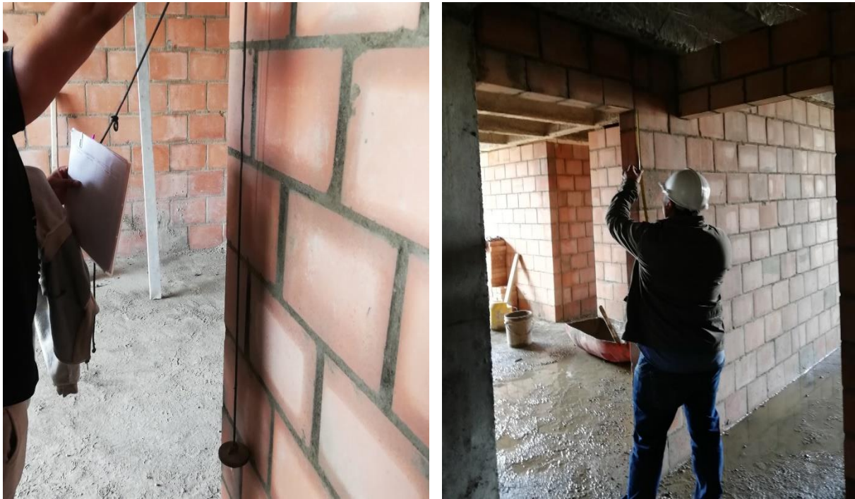
Figuras 41 y 42 revisión de aplome de los muros en mampostería y revisión de altura de los dinteles. Fuentes: Propia.
