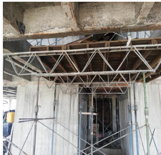
Figuras 10 y 11. Estructuras de soporte para la formaleta de la losa (estacas metálicas y cerchas). Fuente: Propia
