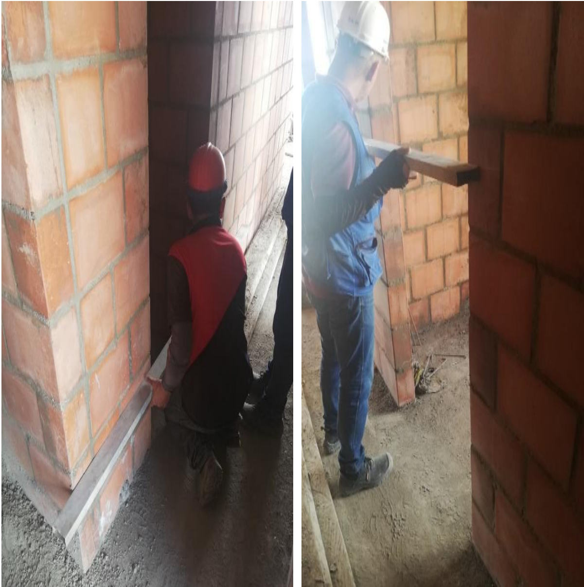
Figuras 39 y 40. Chequeo de la linealidad de cada uno de los muros internos de los apartamentos con codal. Fuente: Propia.
