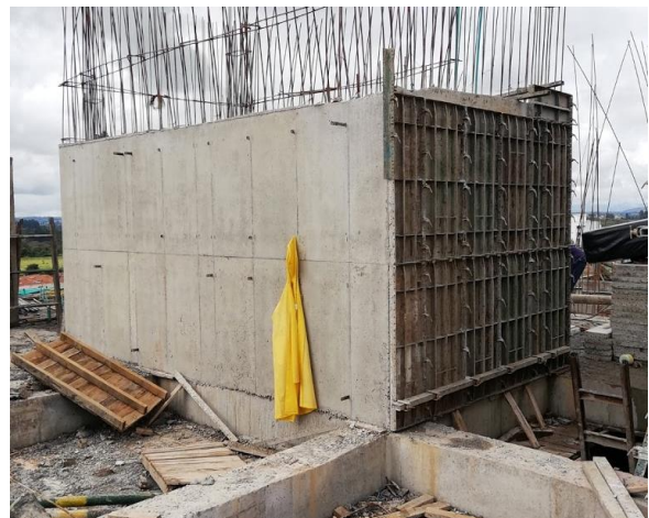
Figura 32 y 33 Desencofrado columna y pantalla p-2 piso 7 Fuente: Propia
