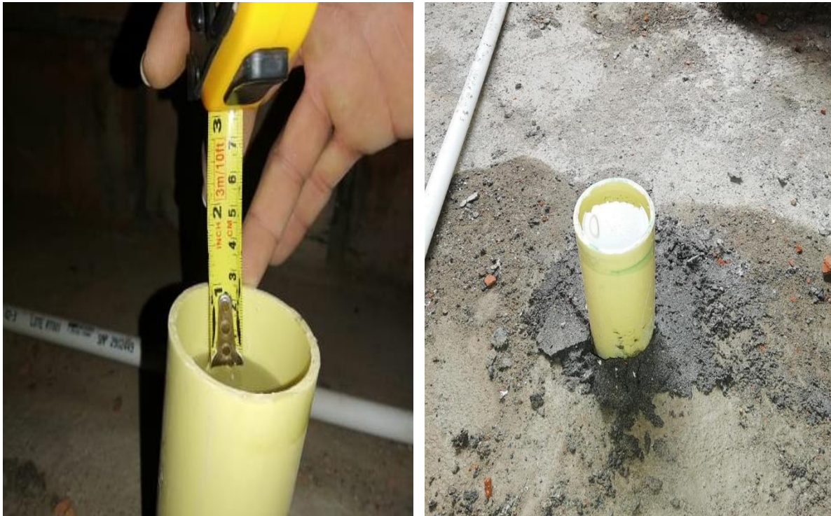
Figura 53 y 54 toma de medidas para la prueba de estanqueidad Fuente: propia
