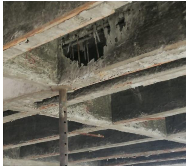
Figuras 30 y 31 Fisuras encontradas en la losa y hormiguelo en riostras de la losa. Fuente: Propia.
