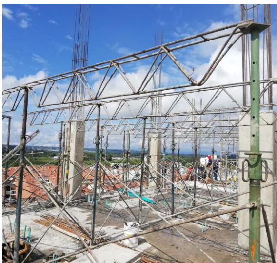
Figuras 10 y 11. Estructuras de soporte para la formaleta de la losa (estacas metálicas y cerchas). Fuente: Propia
