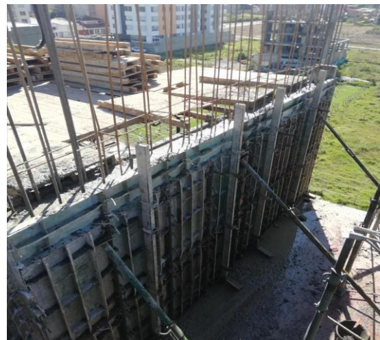
Figuras 27 y 28 vaciado del concreto en elementos verticales. Fuente: Propia
