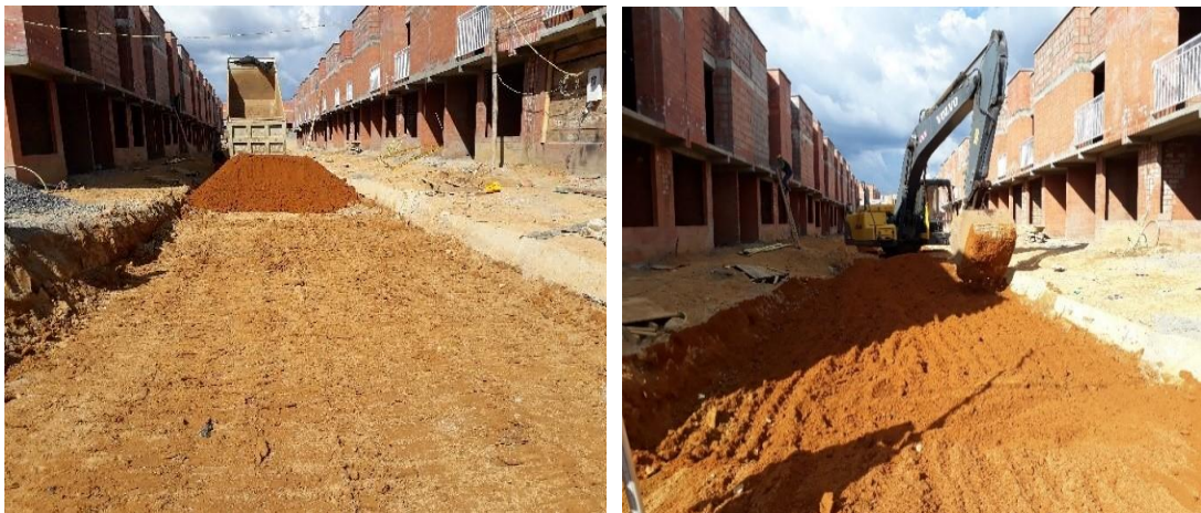
Ilustración 32. Extendido de material Fuente: autor
