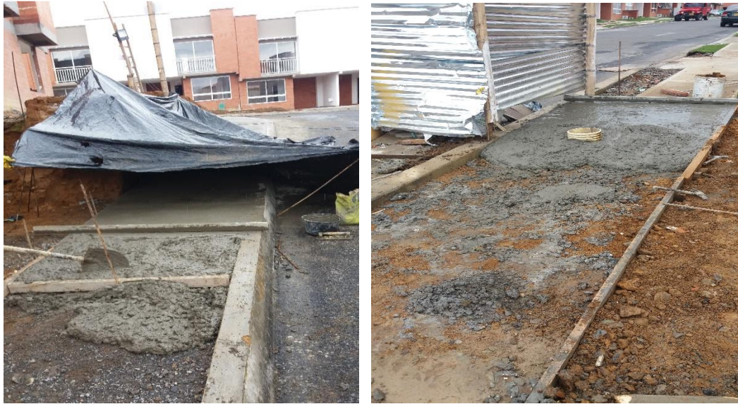
Ilustración 7. Vaciado del concreto fuente: autor
