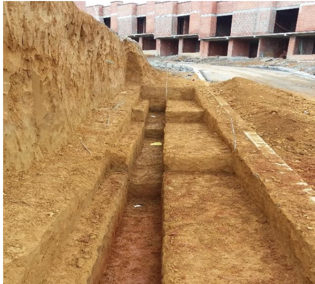
Ilustración 12. Excavación y nivelación manual Fuente: Autor
