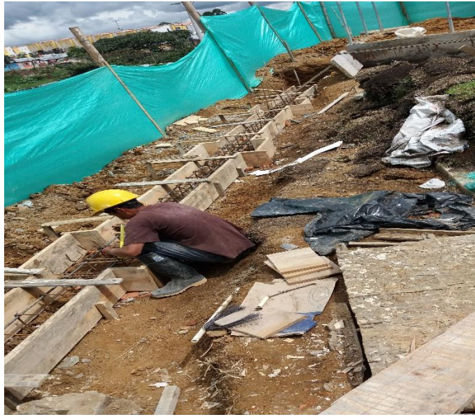
Ilustración 58. Encofrado para fundición de base de muro de cierre
