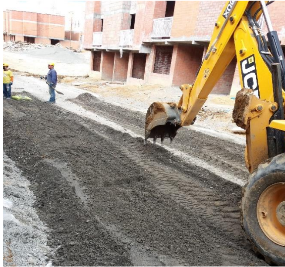
Ilustración 40. Extensión de cemento en capa de base Fuente: autor
