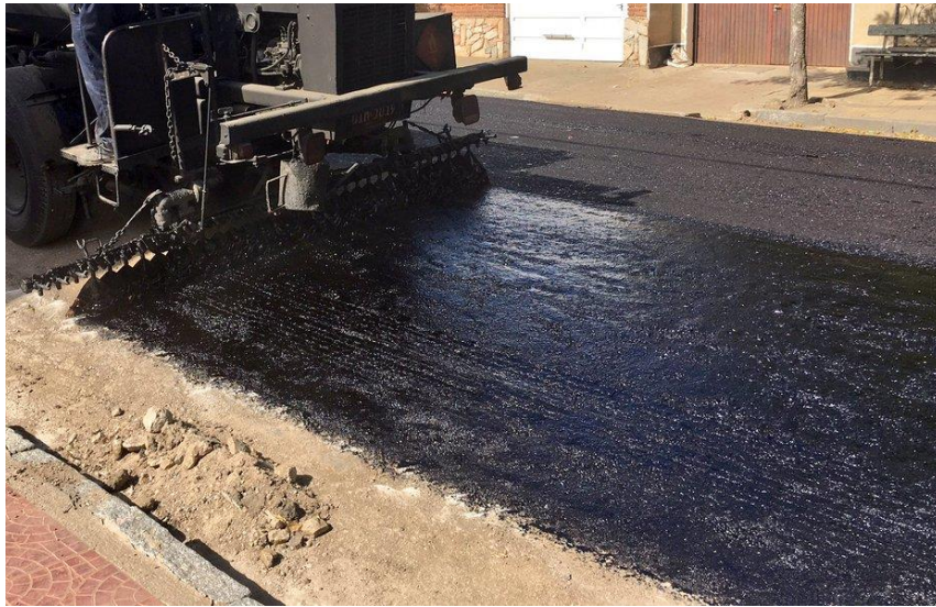
Ilustración 46. Riego de imprimación
