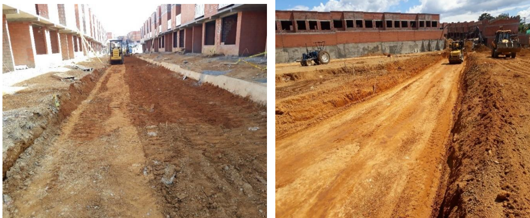
Ilustración 33. Compactación con rodillo liso Fuente: autor
