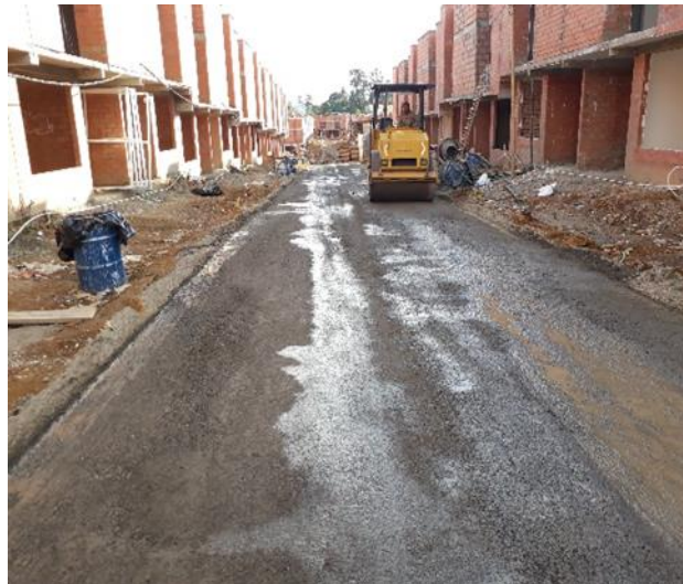
Ilustración 41. Extensión de cemento en capa de base Fuente: autor
