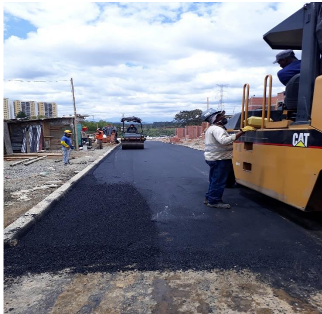
Ilustración 48. Compactación de pavimento de rodillo liso
