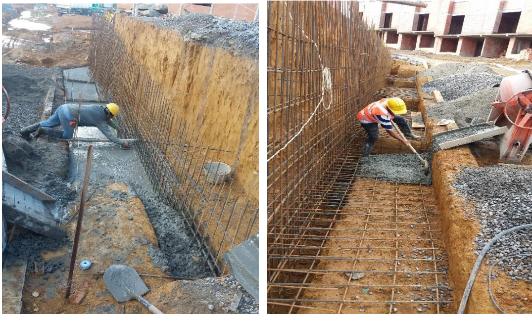
Ilustración 14. Vaciado de concreto Fuente: Autor
