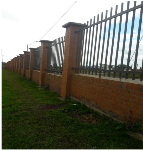
Ilustración 60. Instalación de reja sobre mampostería de muro de cierre
