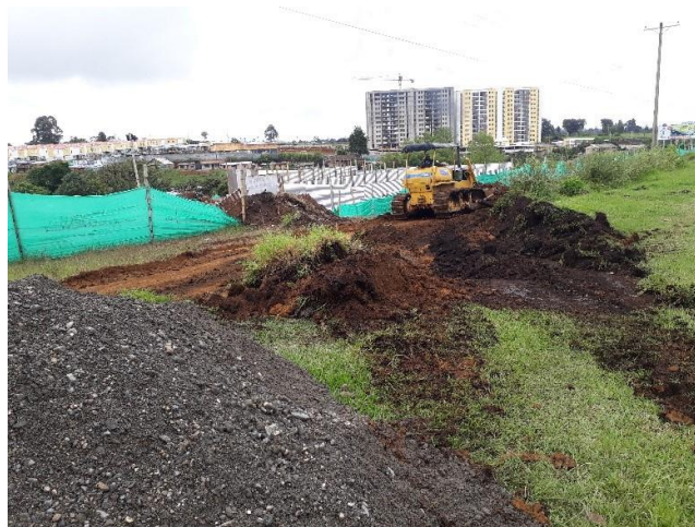
Ilustración 22. Descapote de terreno con retroexcavadora
