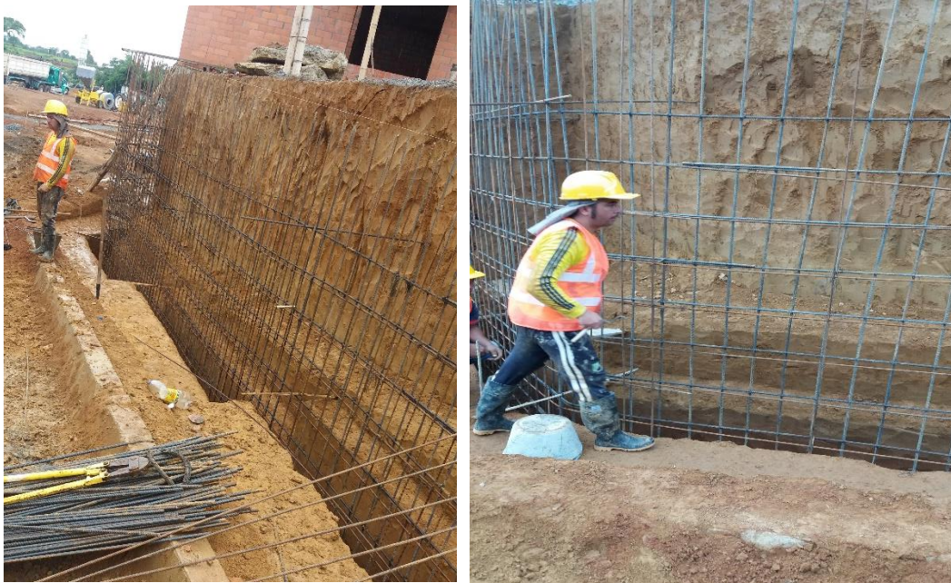
Ilustración 13. Armado de acero Fuente: Autor
