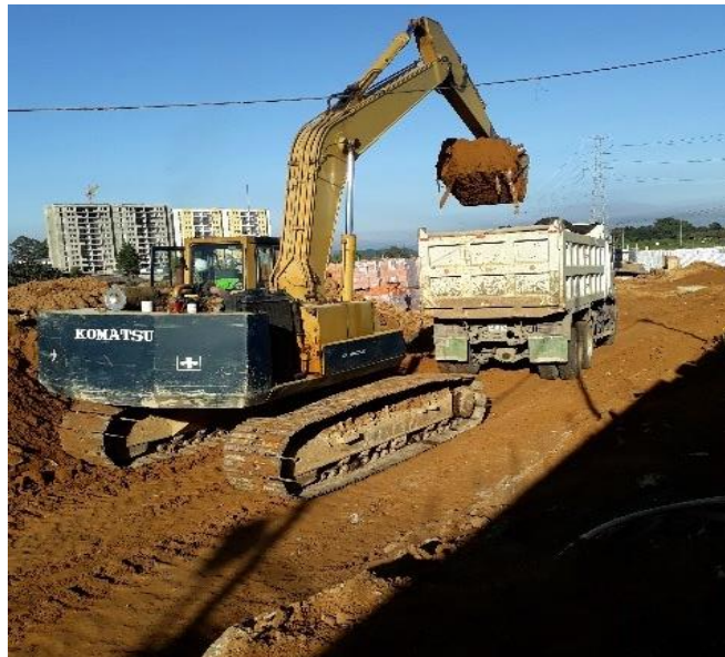
Ilustración 30. Cargue de material Fuente: autor
