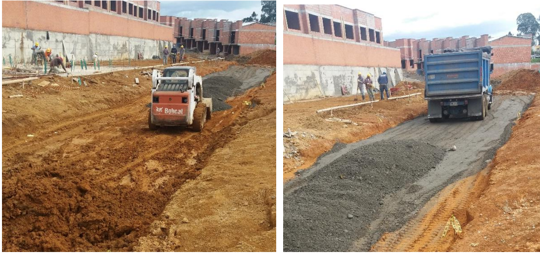
Ilustración 25. Extendido de sub base
