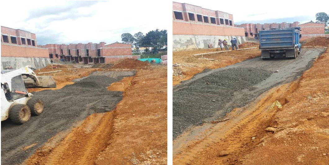
Ilustración 34. Extensión de sub-base Fuente: autor
