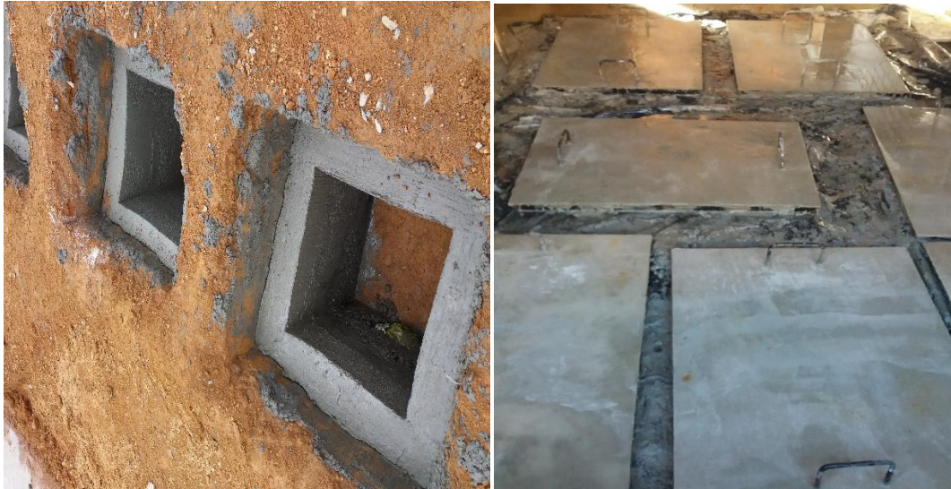
Ilustración 57. Proceso constructivo de cajas de inspección
