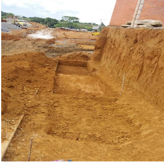
Ilustración 11. Localización y replanteo de muro de contención Fuente: Autor
