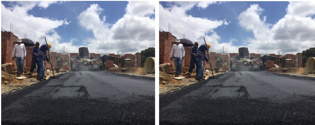
Ilustración 47. Mezcla asfáltica con finisher
