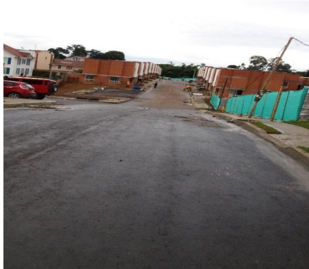
Ilustración 15. estado de vías de la manzana F Fuente: Autor
