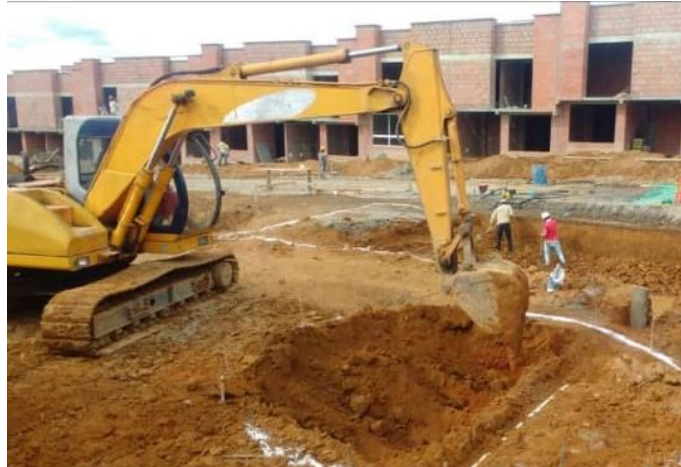
Ilustración 23. Corte de Terreno y taludes Fuente: Autor
