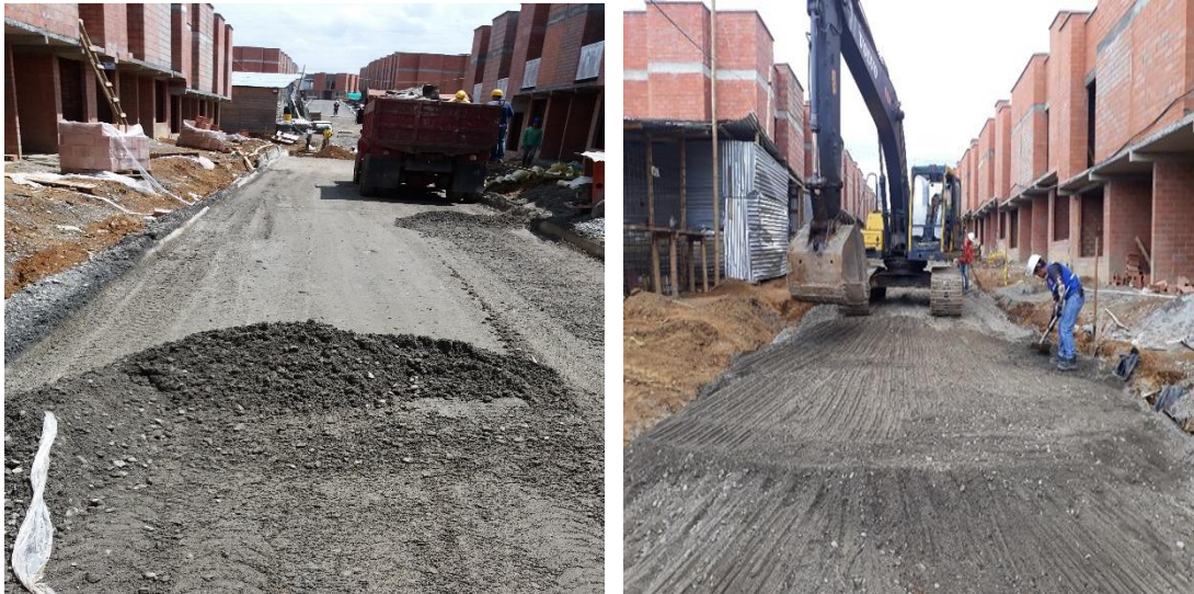
Ilustración 39. Extensión de base Fuente: autor
