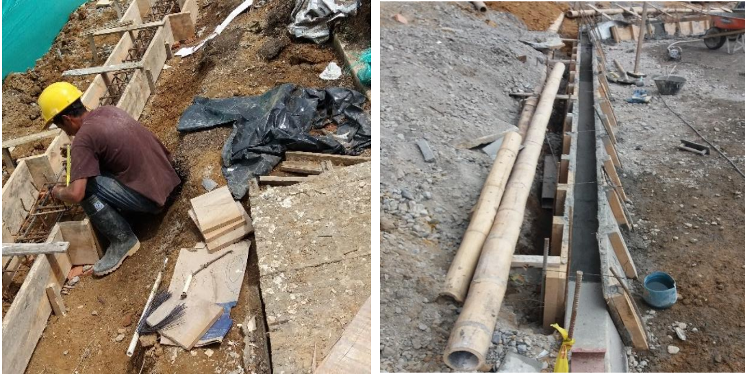
Ilustración 6. Instalación de formaleta fuente: autor
