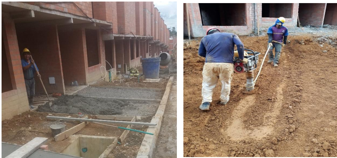
Ilustración 5. Conformación y compactación de suelo fuente: autor
