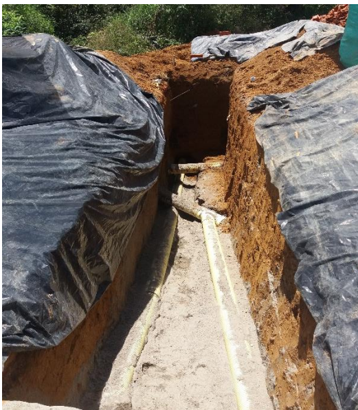
Ilustración 55. Encamado e instalación de tubería
