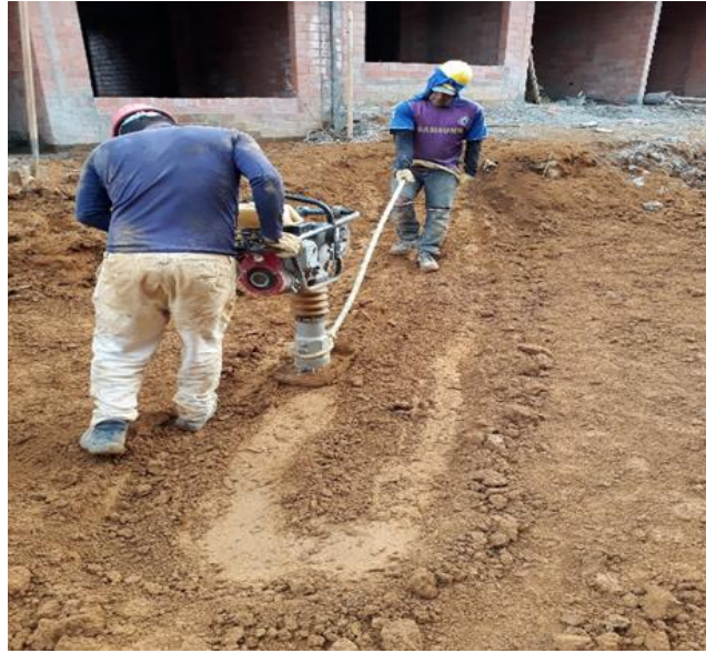
Ilustración 56. Compactación con pata de cabra
