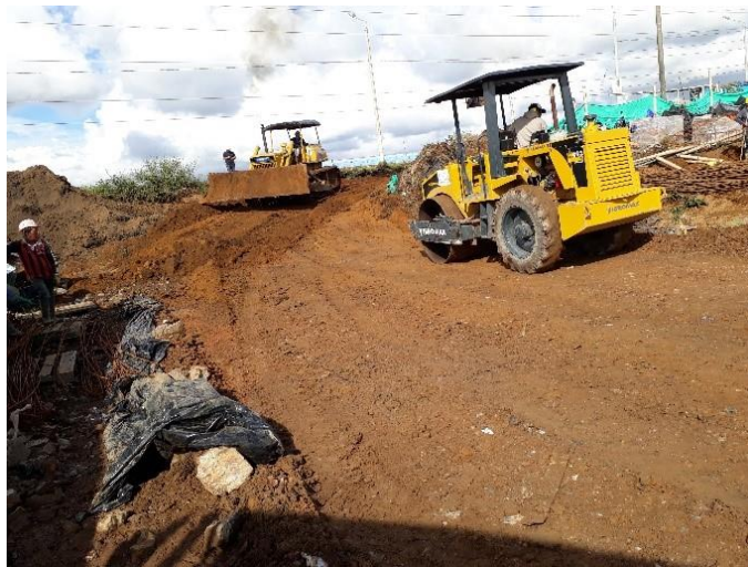
Ilustración 24. Relleno y compactación con rodillo liso Fuente: Autor
