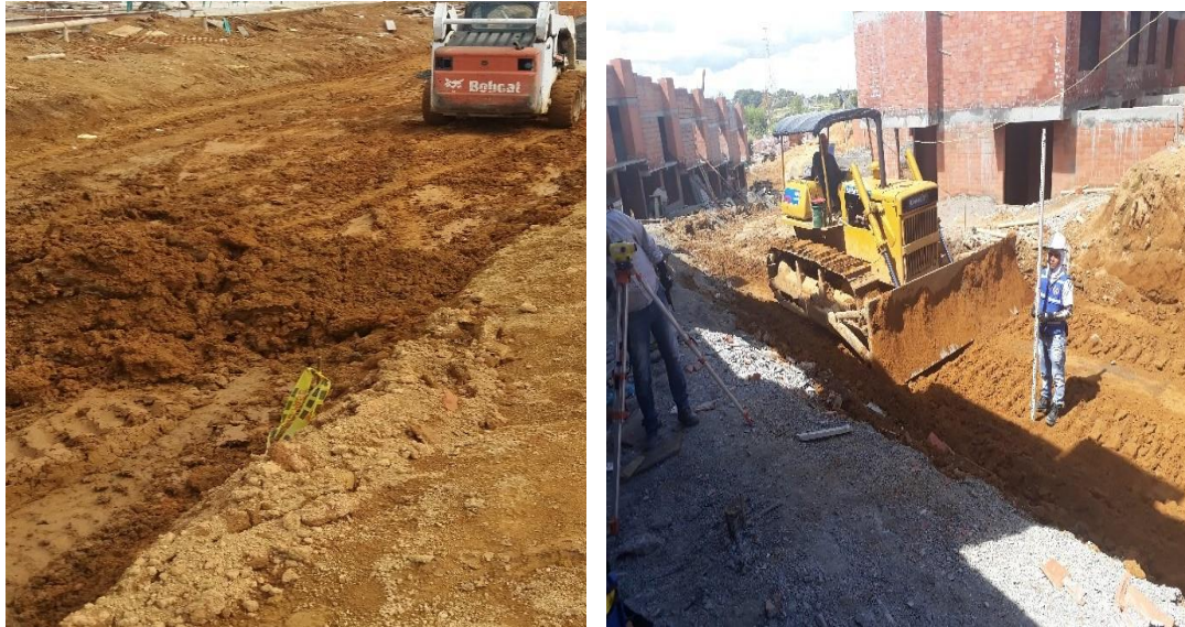
Ilustración 31. Nivelación de la subrasante Fuente: autor
