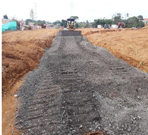
Ilustración 35. Nivelación de sub-base con motoniveladora
