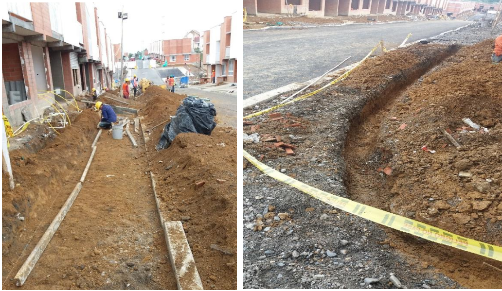
Ilustración 4. Localización y replanteo de andenes y sardineles fuente: autor
