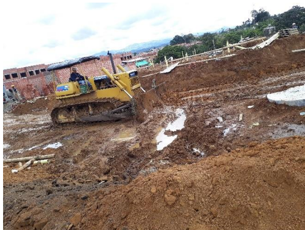
Ilustración 28. Escarificación y limpieza
