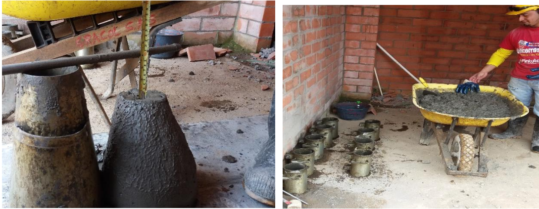
Ilustración 9. Toma de muestras y Control de asentamiento del concreto fuente: autor
