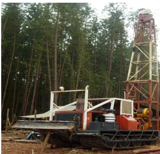
Foto No.3 Torre de madereo koller K-300
