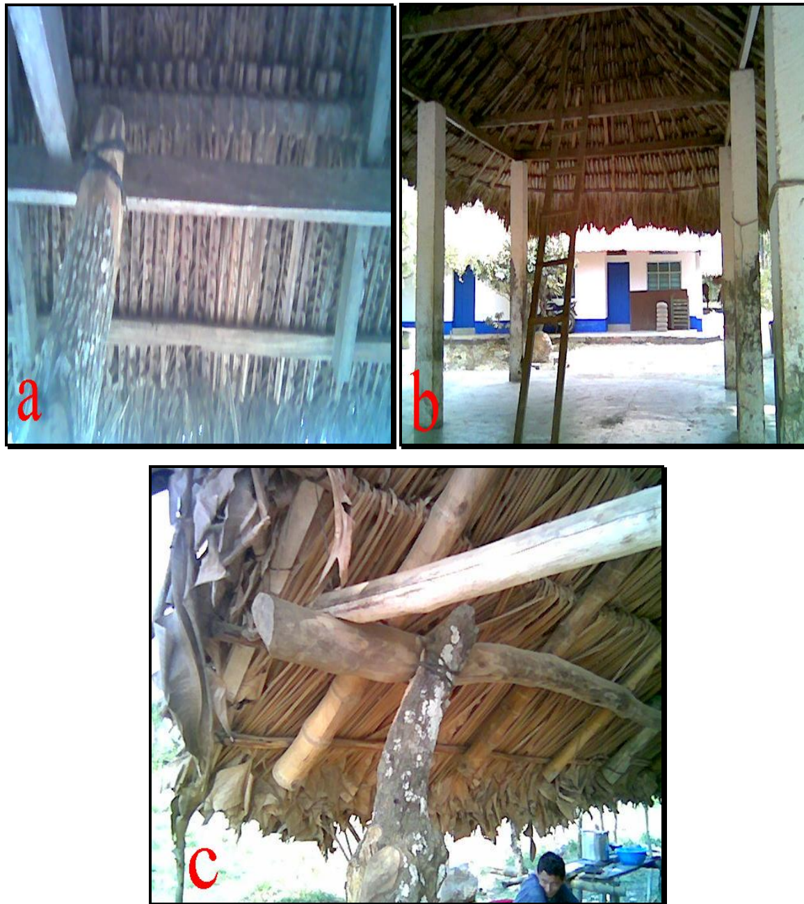
Foto 8. Diferentes tipos de trenzas y material en los techos. a y b palma amarga ( Sabal mauritiiformis ) y c. empalme con bijao ( Calathea cf. anocephala ).
