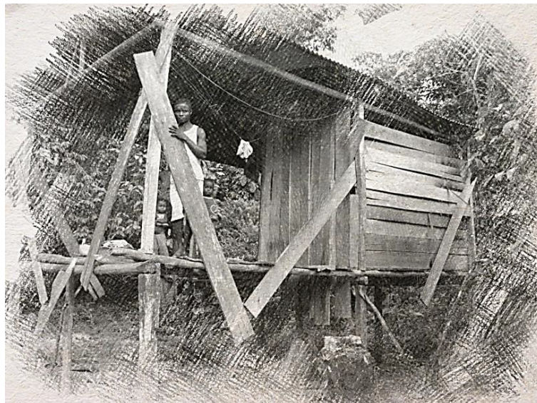
Imagen 28: Segundo momento de la casa tradicional, palafito con techo de zinc y cerramiento parcial en madera. El autor.
