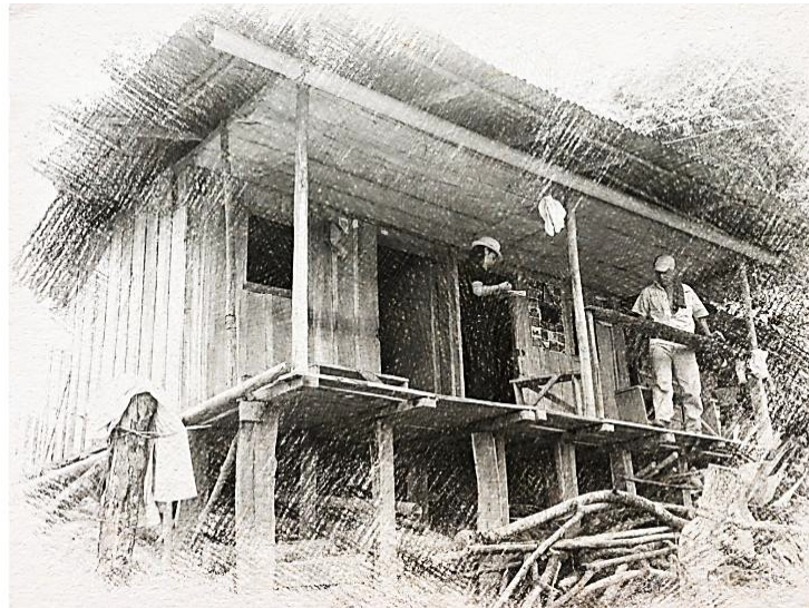
Imagen 4: Vivienda sobre pilares vereda La Turbina, corregimiento de Mindalá. Suárez. El autor.
