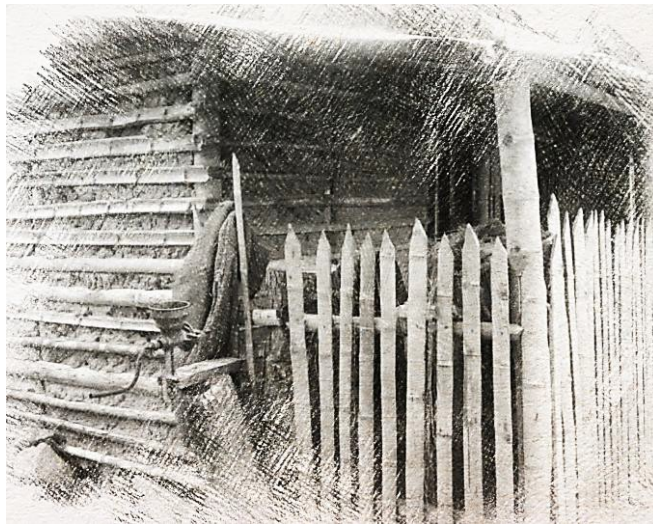
Imagen 33: Casa en bahareque con estructura en guadua. La Turbina. El autor.
