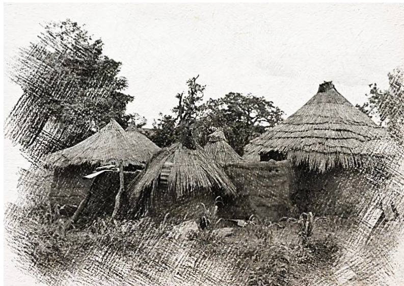
Imagen 21: Casa Taberma en Togo construida en tierra y fibras vegetales. Ed. El autor. Disponible en: http://agoras.typepad.fr/regard_eloigne/batammariba/
