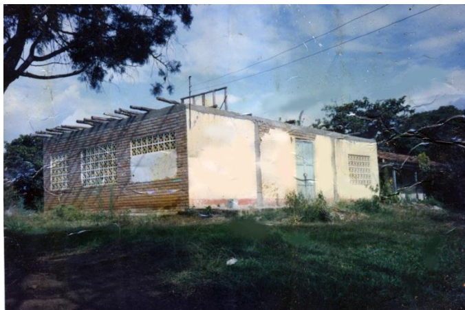
Foto 43. Primera Planta física de la escuela hecha en cemento
