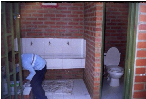
Fotos 50, 51. Baños y Lavamanos
