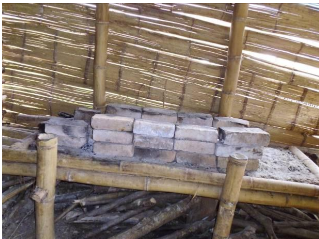
Foto N° 26. Fogón tradicional, construido con guadua y ladrillos. Angela Vela. 2103
