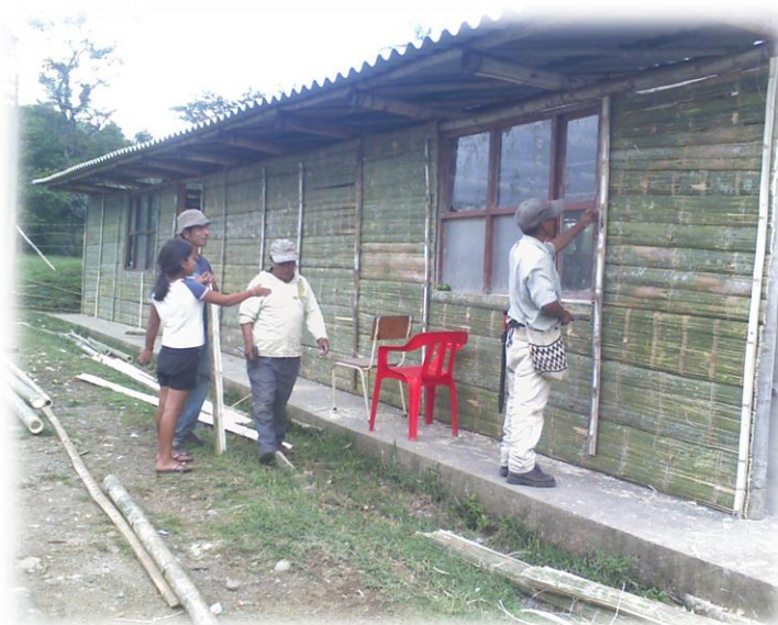
Construcción del salón para la escuela
