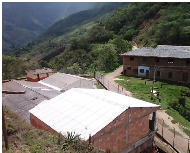
Foto N° 7. E.R.M. Loma Gorda. Fuente Lourdes T: 2016.
