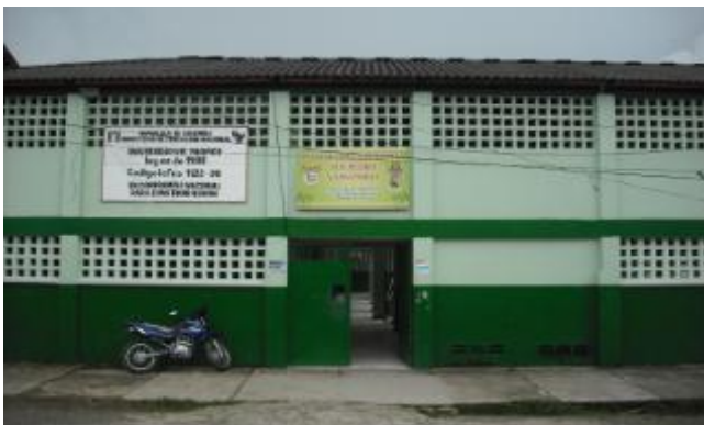
Fotografía 2. Fachada Institución Educativa San Pedro y San Pablo
