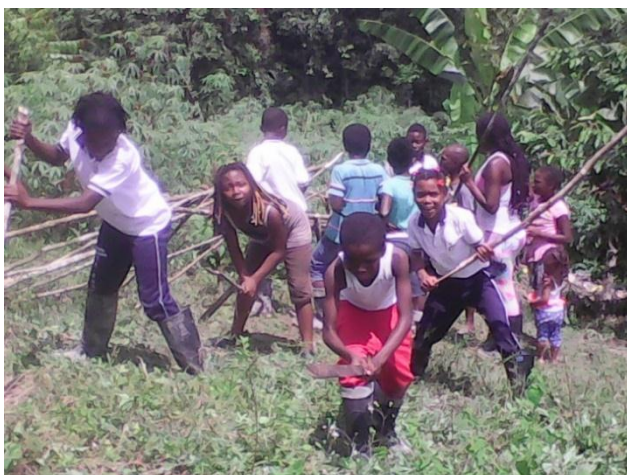
Foto.N 0 .16. De adecuación de terreno para la construcción de una azotea
