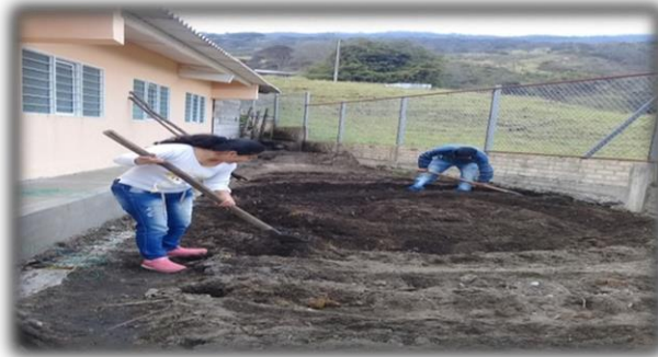
Foto No 22. Construcción del tul
