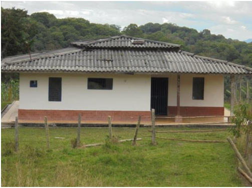
Foto n°6. Puesto de Salud.
