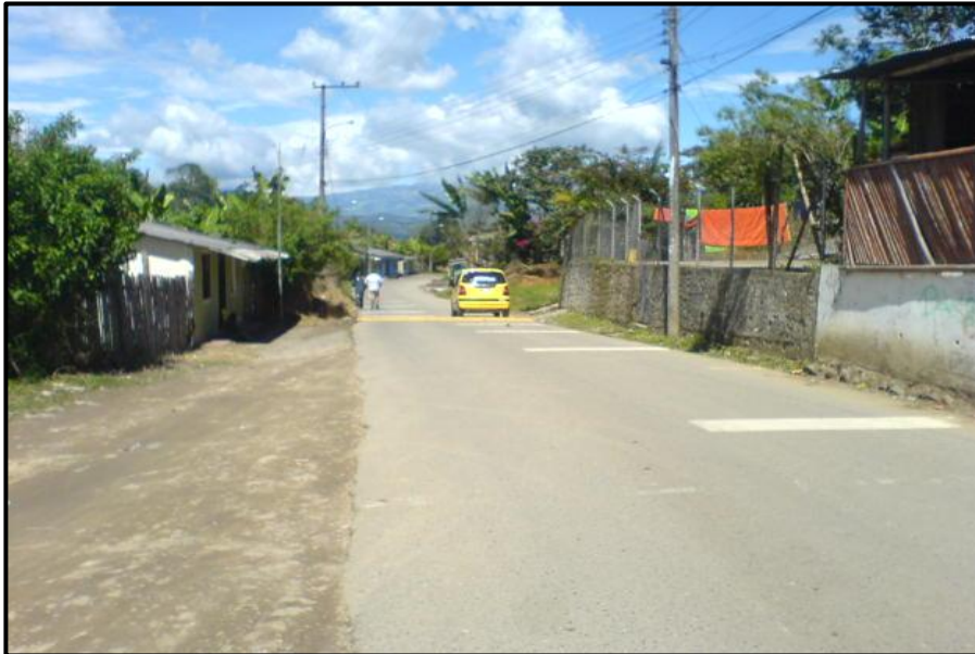
Fotografía N° 6. Estado de la vía sector Julumito
