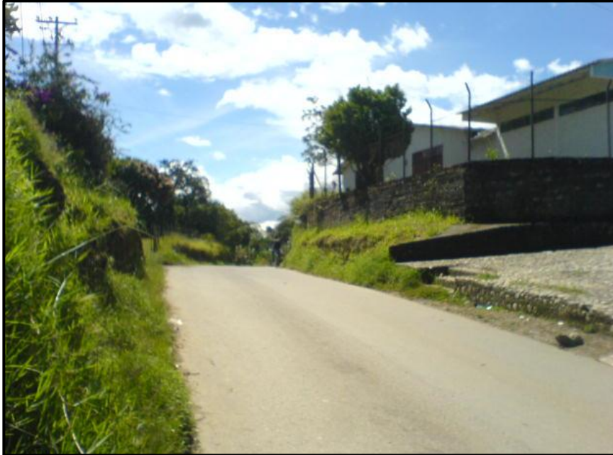
Fotografía N° 7. Estado de la vía sector Julumito Alto
