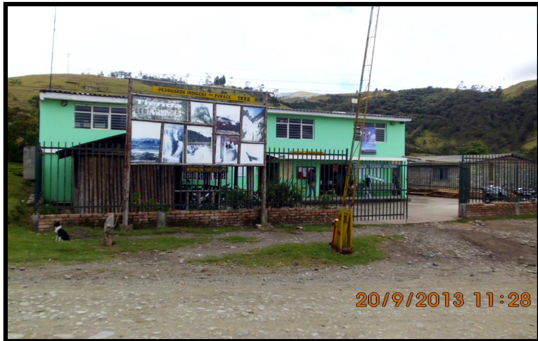
Fotografía 9. Casa del cabildo, ubicada en la vereda Chapio, Fuente: Elaboración propia.
