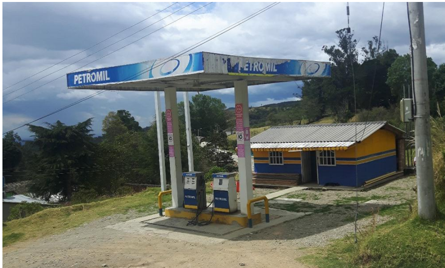
Imagen 11. Estación de Servicios.
