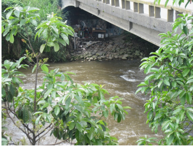
Tomar el puente como vivienda (paso del Río Cauca sobre la Autopista)
