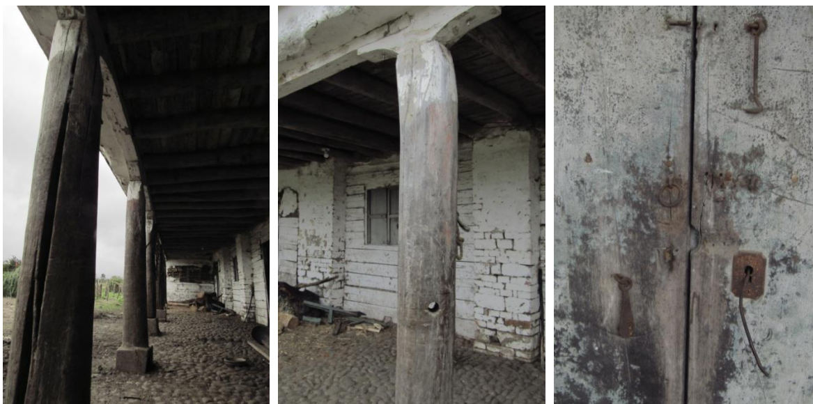
Ilustración 31: Trabajo de la madera, columnas principales y detalle de puerta, hacienda Paletará en la actualidad. (Archivo personal)
