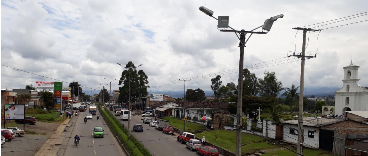
Imagen 59. Puente Elevado de Villa del Viento
