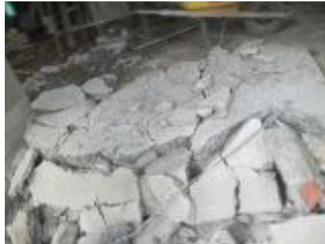
b) Remoción de pisos en edificio de Ingenierías.
