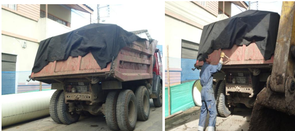
Figura 11. Transporte de material de demoliciones y escombros
