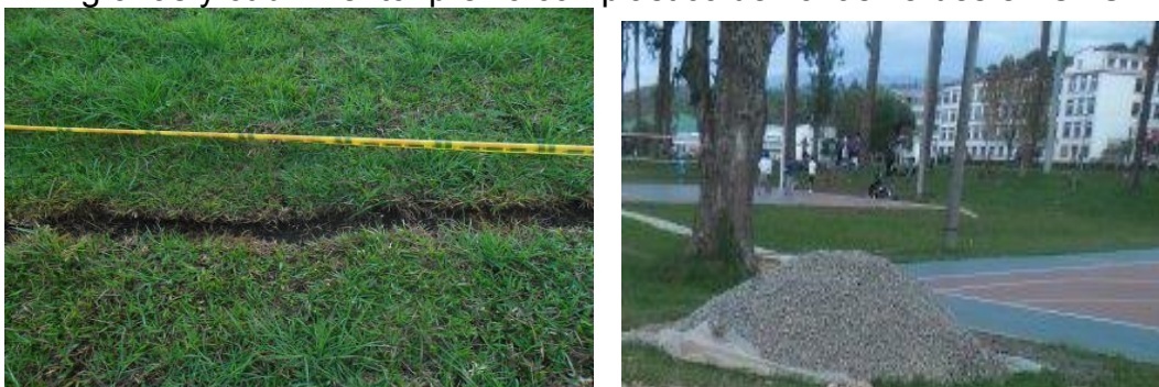
Figura 8. Restauración de cobertura vegetal en Facultad de Ciencias Agrarias y cubrimiento previo con plástico de zonas verdes en CDU.
