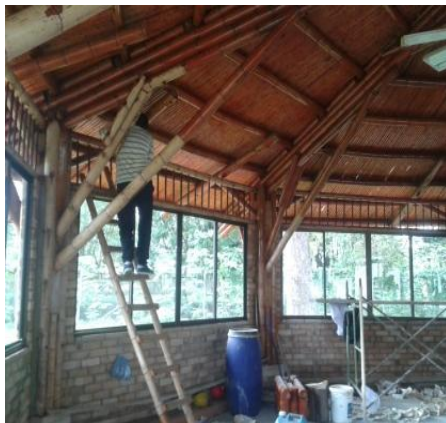
a) Pintura de instalaciones CDU
