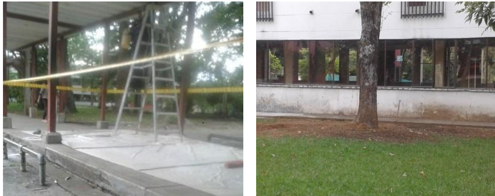
Figura 7. Protección del suelo con plástico en proceso de pintura y restauración del suelo en edificio de Ingenierías.
