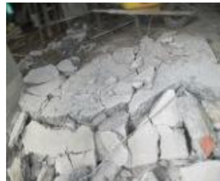
Figura 2. Remoción de pisos en edificio de Ingenierías.
