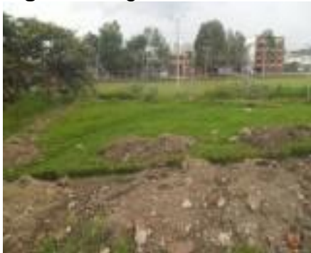
a) Remoción de la capa vegetal en CDU.
