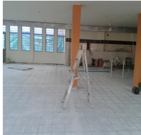
b) Adecuación de pisos en Facultad de salud
