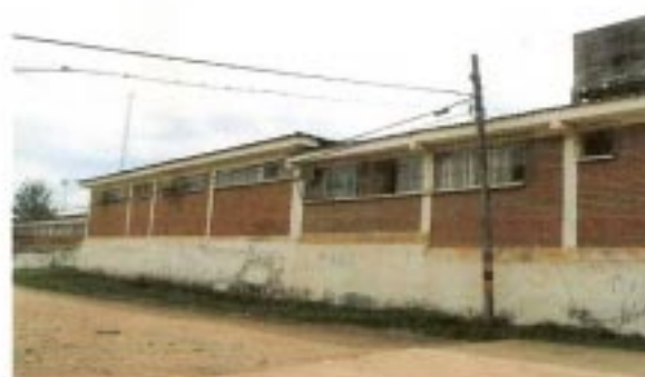
FACHADA POSTERIOR BLOQUECIRUGIA- PARTOS-URGENCIAS
