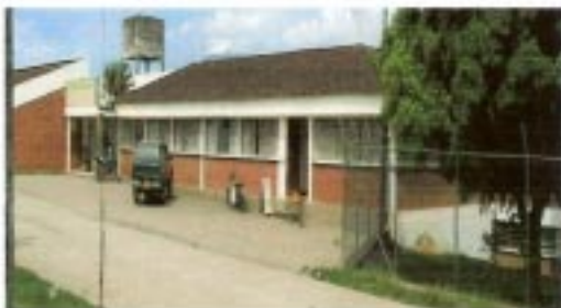
FACHADA -VISTA SUR OCCIDENTAL
