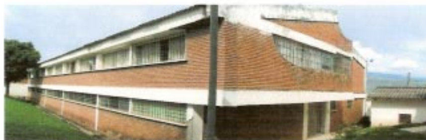
VISTA SUR - OCCIDENTAL SOTANO (SERVICIOS GENERALES) Y PRIMER PISO (HOSPITALIZACION) - DERECHA-CUARTO PLANTA ELECTRICA
