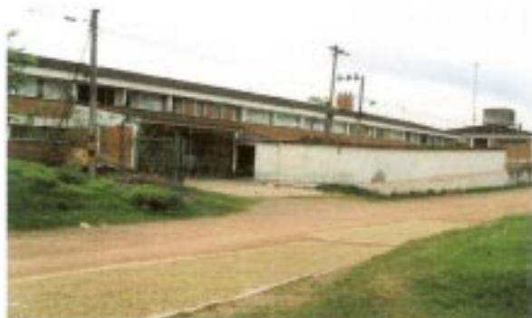
FACHADA POSTERIOR -ENTRADA PARQUEADERO SOTANO
