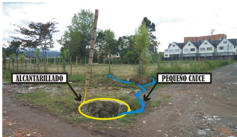
Figura 50. Pequeño cauce del humedal Olímpica que se interna en el sistema de alcantarillado
