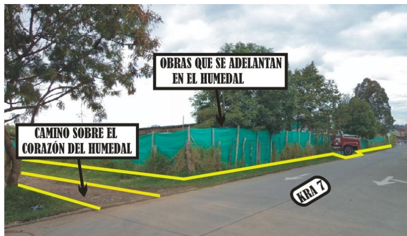
Figura 52. Obras civiles sobre el humedal Olímpica
