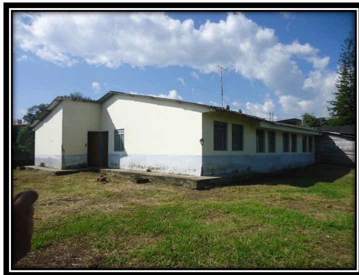
Fotografía N° 3. Hospital corregimiento Siberia.
