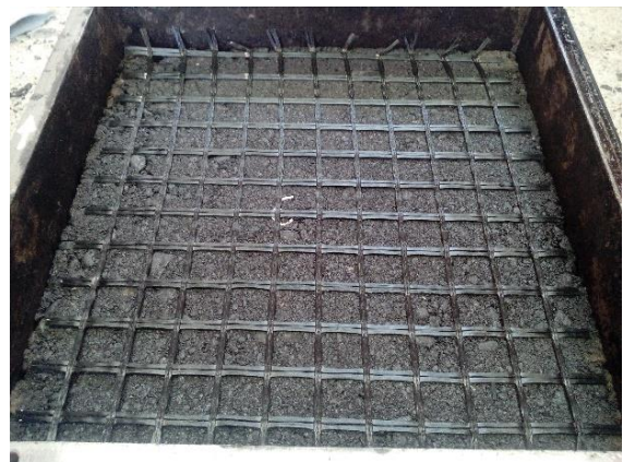
Fotografía 12. Conformación primera capa de mezcla asfáltica
